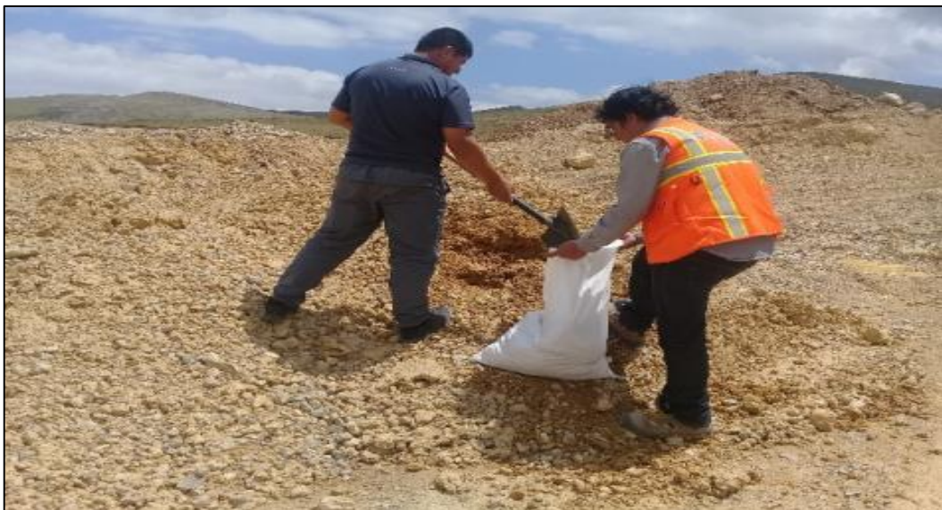
Figura N° 5: Adquisición del material granular de la Cantera Mitupampa
