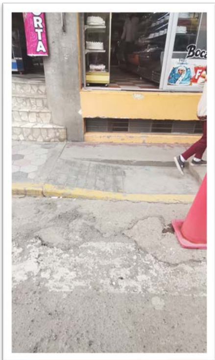
RAMPAS DISEÑADAS EN LAS VEREDAS ESTRECHAS, Y NO EXISTE UN DISEÑO PROPORCIONAL ENTRE VIA Y VEREDA.
