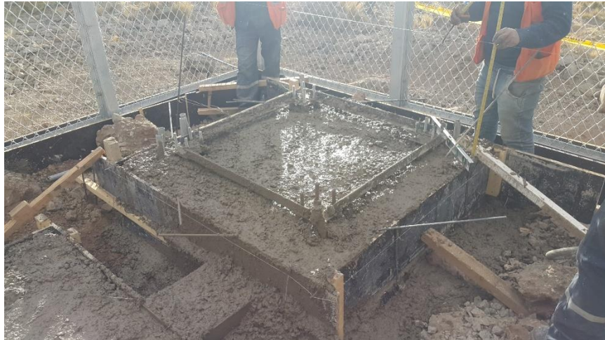
Fuente propia . : vaciado de concreto en sitio
