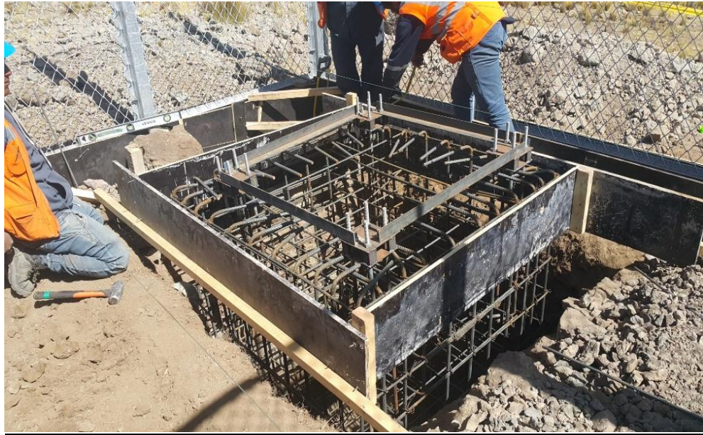
Fuente propia : colocación de acero a 4200 msnm zapata para torre autosoportada
