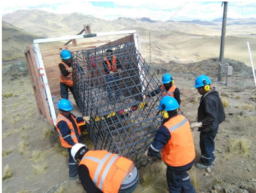
Fuente propia. : acarreo de zapata hacia la zona de trabajo desde campamento
