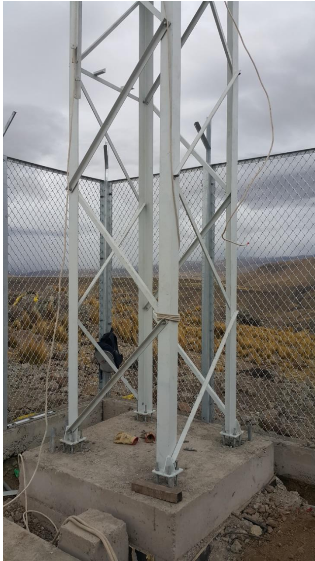
Fuente propia.. armado de torre autosportada en Sibayo - chungara Arequipa
