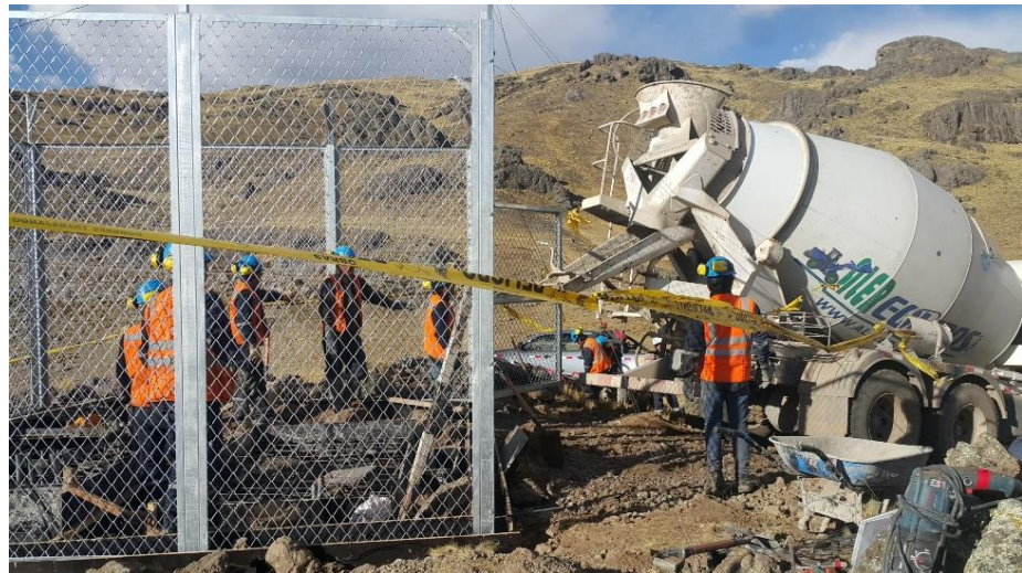
Fuente propia : colocación de concreto proporcionado por concretera en sitio sibayo
