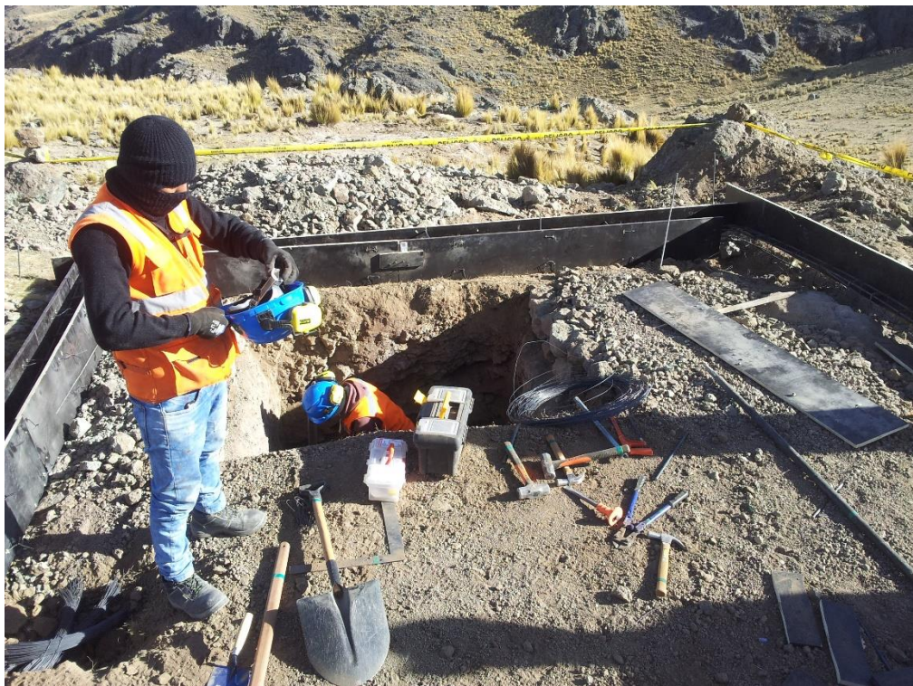
Fuente propia. Ejecución de habilitado y armado de encofrado para zapata sobrecimiento
