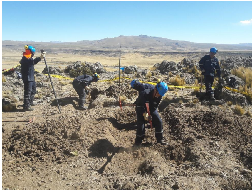
Imagen 02 : inicio de excavaciones
