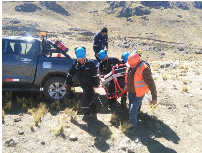
Fuente propia.: acarreo de grupo electrogeno a la zona de trabajo
