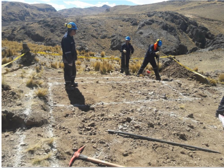
Imagen 01: trazo y replanteo para zapata
