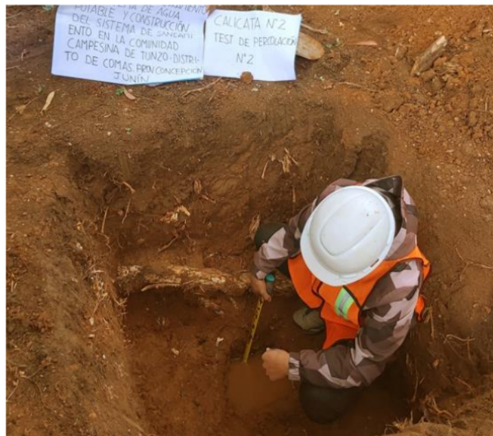
Imagen N° 02.- Realización del ensayo de test de percolación N°2, calcata N°2.
