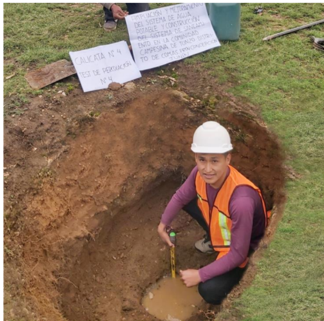
Imagen N° 04.- Realización del ensayo de test de percolación N°4, calicata N°4.
