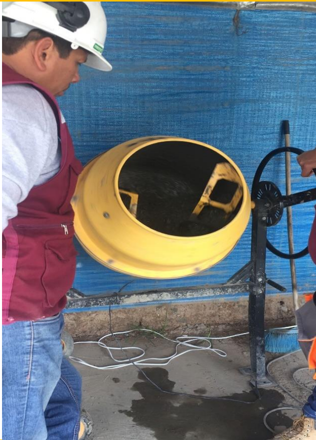
FOTOGRAFÍA N 19: MEZCLADO DE MATERIAL
