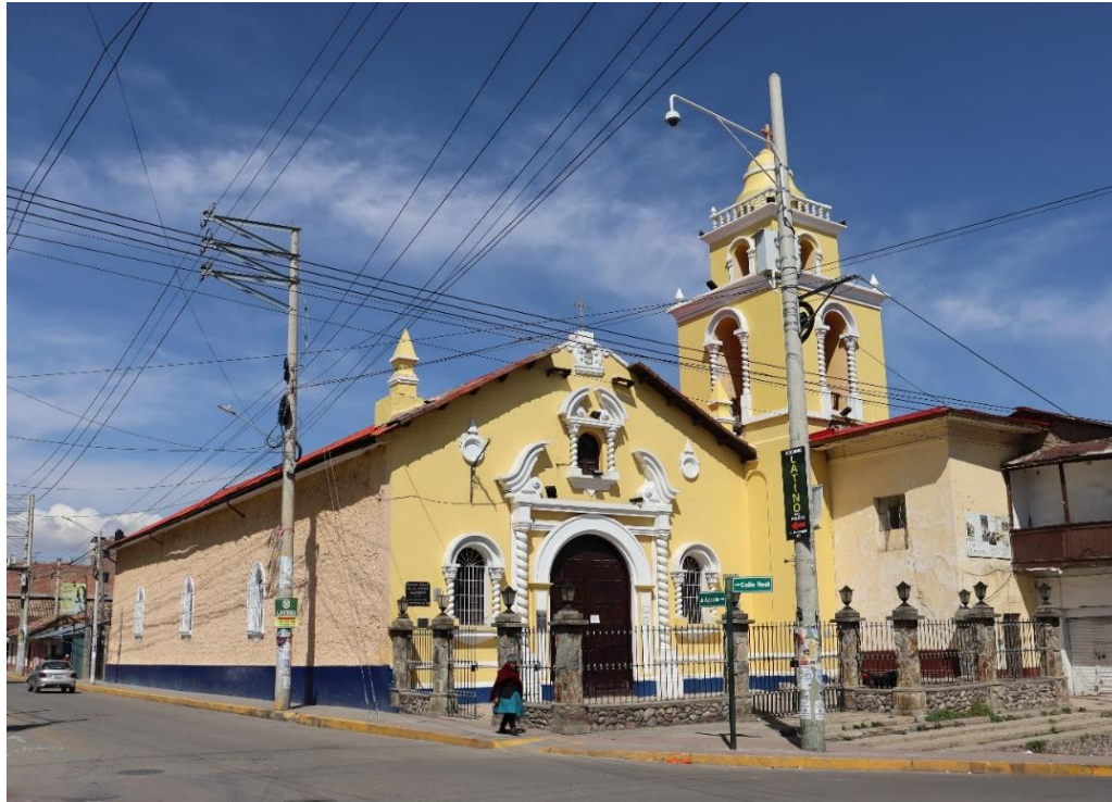
Figura 97 Fotografía frontal (CR 11): CALLE REAL N° 185
