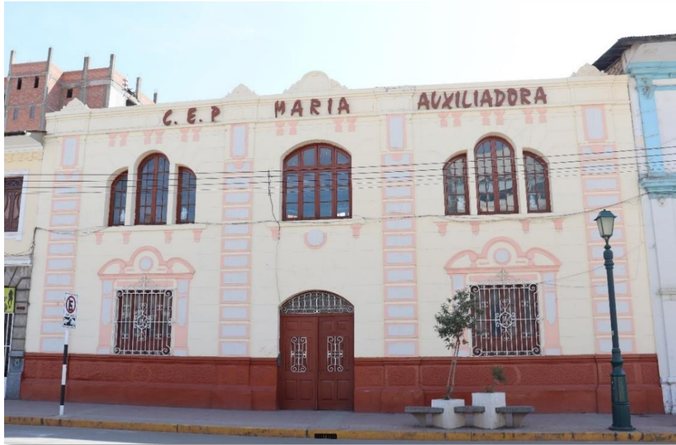
Figura 91 Fotografía frontal (CR 5): CALLE REAL N° 268
