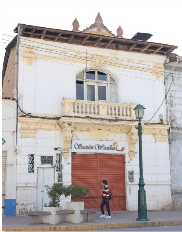
Figura 93 Fotografía frontal (CR 7): CALLE REAL N° 298 ESQ. JR. CUZCO
