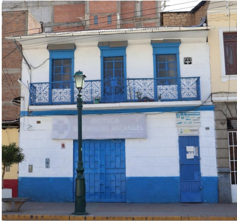
Figura 89 Fotografía frontal (CR 3): CALLE REAL N° 228
