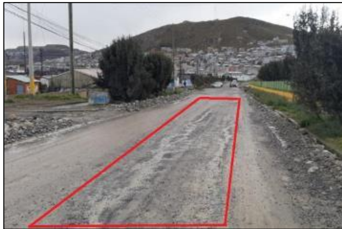
Figura No 03: Evidencia del porcentaje de afirmado existente.
