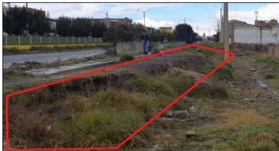
Figura No 06: Poste en desnivel a la vereda.
