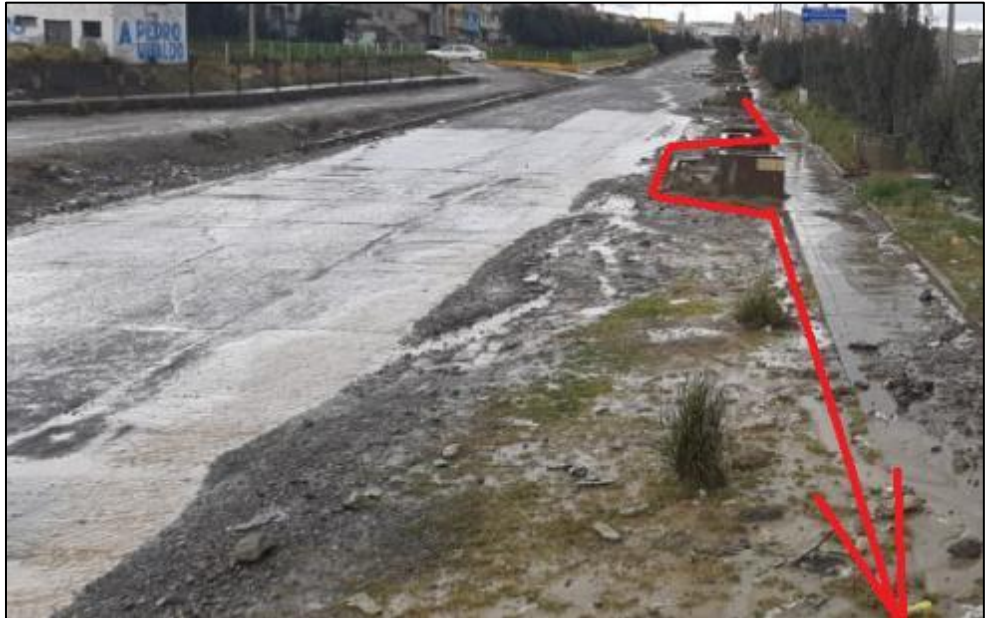
Figura No 07: Cunetas dañadas.
