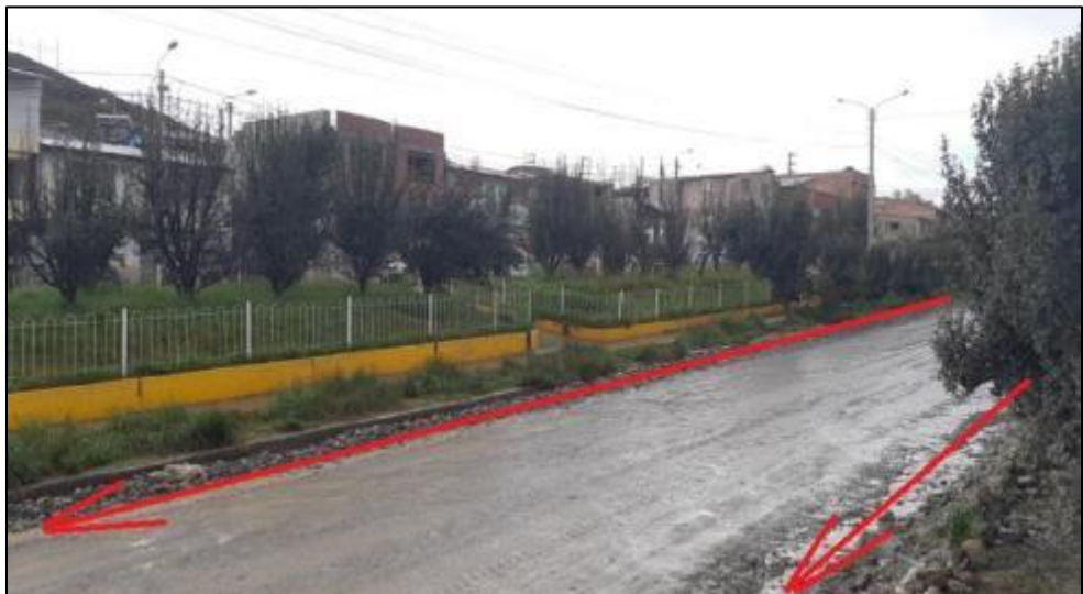
Figura No 08: Cunetas obstruidas.
