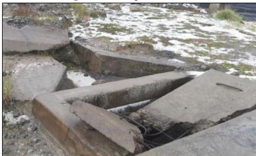
Figura No 12: Tapas destruidas.
