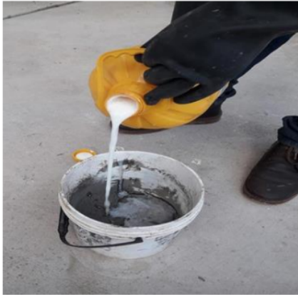
Aplicación del impermeabilizante Sika
