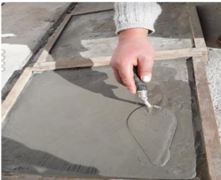
Aplicación del impermeabilizante
