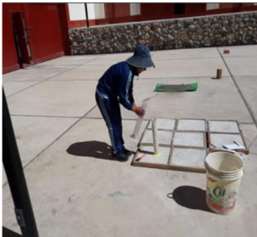
Aplicación de agua para el ensayo de permeabilidad.
