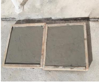
Estado final luego de la aplicación del impermeabilizante.
