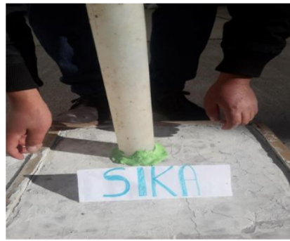
Ensayo de permeabilidad después de la aplicación del impermeabilizante de lechada de cemento
