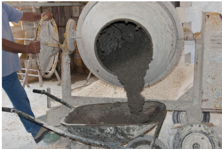
Figura 7 Proceso de mezclado del concreto Fuente: Elaboración propia.
