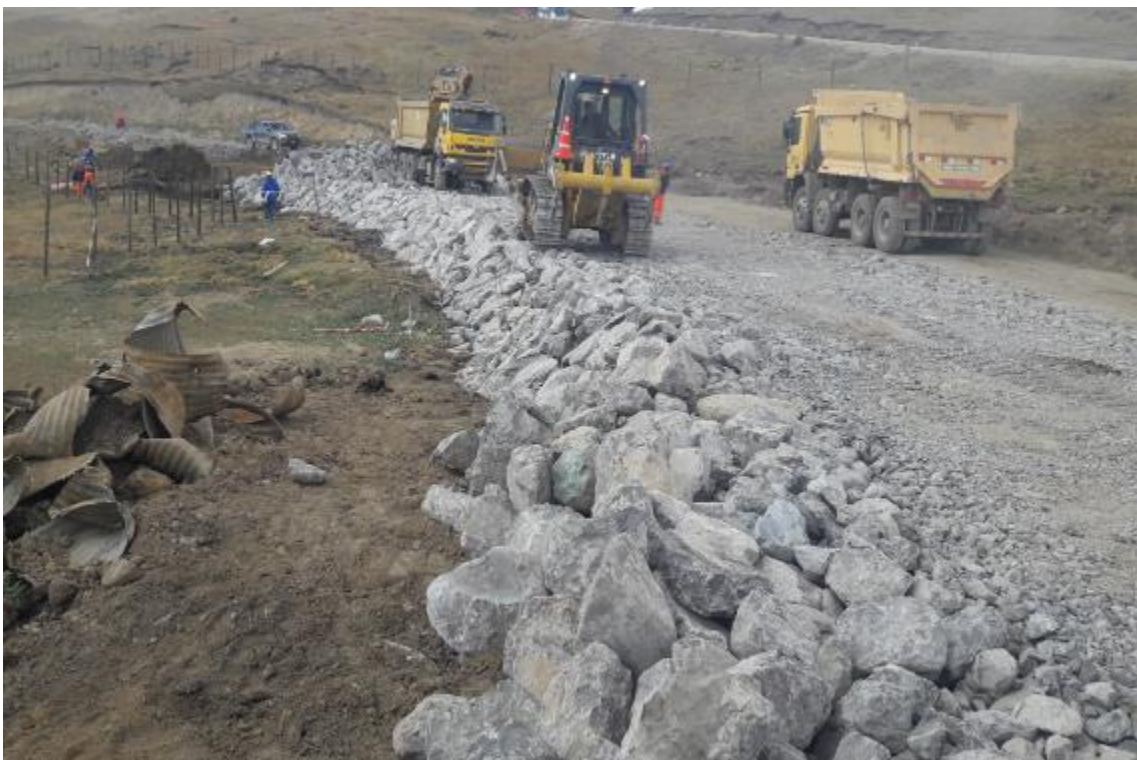
Foto N°16. Mejoramiento de Subrasante (espolones y colchones drenante)
