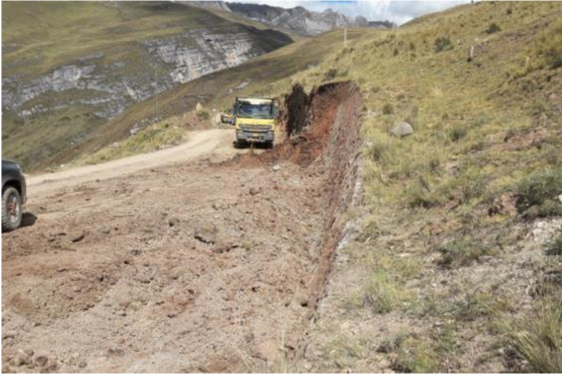
Foto N°3. Trabajos de movimiento de tierras. Zona de Corte
