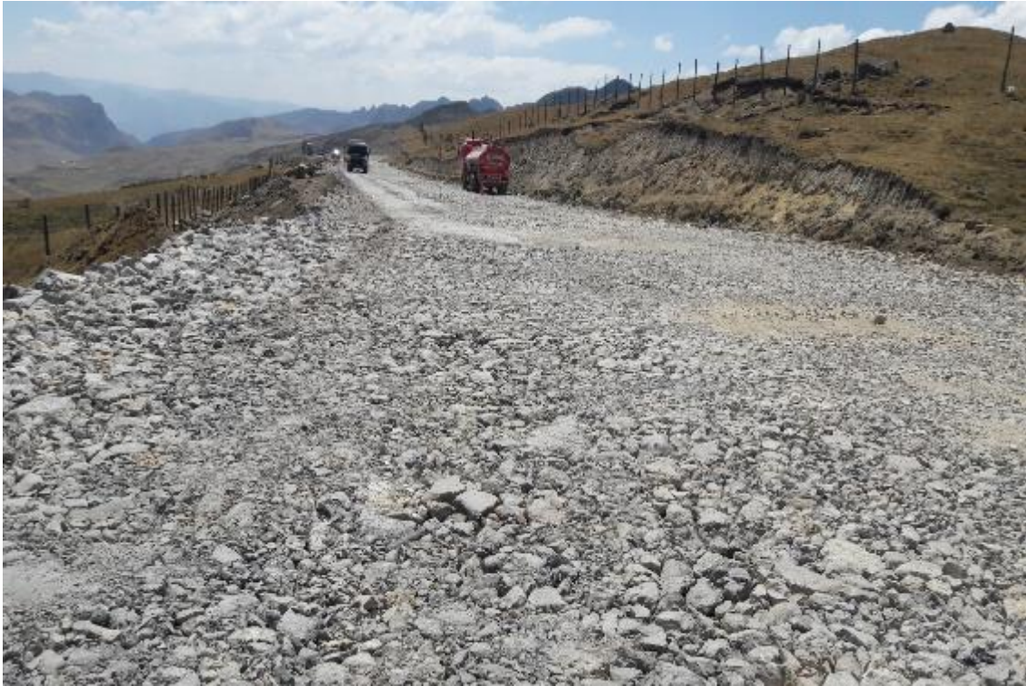
Foto N°25. Mejoramiento de Subrasante
