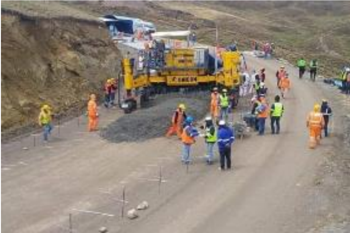
Foto N°43. Colocación de Pavimento Rígido
