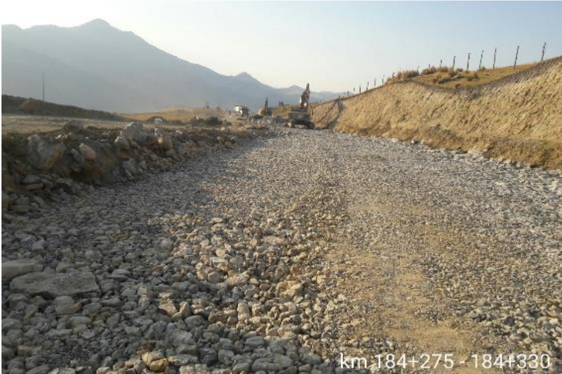
Foto N°19. Mejoramiento de Subrasante
