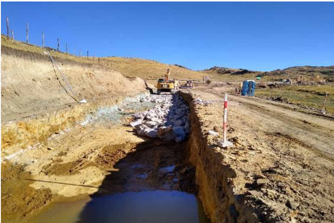
Foto N°12. Mejoramiento de Subrasante (espolones y colchones drenante)
