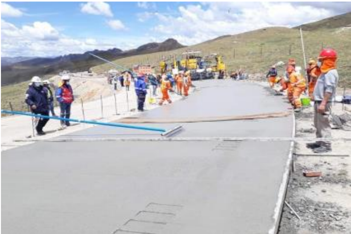
Foto N°44. Colocación de Pavimento Rígido
