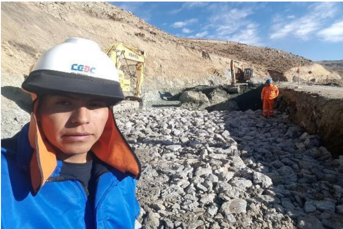
Foto N°14. Mejoramiento de Subrasante (espolones y colchones drenante)
