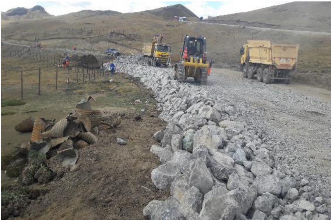
Foto N°20. Mejoramiento de Subrasante
