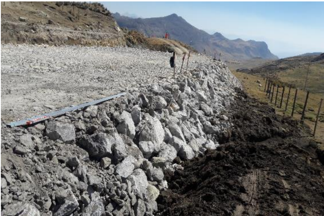
Foto N°24. Mejoramiento de Subrasante
