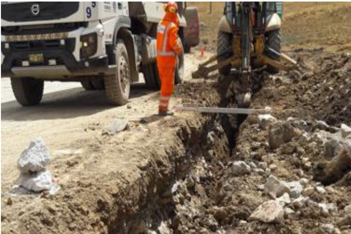
Foto N°38. Excavación para Subdrenes.
