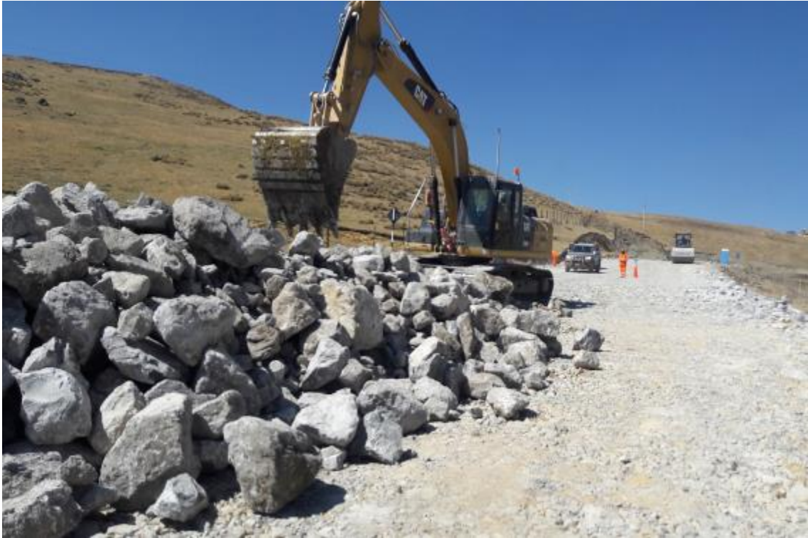
Foto N°17. Mejoramiento de Subrasante (espolones y colchones drenante)
