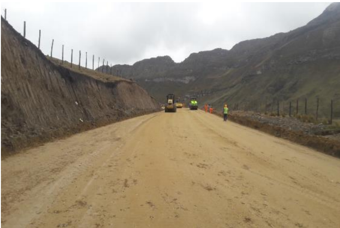
Foto N°32. Trabajos de explanaciones. Conformación de base
