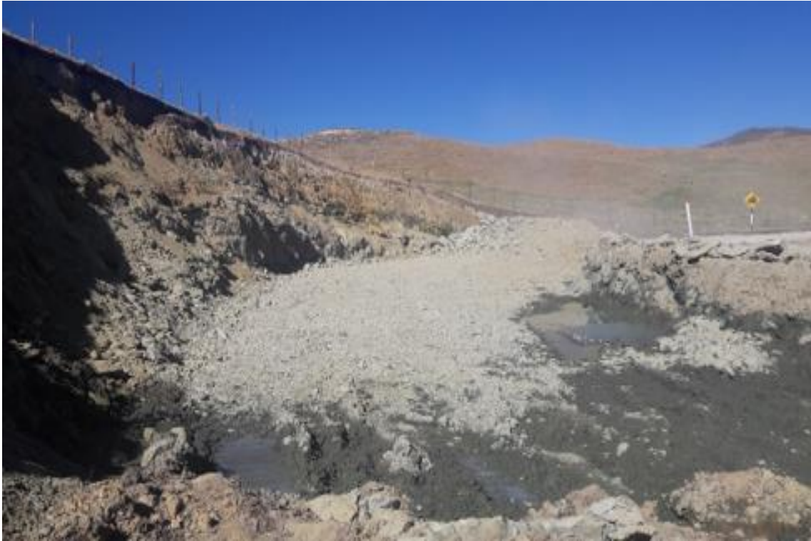
Foto N°5. Trabajos de movimiento de tierras. Mejoramiento de Subrasante
