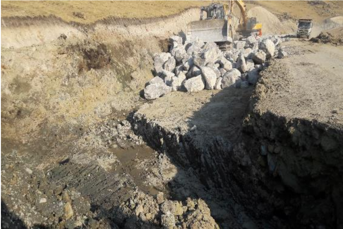
Foto N°13. Mejoramiento de Subrasante (espolones y colchones drenante)
