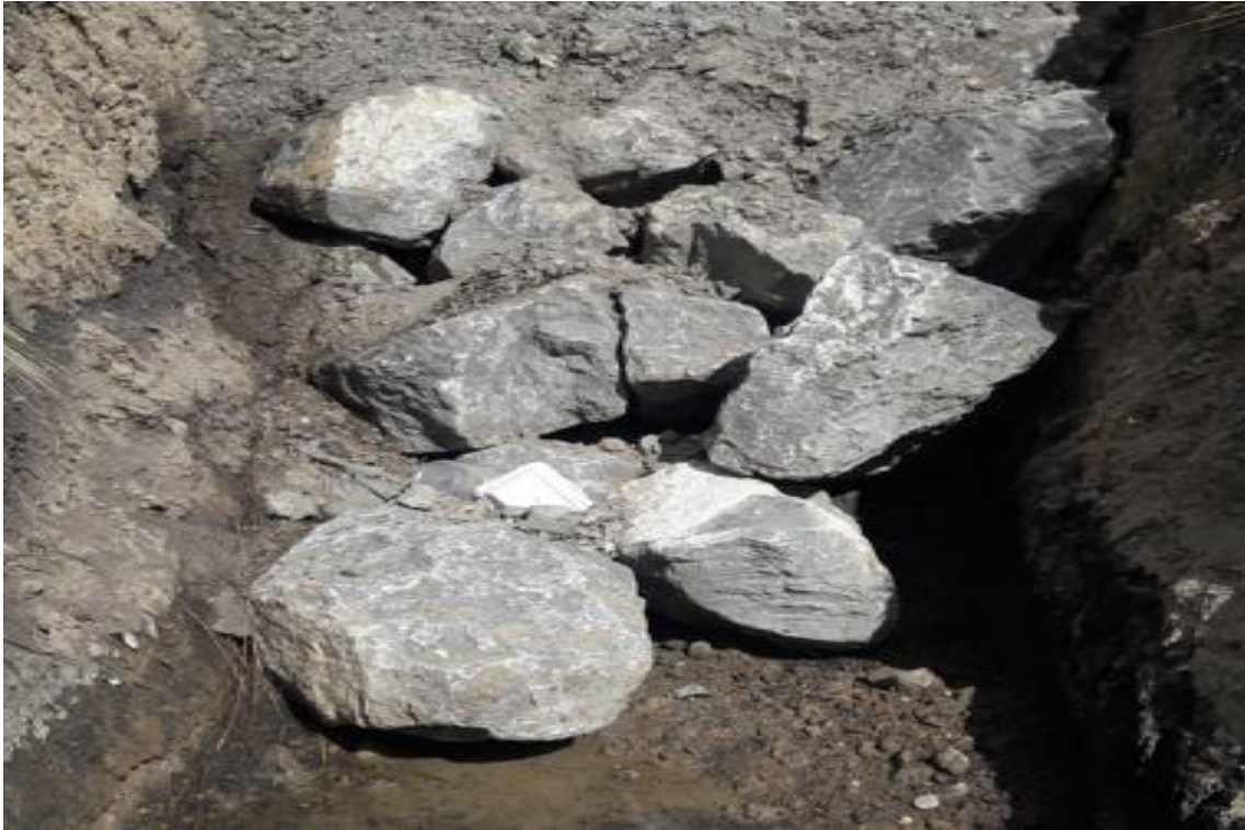
Foto N°27. Mejoramiento de Subrasante. Desfogue a través de espolones
