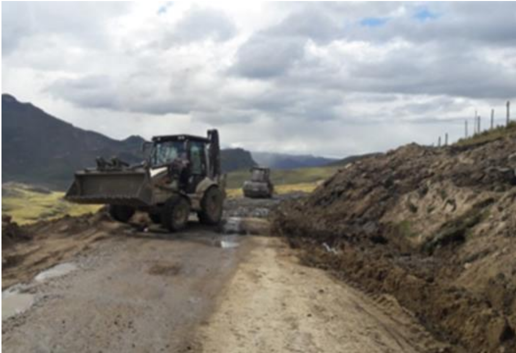
Foto N°1. Trabajos de movimiento de tierras. Zona de Corte
