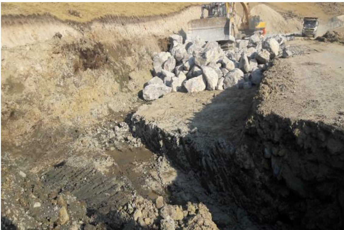
Foto N°10. Mejoramiento de Subrasante (espolones)
