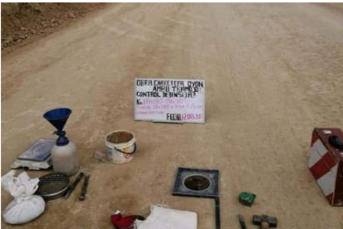
Foto N°34. Conformación de base. Control de Densidad de Campo.
