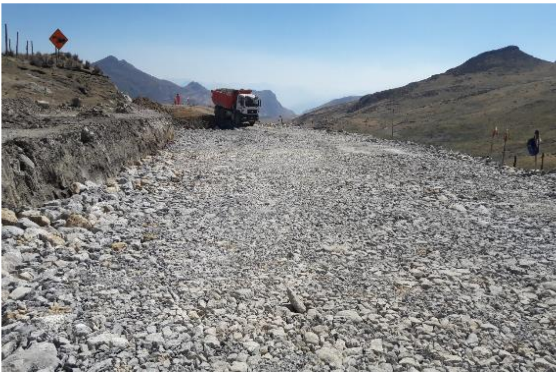
Foto N°22. Mejoramiento de Subrasante
