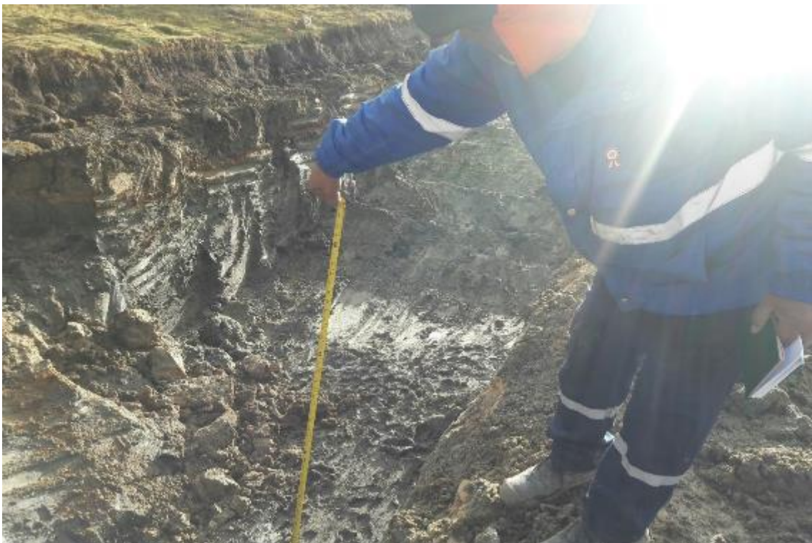
Foto N°6. Trabajos de movimiento de tierras. Mejoramiento de Subrasante
