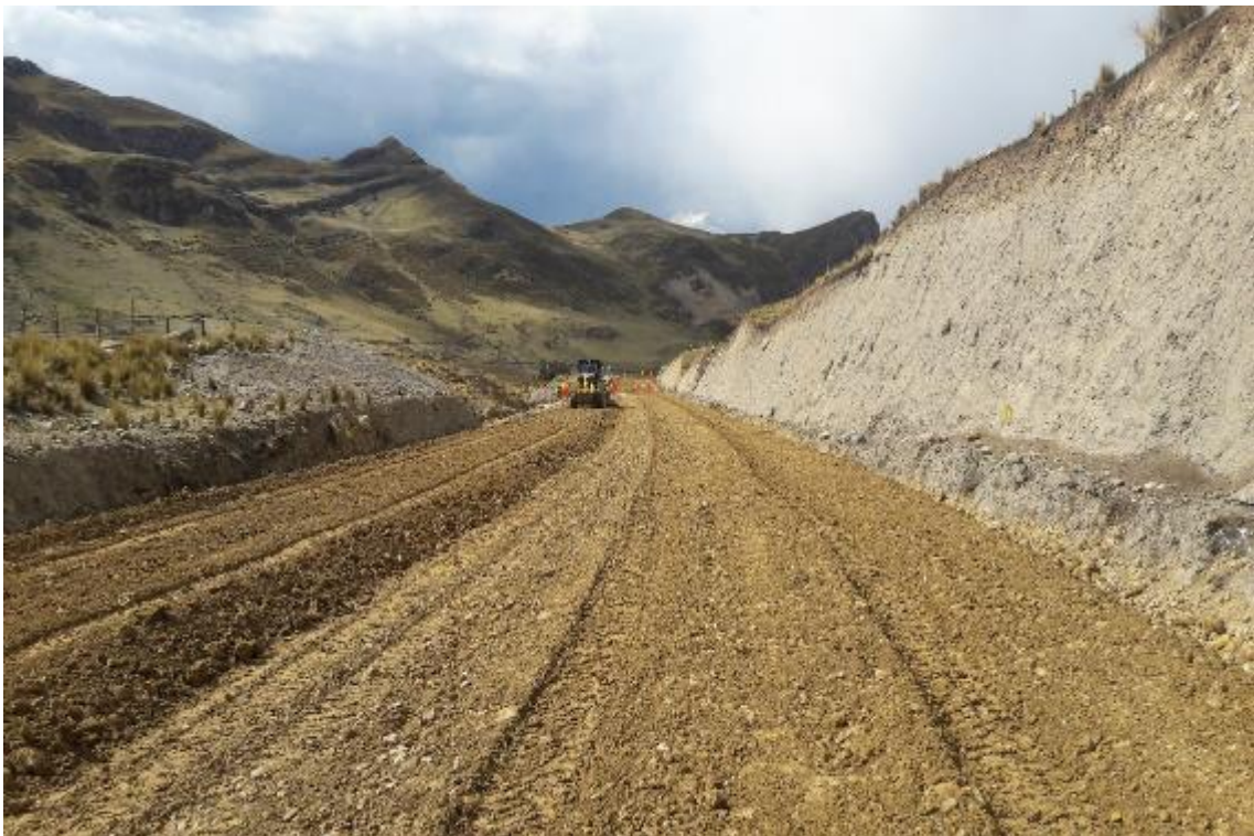
Foto N°30. Trabajos de explanaciones. Conformación de base
