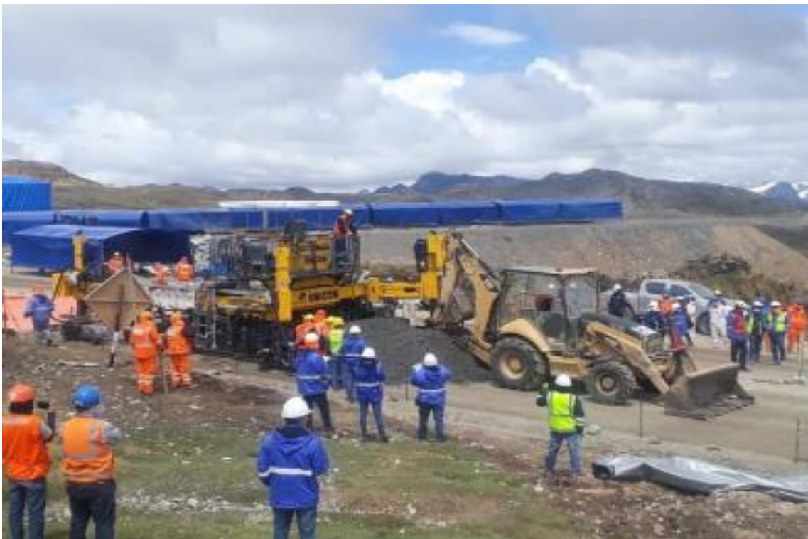
Foto N°42. Colocación de Pavimento Rígido
