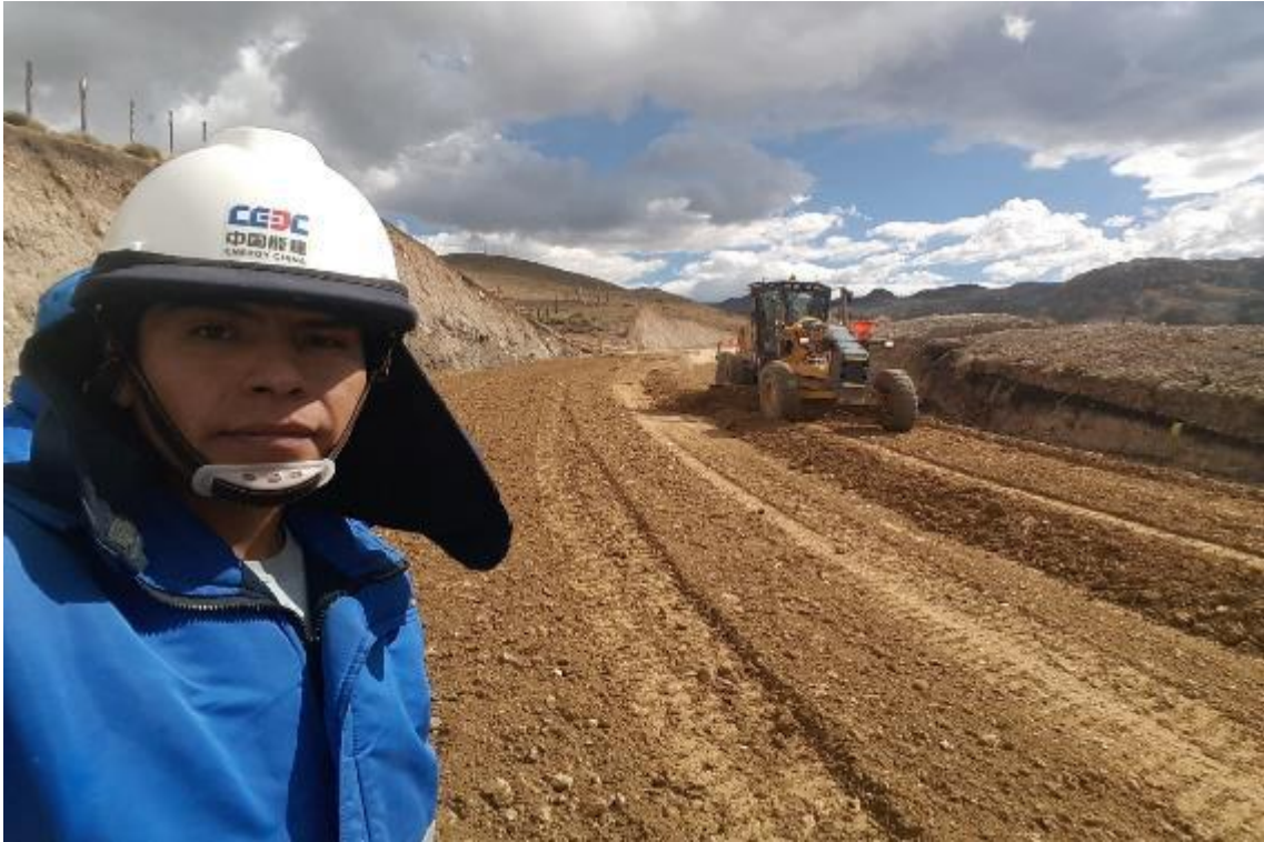
Foto N°29. Trabajos de explanaciones. Conformación de base
