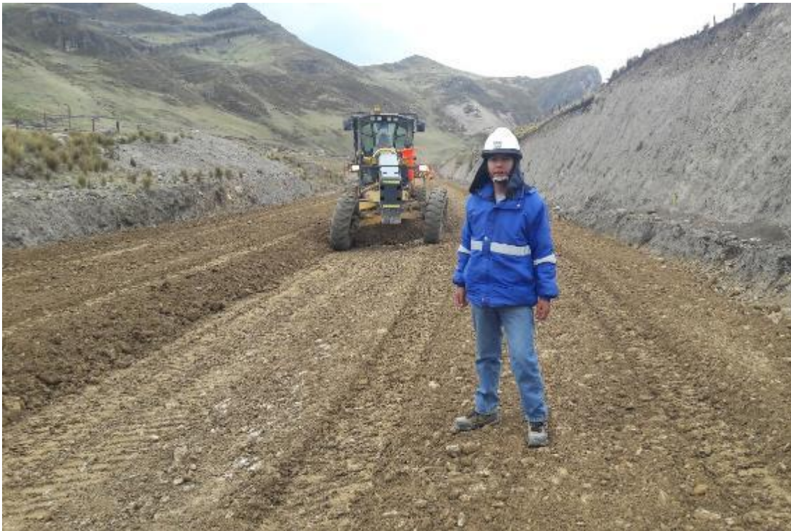
Foto N°31. Trabajos de explanaciones. Conformacion de base
