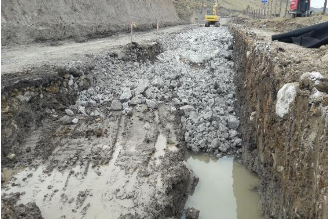
Foto N°9. Mejoramiento de Subrasante (espolones)
