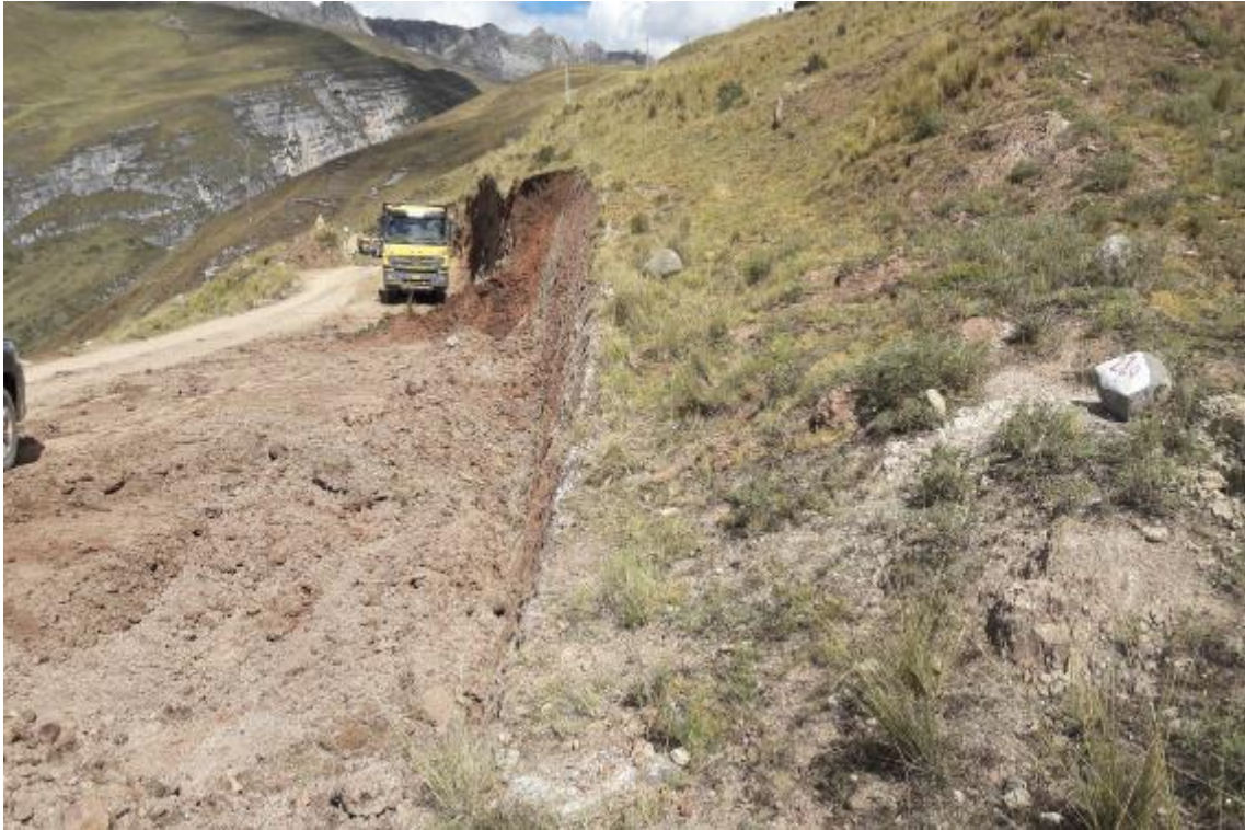
Foto N°7. Trabajos de movimiento de tierras. Zona de Corte
