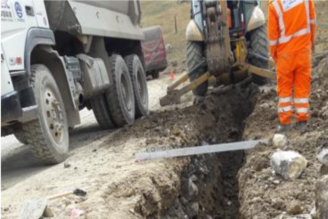
Foto N°39. Excavación para Subdrenes.
