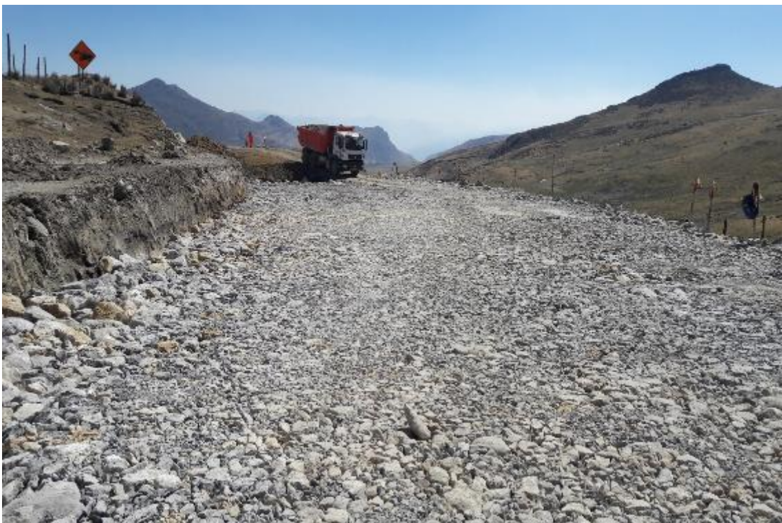
Foto N°18. Mejoramiento de Subrasante
