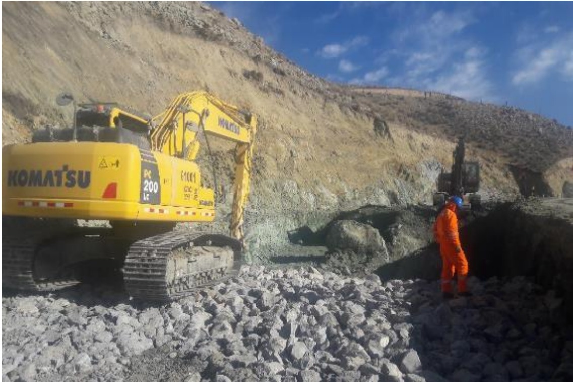
Foto N°11. Mejoramiento de Subrasante (espolones y colchones drenante)
