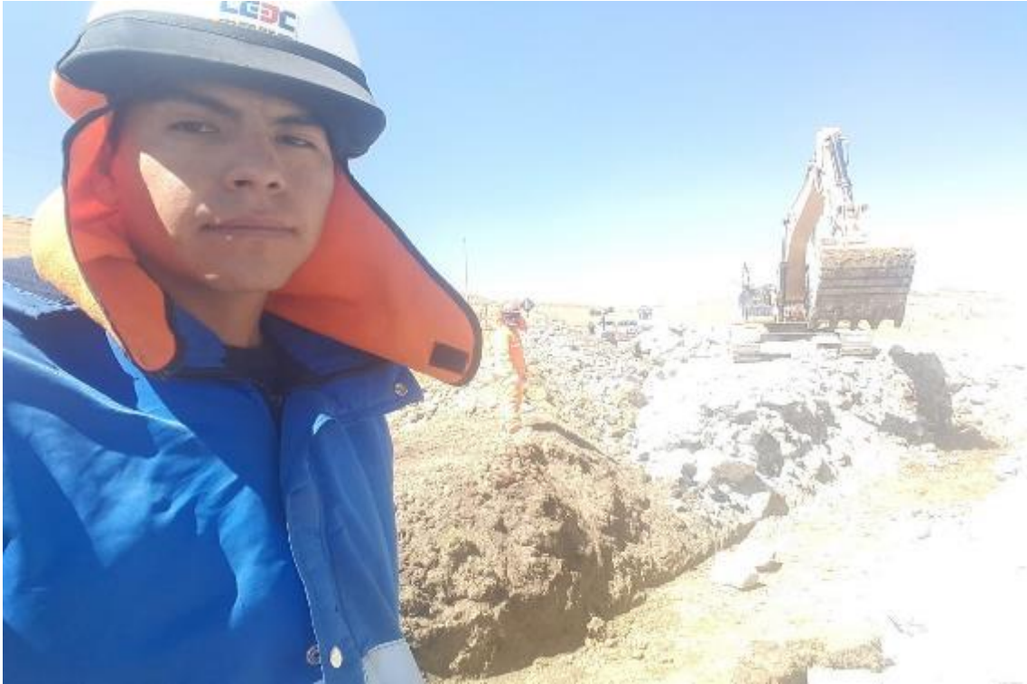
Foto N°23. Mejoramiento de Subrasante
