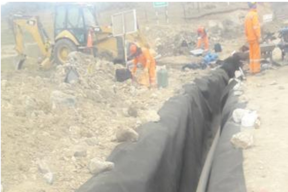
Foto N°40. Colocación de Geo mantas en los subdrenes.
