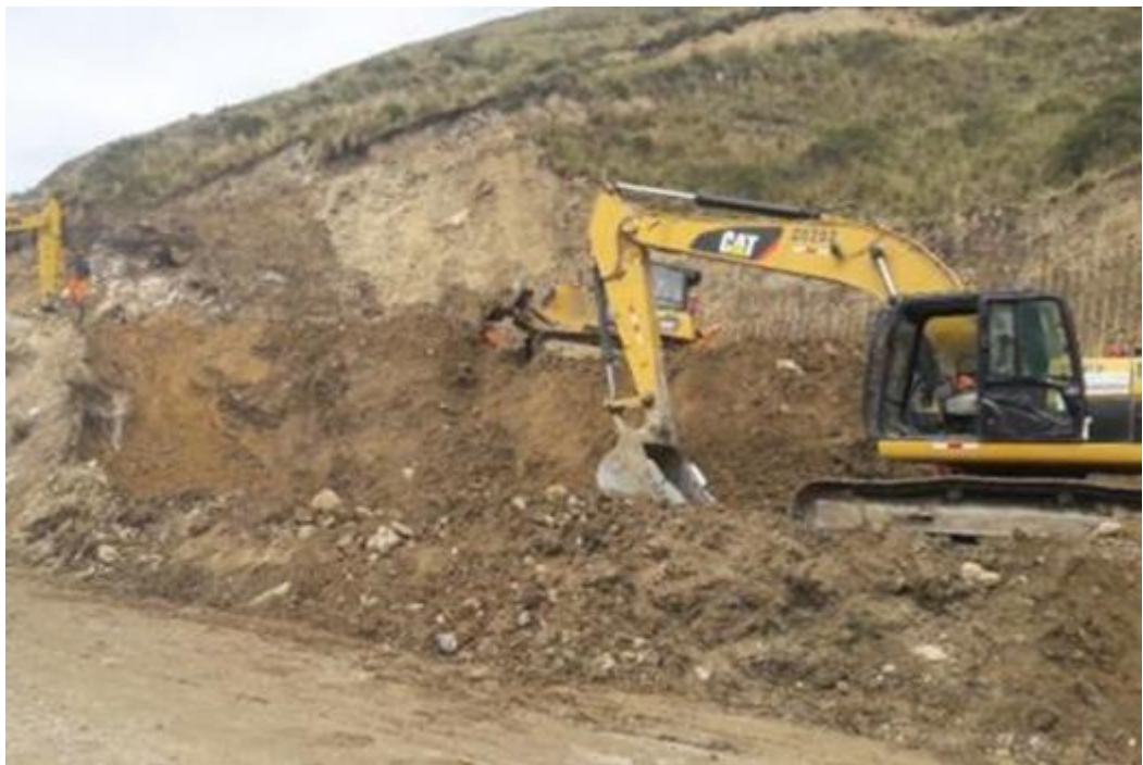
Foto N°2. Trabajos de movimiento de tierras. Zona de Corte
