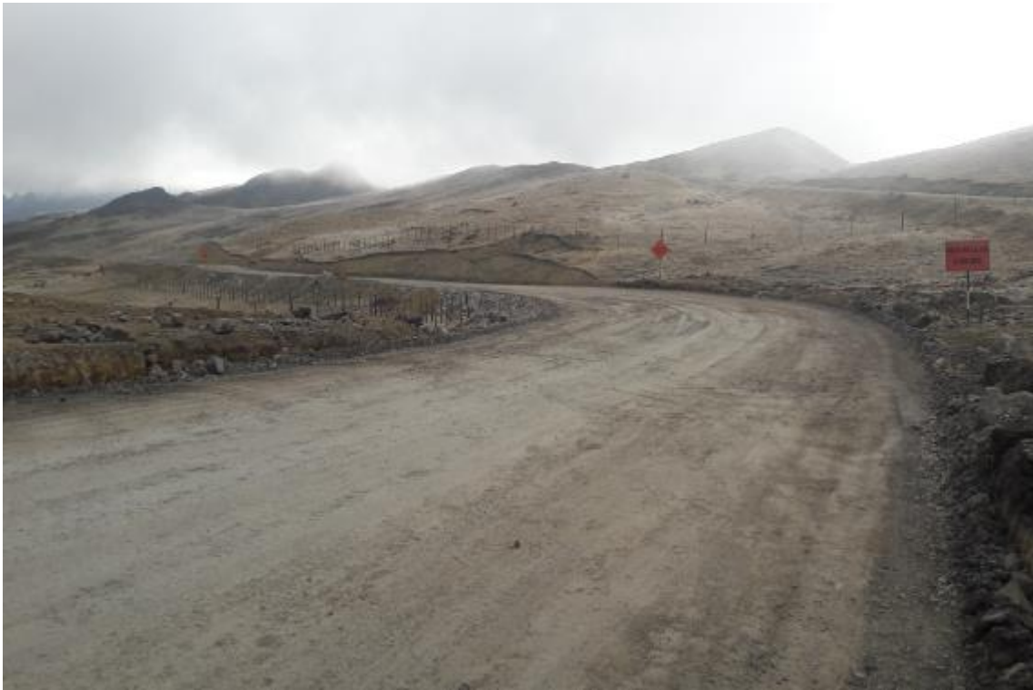
Foto N°35. Trabajos de explanaciones. Conformación de base
