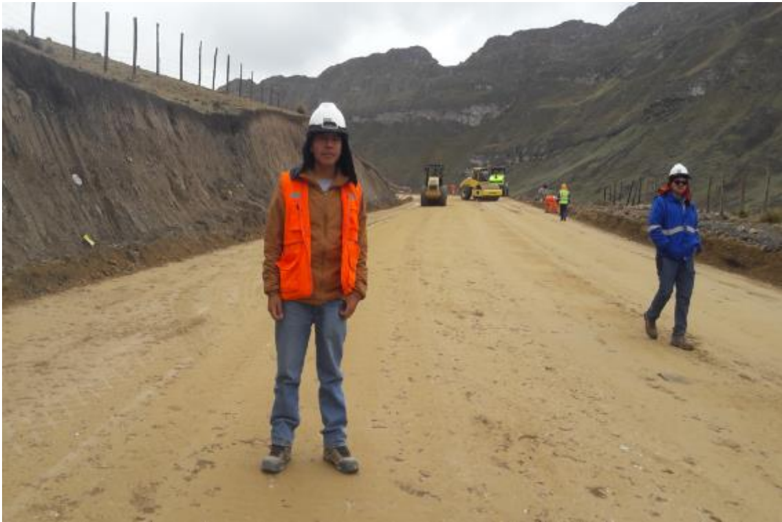
Foto N°33. Trabajos de explanaciones. Conformación de base
