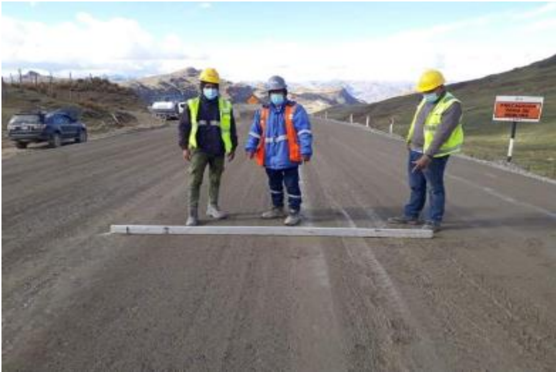
Foto N°37. Trabajos de explanaciones. Conformación de base
