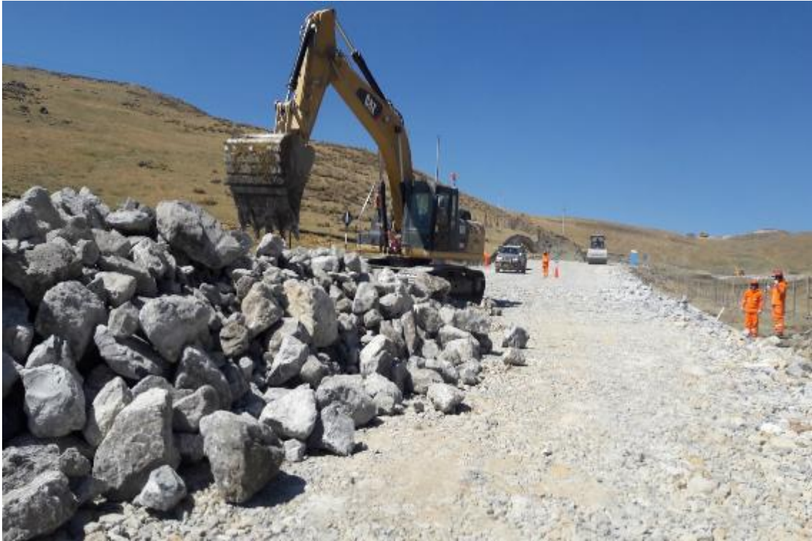
Foto N°21. Mejoramiento de Subrasante
