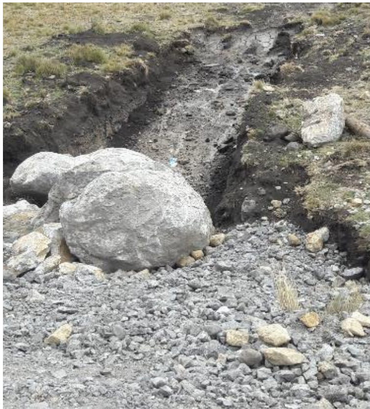
Foto N°26. Mejoramiento de Subrasante. Desfogue a traves de espolones
