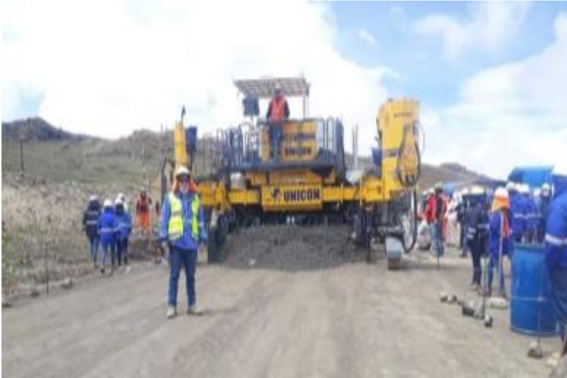
Foto N°41. Colocación de Pavimento Rígido
