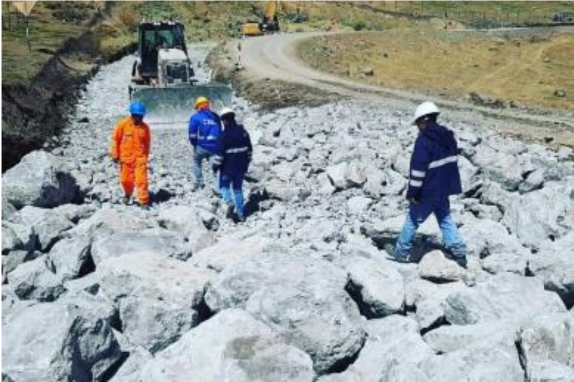
Foto N°15. Mejoramiento de Subrasante (espolones y colchones drenante)
