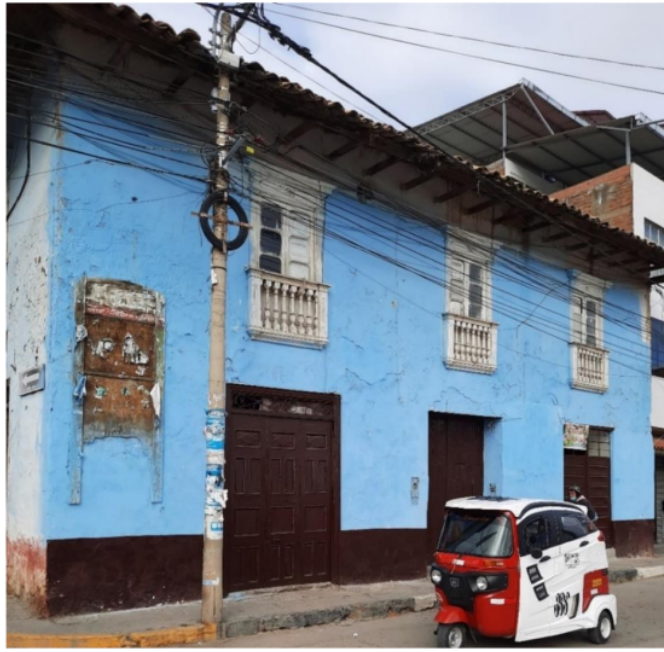
Figura 27. Toma de datos con la ficha de Observación a los Inmuebles Patrimoniales, Frente Jr. Arica. Elaboración Propia
