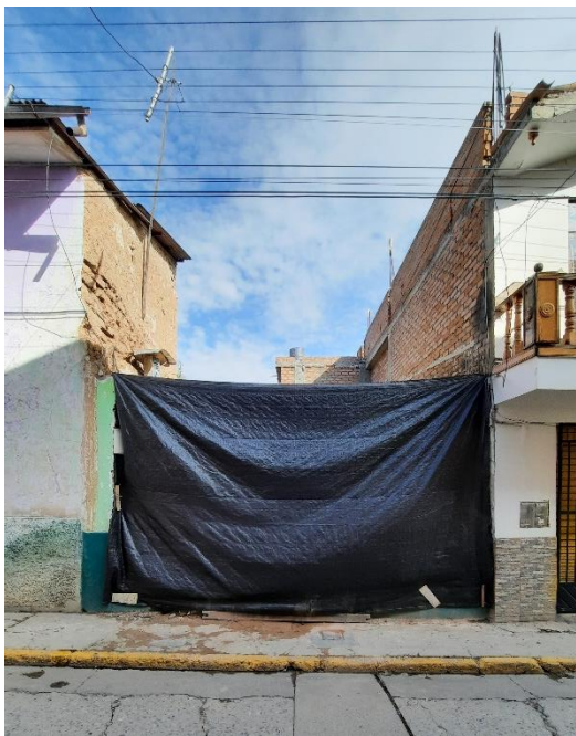
Fuente: Propia, Inmueble demolido, cuadra 5.
