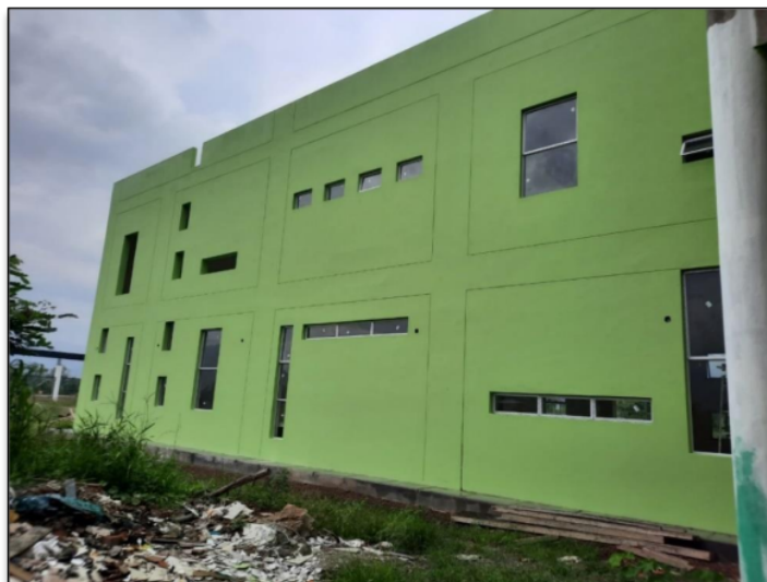
Figura N° 19. Vista posterior del laboratorio de bromatología, biotecnología y microbiología de alimentos I – pabellón de laboratorios de industria alimentarias de la Facultad de Ciencias Sociales.
