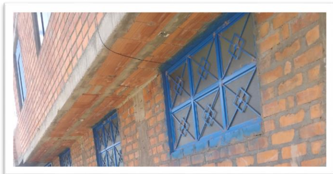
Figura N° 46 Centro de luz en viguetas
