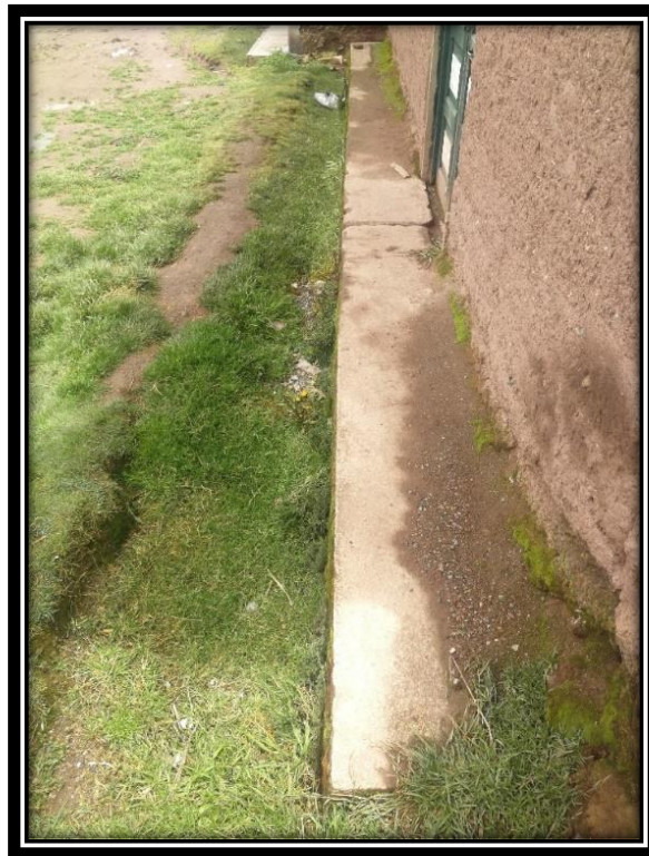
Figura 3 vereda existente para demoler
