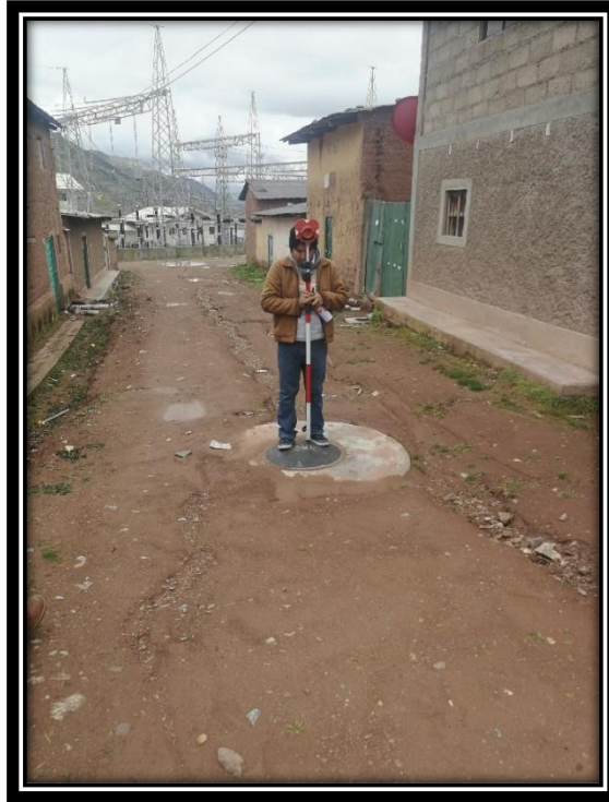
Figura 2 Levantamiento Topográfico y toma de datos en buzones existentes
