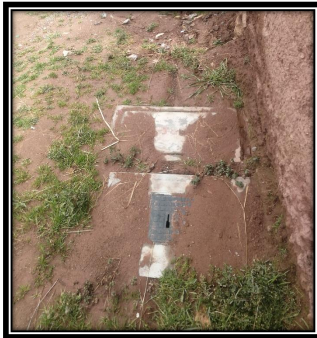
Figura 2 Se observa las conexiones domiciliarias de agua y desagüe
