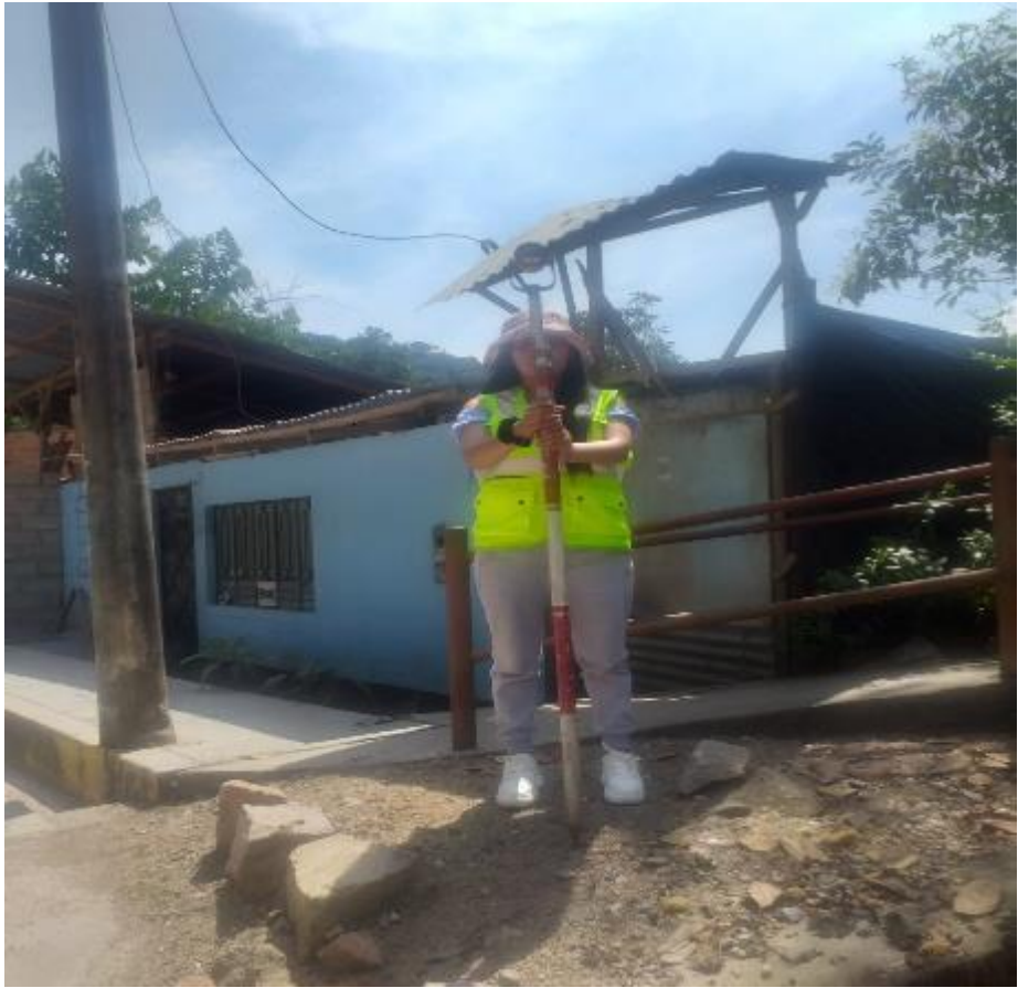
Figura 15- Vista del personal sujetando el prisma en el km 11+00
