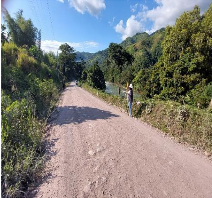
Figura 7 - toma de puntos estacionamiento en el km-05
