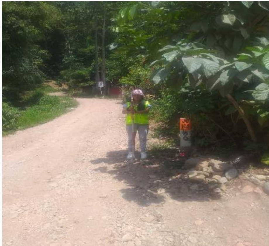
Figura 12- Vista del personal sujetando el prisma en el km-10
