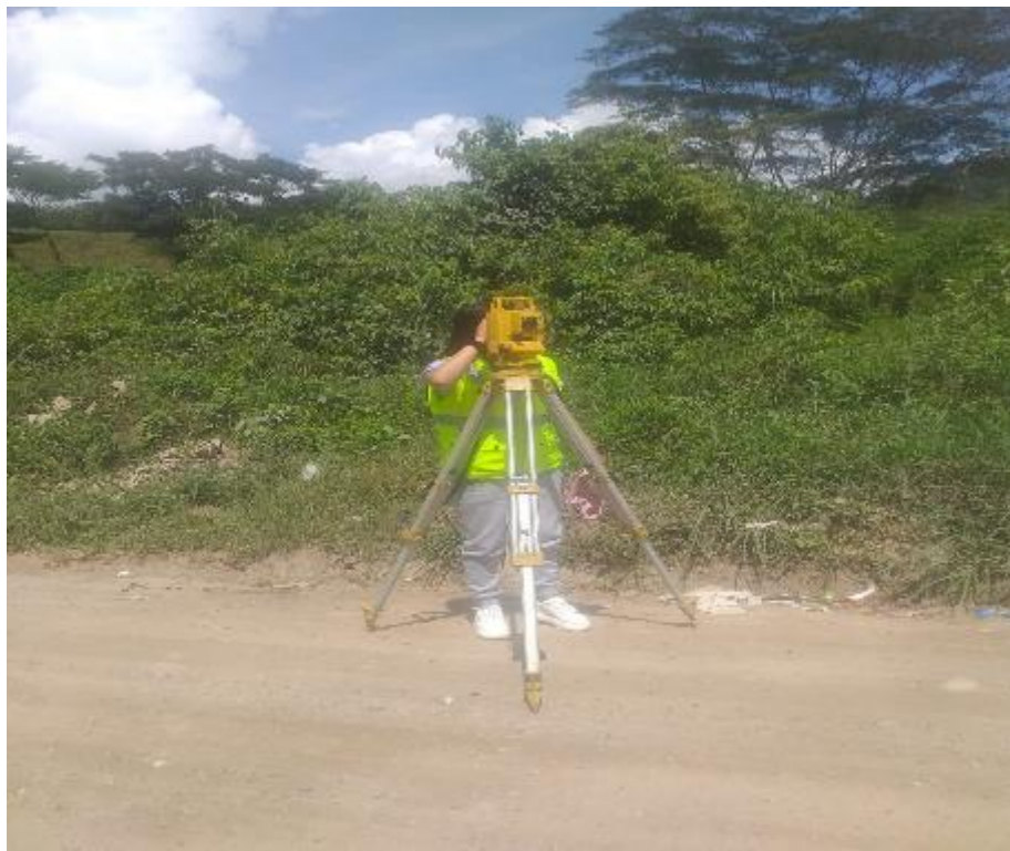
Figura 10 - estacionamiento en el km-09 y toma de puntos en levantamiento topográfico.
