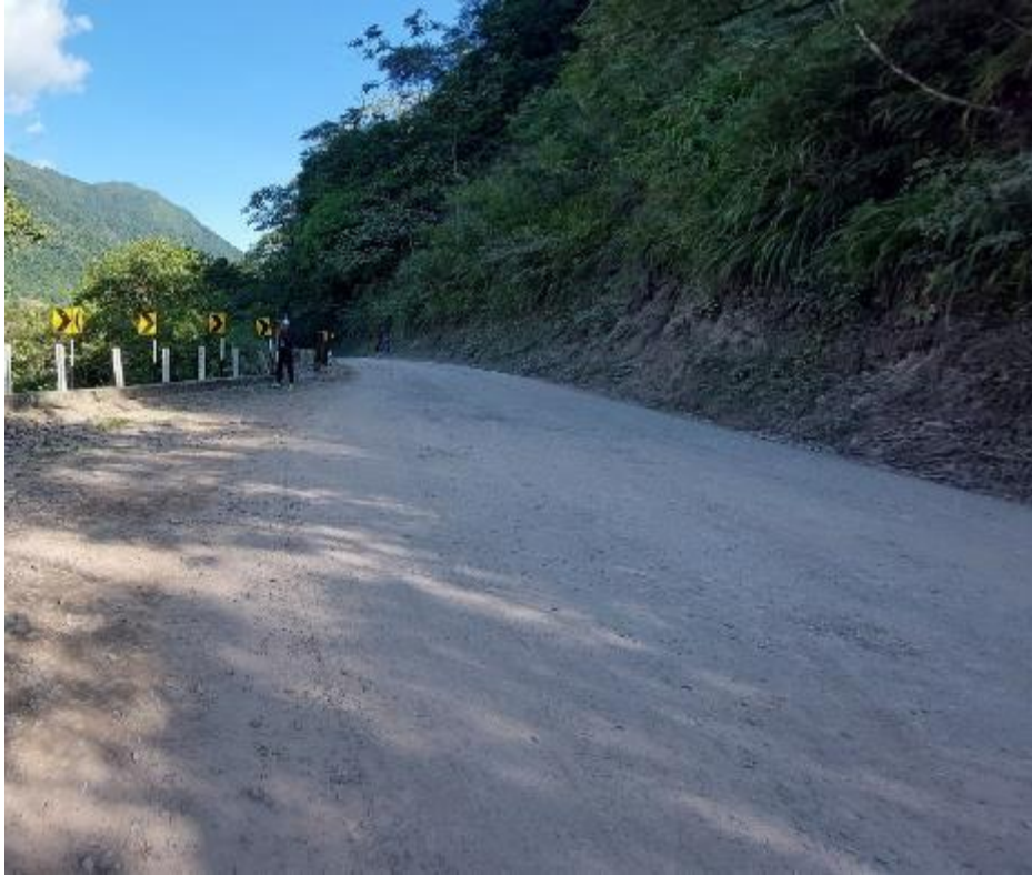
Figura 9- Vista del personal sujetando el prisma en el km-08
