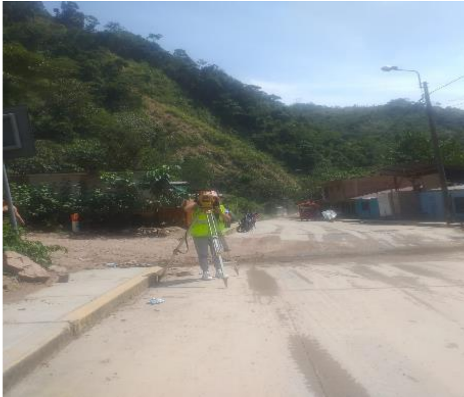
Figura 13 - Vista del personal realizando el estacionamiento en el tramo 10+500 km
