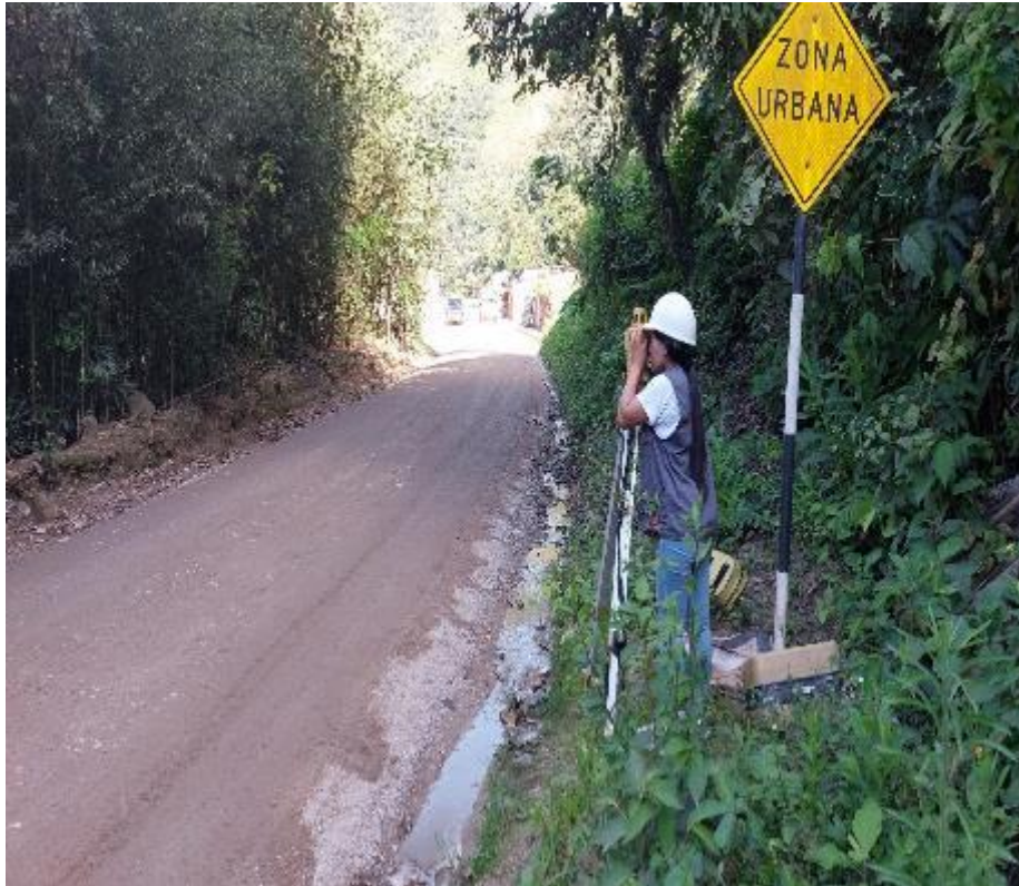
Figura 11 - Vista del personal realizando el estacionamiento en el tramo 10+00 km
