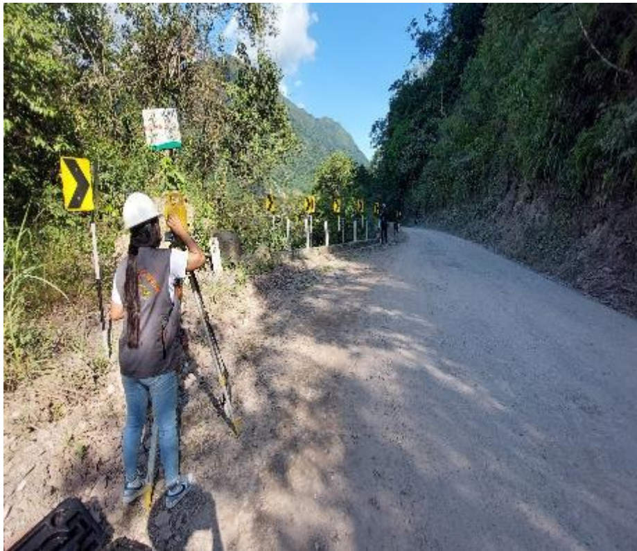
Figura 8 - estacionamiento en el km-08 y toma de puntos en levantamiento topográfico.
