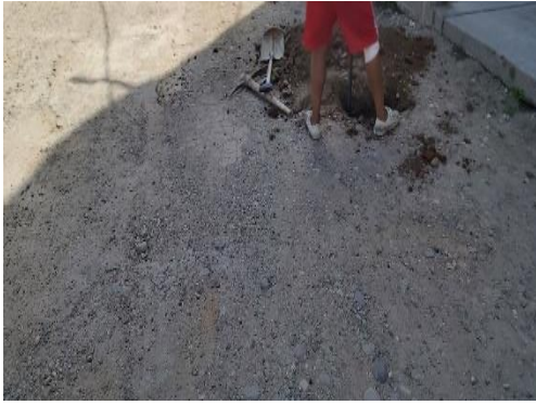
Fotografía 1. Vista del inicio de la excavación en la zona de estudio.
