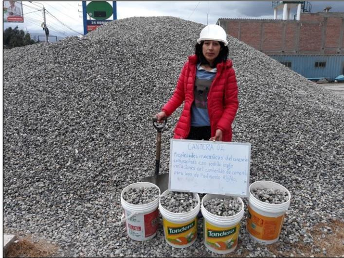
Fotografía 1. Obtención de los agregados grueso en la cantera ubicada en el distrito de Pilcomayo.
