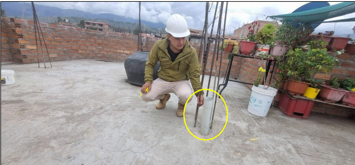
FOTOGRAFÍA 2: Se verifico que el acero para el piso posterior, el cual no tendrá recubrimiento ya que la tubería de PVC de 4" no lo permite.
