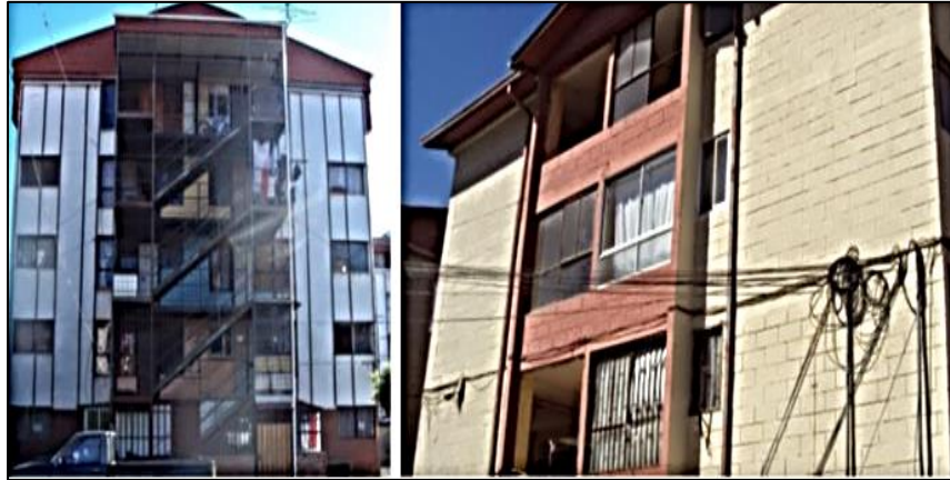
Figura N° 8. Conjunto habitacional con elementos de ladrillos (Se observan construcciones las cuales tienen un sistema de albañilería confinada las cuales fueron edificadas con ladrillos cocidos a tierra y King Kong)
