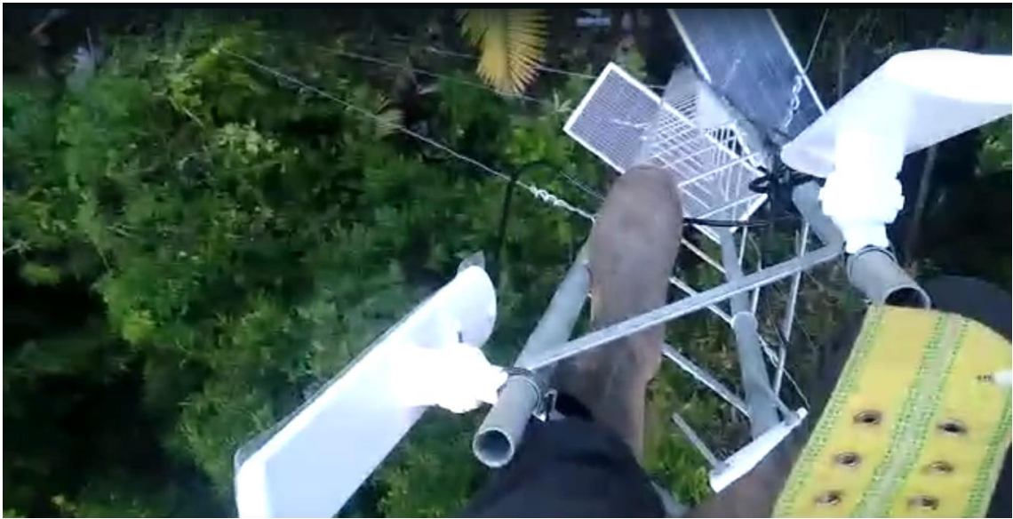
Fotografía para la toma de distancias de los enlaces.
