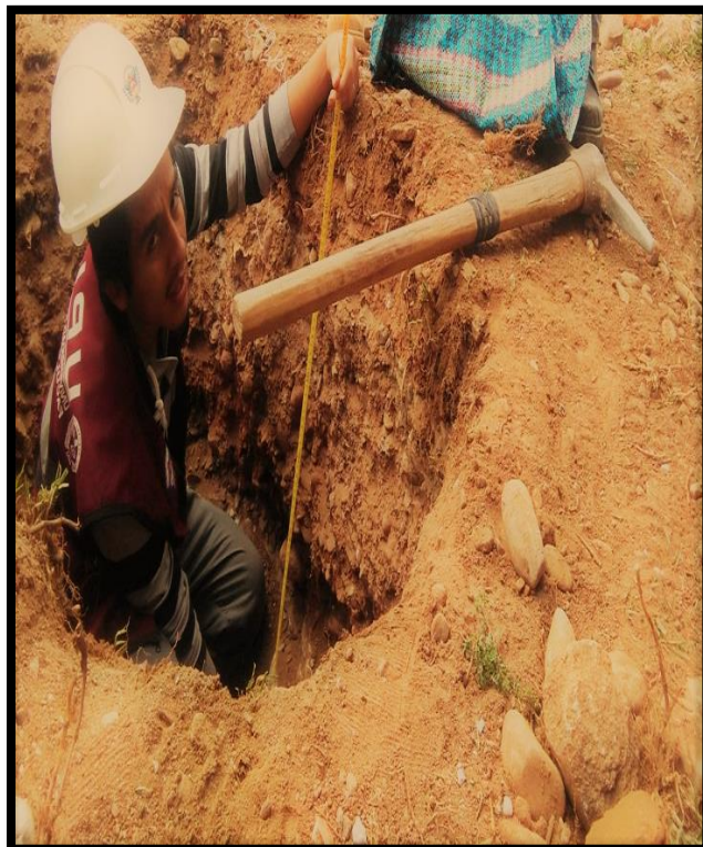
Excavación de la quinta calicata en Vírgenes del sol. (C5)
