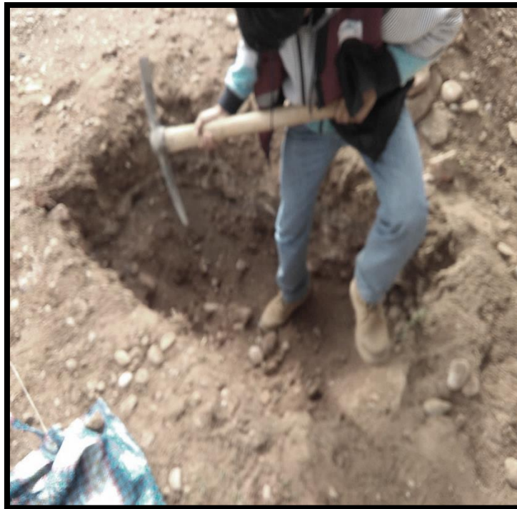
Excavación de la cuarta calicata en PJ. Salvatierra (C4)
