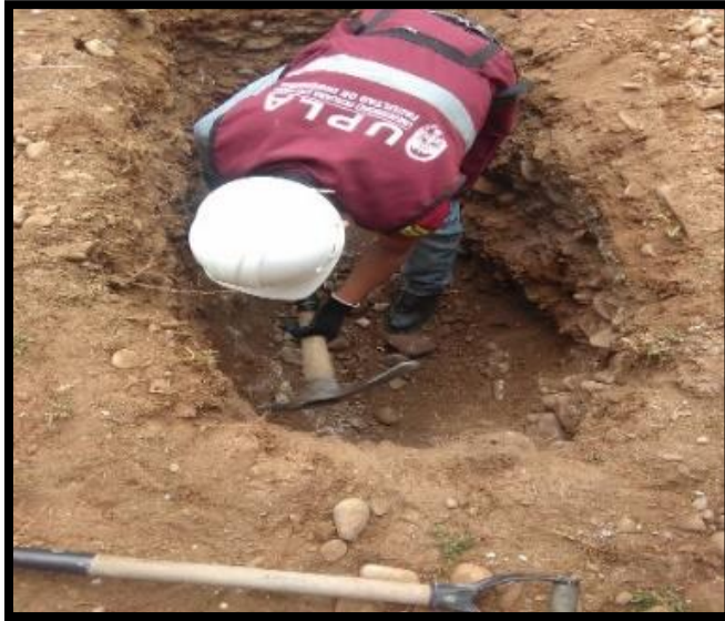
Figura 26: Excavación de las calicatas para el presente proyecto.
