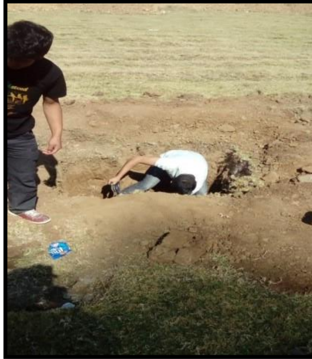
Excavación de la primera calicata en la A.V. Julio llanos y Pachacutec (C1)
