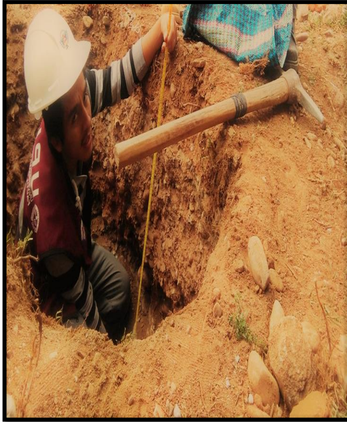
CALICATA N° 05 - Vírgenes del sol.
