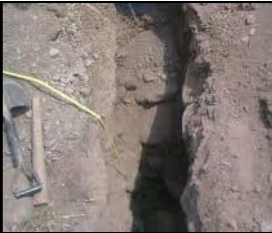
CALICATA N° 04 - P.J. Salvatierra
