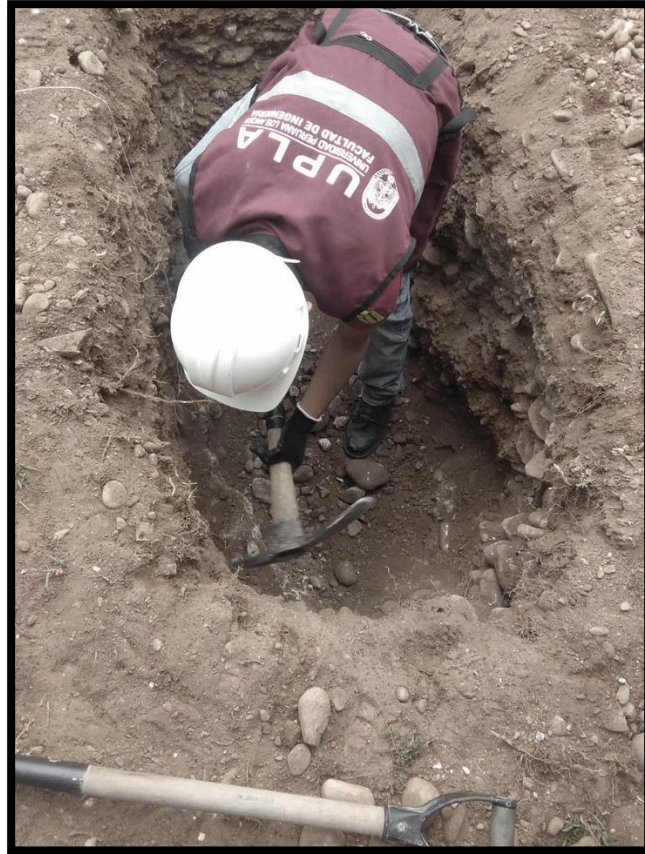
Excavación de la tercera calicata en PJ. Heroínas Toledo y PJ. Vidalon (C3)
