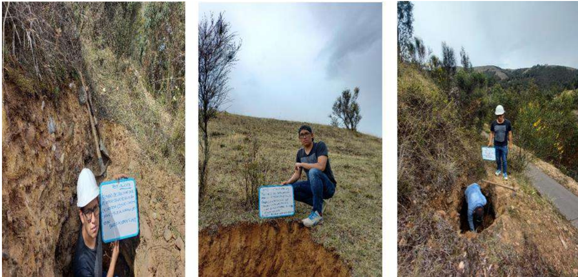
Figura 38 Excavacion de calicatas en la zona de estudio
