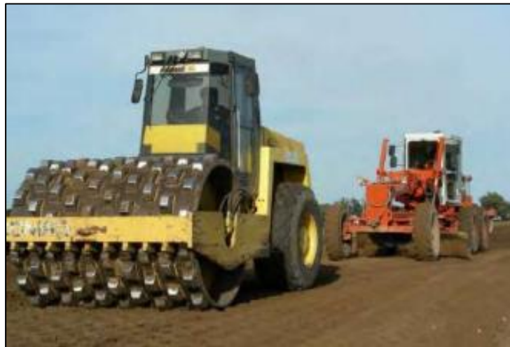
Figura 1. Estabilización por compactación aplicando rodillo “pata de cabra”.
