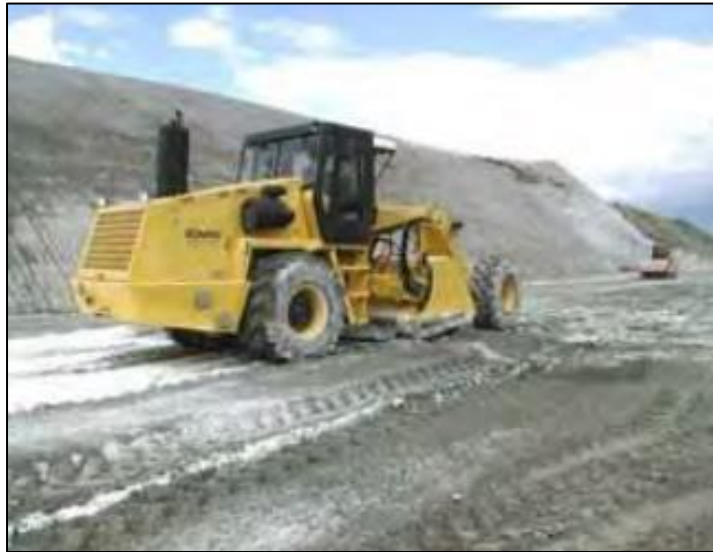
Figura 4. Estabilización de suelo incorporando cal.
