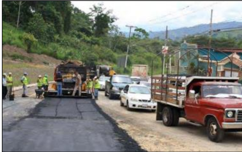
Figura 5. Estabilización con asfalto.
