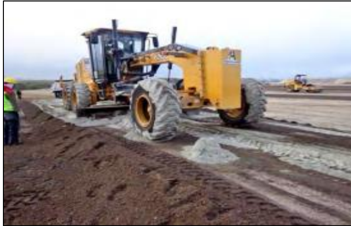
Figura 3. Estabilización con cemento.
