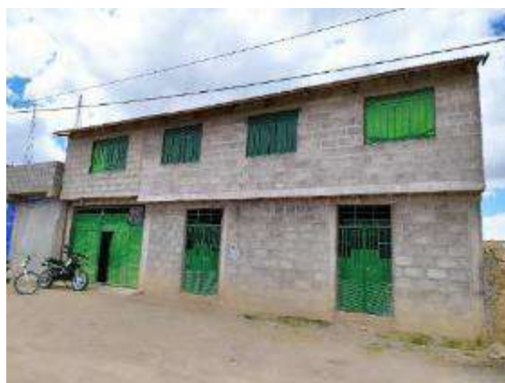
Fuente: Elaboración propia. Figura 1.2. Vivienda construida con bloques de concreto
