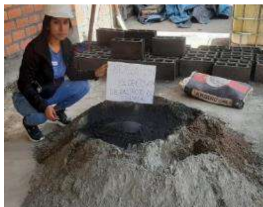
Figura 6: Mezcla de agregados, cemento con sustitución de ceniza.
