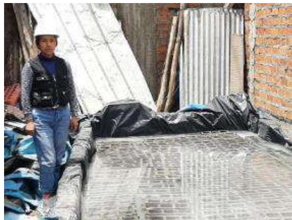
Figura 8: Curado de los bloques de concreto en pozo.
