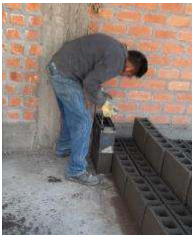
Figura 7: Desmoldado de los bloques de concreto.
