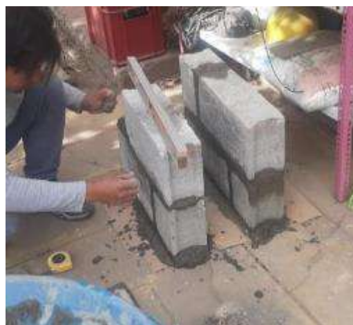
Figura 12: Asentado de muretes con bloques de concreto.
