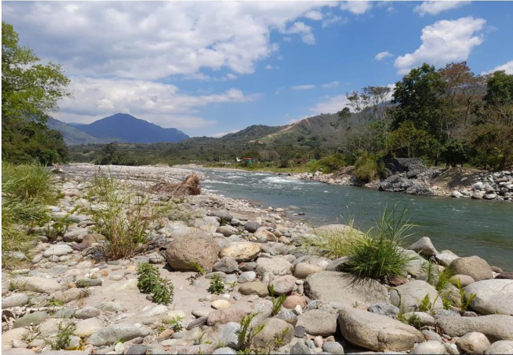
2Fotografía 21. “Vista de la vista de la faja marginal margen derecho rio Tulumayo sector playa hermosa san ramón.”
