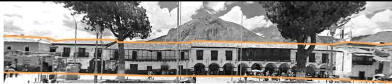
Nota: Imagen urbana correspondiente a la calle Jr. Virrey Toledo, lado sur de la plaza de armas, se observa edificaciones de dos pisos de altura de estilo colonial, portales en forma de arco, ventanales rectangulares y balcones hechos de madera.
