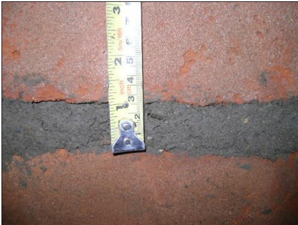
Fotografía 12. Vista de las juntas de 1 cm de espesor.
