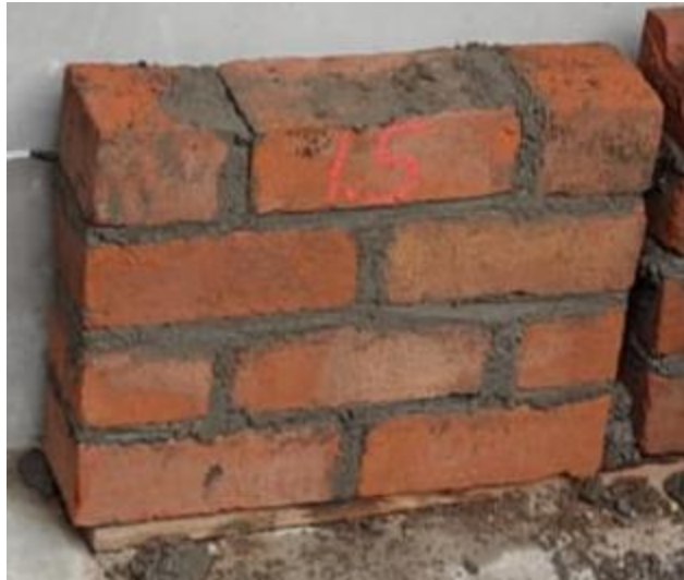
Figura 6. Murete de albañilería.
