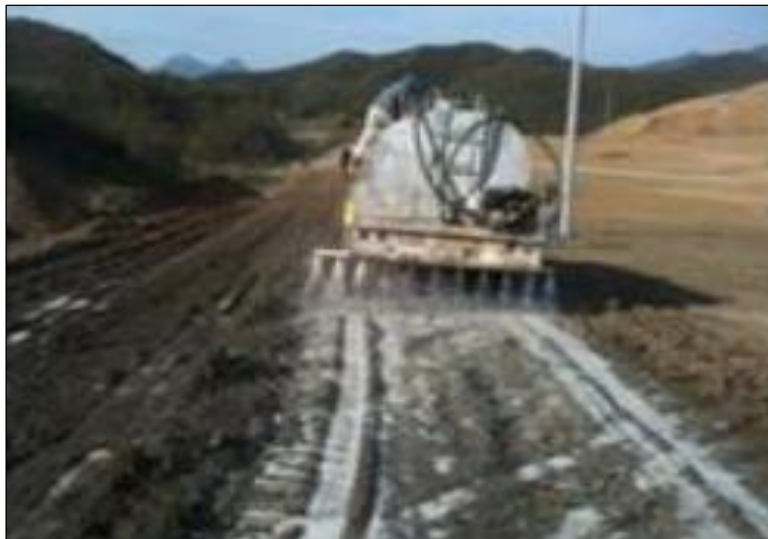
Figura 4: Aplicación base estabilizadora.
