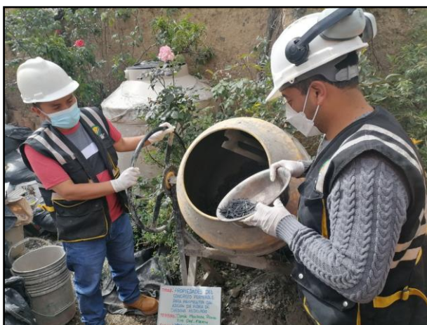
Fotografía N° 32: Vista de materiales tales para la elaboración del concreto convencional. Según NTP 339.183.
