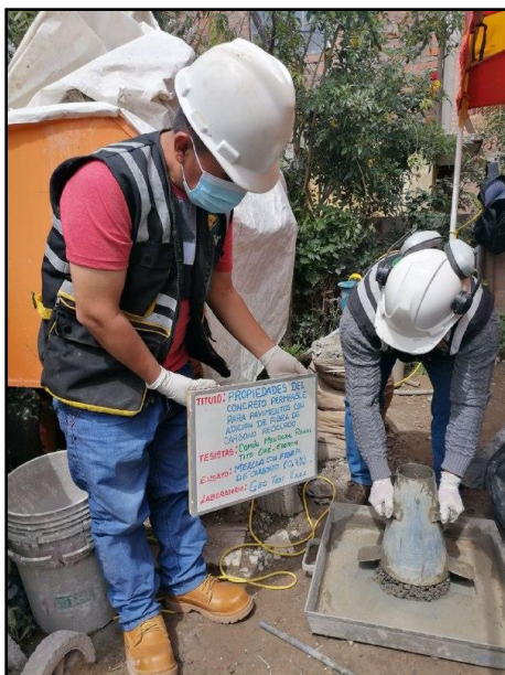
Fotografía N° 34: Medición del asentamiento del concreto fresco permeable. Según NTP 339.035
