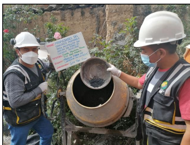
Fotografía N° 18: Vista de materiales tales para la elaboración del concreto convencional. Según NTP 339.183.
