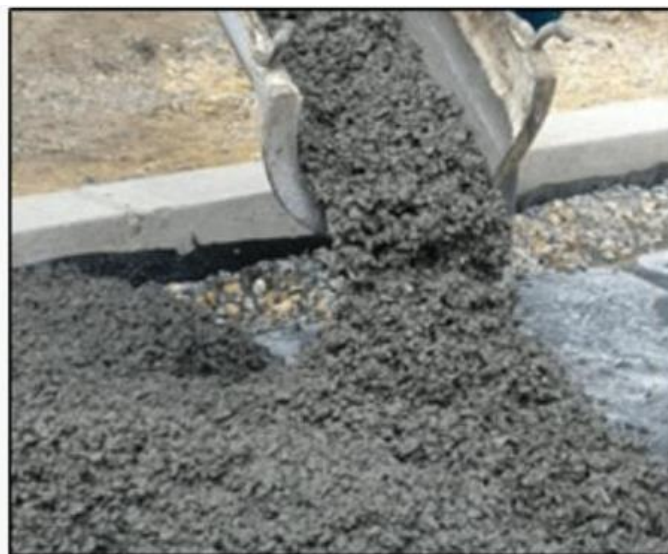
Figura 9: Concreto permeable, mezcla en estado fresco
