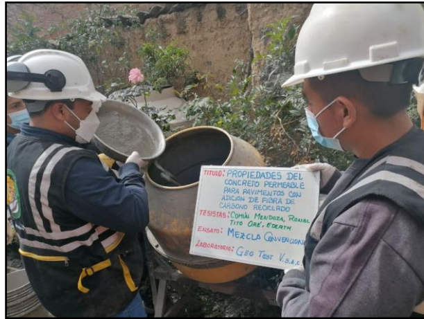
Fotografía N° 11: Vista de materiales tales para la elaboración del concreto convencional. Según NTP 339.183.
