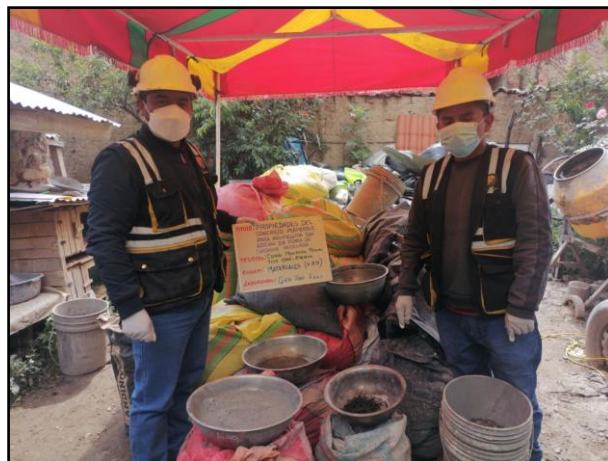
Fotografía N° 24: Vista de materiales tales como agregado grueso, cemento, agua y fibra para la elaboración del concreto convencional. Según NTP 339.183.
