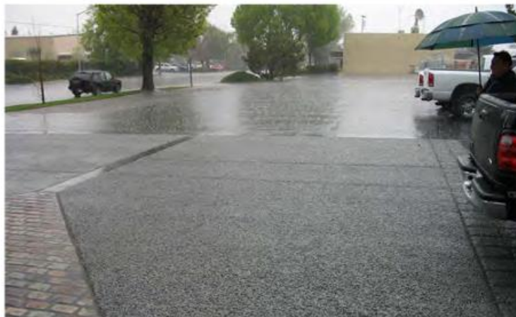
Figura 2: Concreto permeable aplicado en plazoletas
