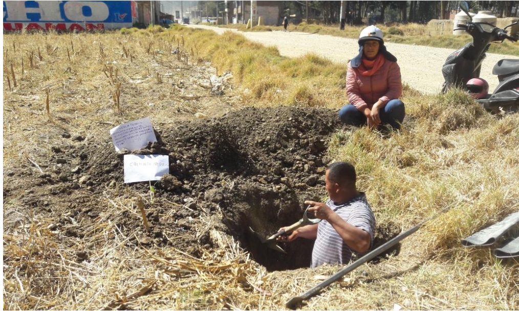
Imagen 11: Excavación de la calicata N° 02- Av. 31 de Octubre, cuadra 06
