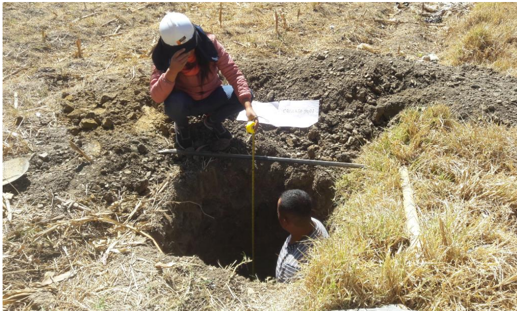
Imagen 12: Calicata N° 02- Av. 31 de Octubre, cuadra 06
