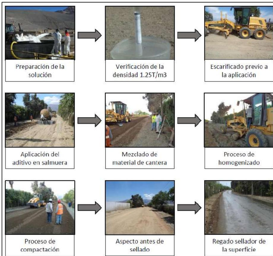
Figura 3. Proceso de aplicación del estabilizador cloruro de magnesio hexahidratado. Tomado de (ARAUJO, y otros, 2017)
