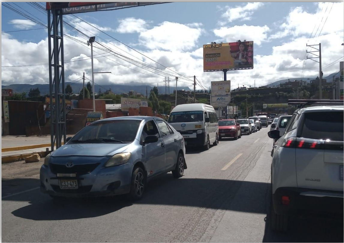
SE OBSERVA EL ESTADO ACTUAL DE LA VIA EN ESTUDIO
