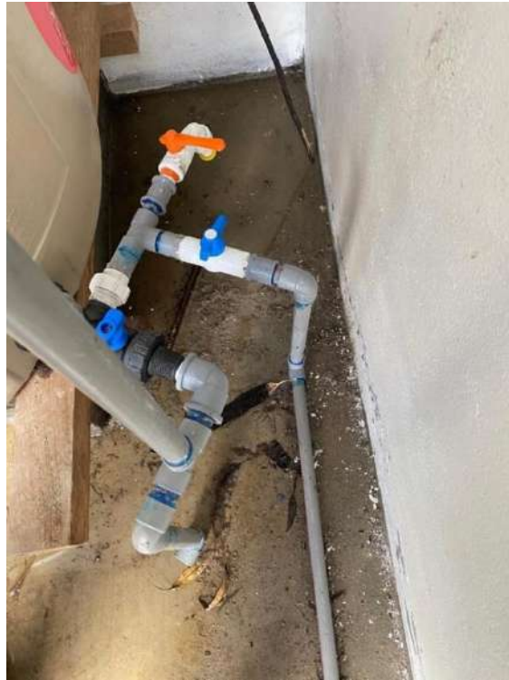
En la séptima fotografía, se muestran los componentes del sistema de cloración por goteo.
