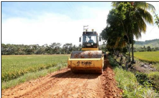
Figura 1. Mantenimiento de vía vecinal
