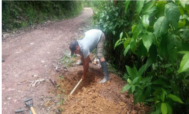
Fotografía N° 4: Realización de la calicata C-01
