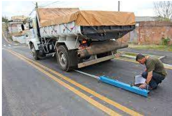
Figura 17: Procedimiento de medición de deflexión.
