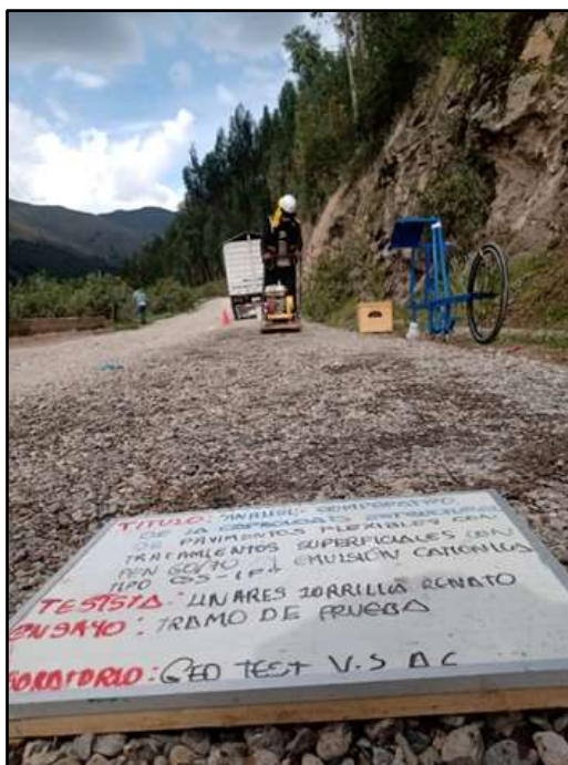
Fotografía 13: Tendido del material del uso 6 y uso 8 para el tratamiento superficial tanto en la primera capa y en la segunda capa.
