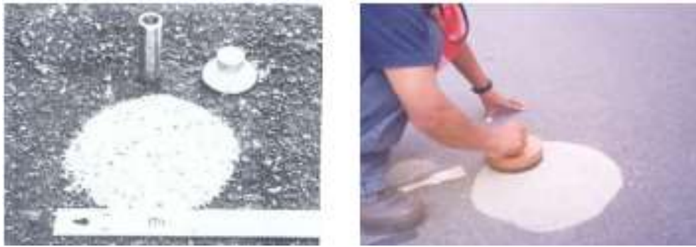
Figura 11: Diferencia de texturas en pavimento.
