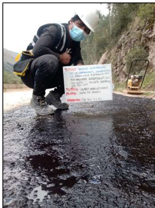
Fotografía 12: Tendido del material del ligante como primera y segunda capa.
