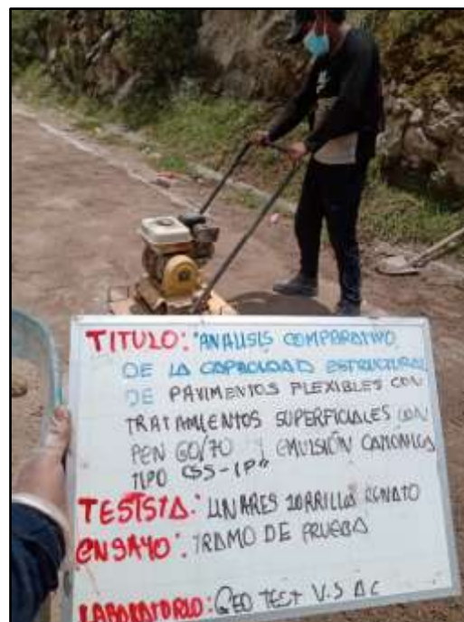
Fotografía 10: Tendido y compactación del material para tender nuestro tratamiento superficial.
