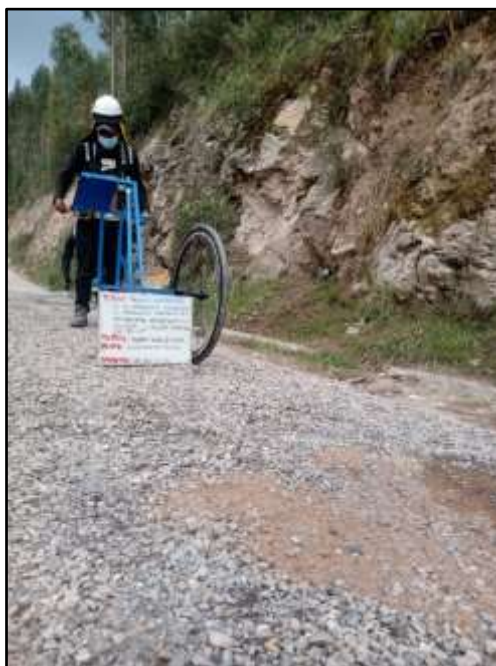
Fotografía 14: Determinación de la medición del rugosímetro por el método Merlín (IRI) según la norma (ASTM E 1926).
