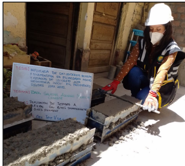
Figura 39: Elaboración de vigas con adición de los aditivos 0.40% de viscocrete 50 HEPE y 0.42% sikament 290N, según referencia de la norma NTP 339.034 / ASTM C39.
