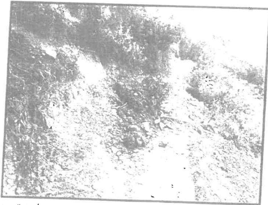
Fotografía 02: Área proyectado para la construcción del muro de conducción L=30 m. con altura H=2.10 m, el cual presenta una compacidad muy suelta.
