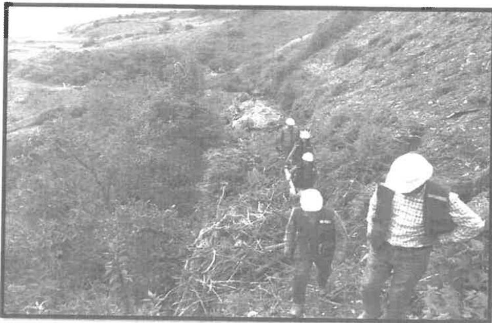
Fotografía 04: Observamos al Especialista en estudios - CAC - Huancavelica Ing. Edgar Rojas Castillo, Supervisor de Obra y Residente de obra verificando del estado actual del terreno para la construcción del muro de contención (L=30 m. con altura H=2.10 m), en el tramo de línea de conducción.
