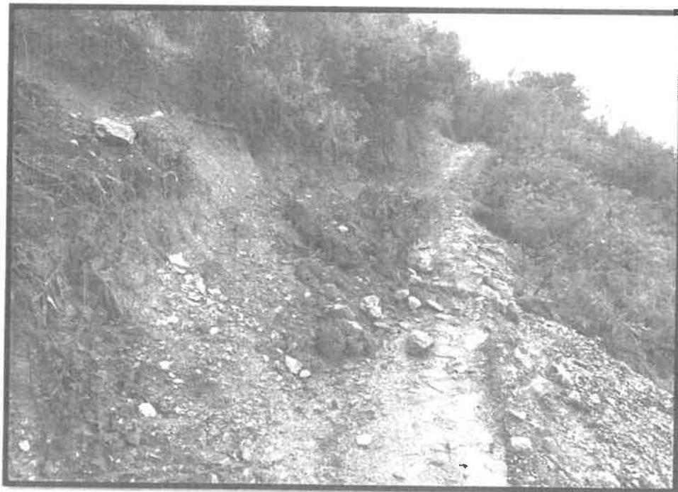
Fotografía 02: Área proyectado para la construcción del muro de conducción L=30 m. con altura H=2.10 m, el cual presenta una compacidad muy suelta.
