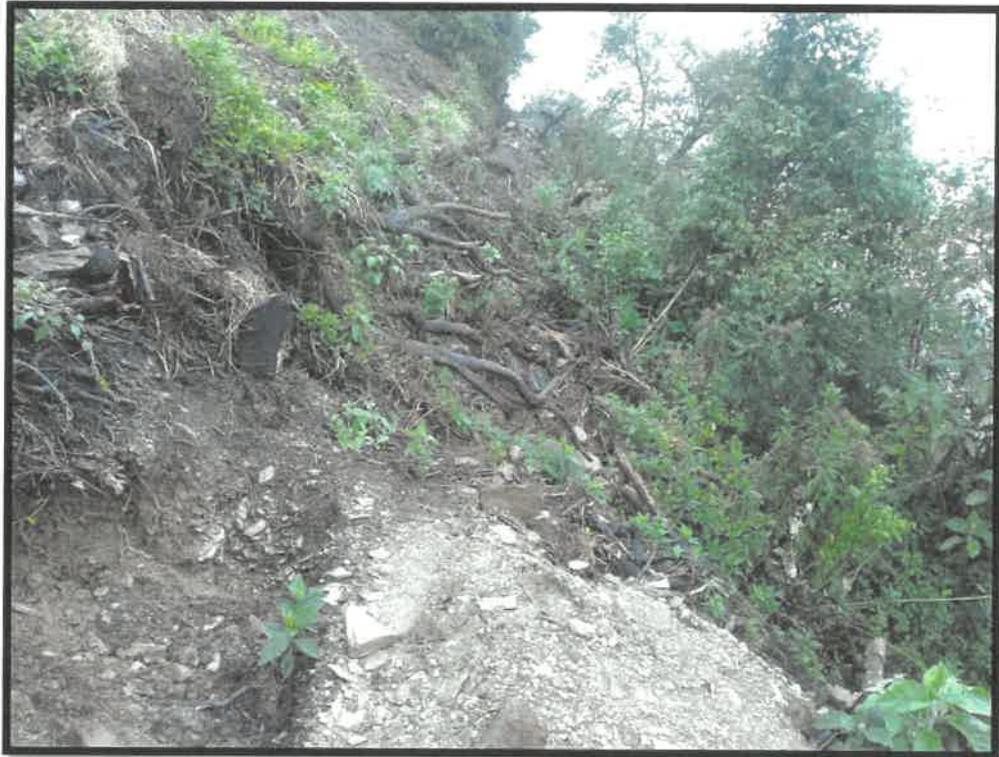
Fotografía 01: Área proyectado para la construcción del muro de conducción L=30 m. con altura H=2.10 m, el cual muestra la reptación del suelo (corrimiento del suelo).
