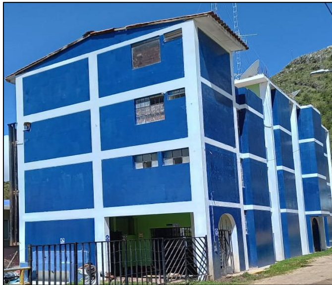
Figura 1.9 Local central del IESTP Nuevo Occoro
