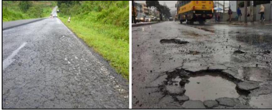
*Figura 1. Tipos de deterioro por el daño por humedad (Costa Rica).*
