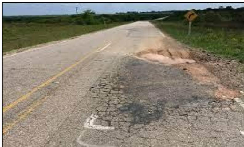
*Figura 2. Falla de pavimento flexible.*
