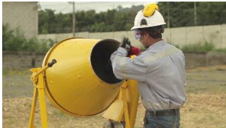
Figura 6 Elaboración del concreto según normatividad vigente E0.60/NTP 339.034.
