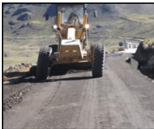
FIGURA 28. Tendido del material, previamente aplicado el polímero megasoil. FUENTE: Elaboración propia
