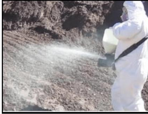
FIGURA 26. Dispersión del polímero megasoil, aplicado directamente en el material de préstamo. FUENTE: Elaboración propia
