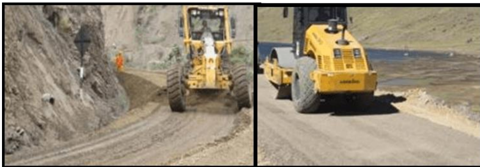
FIGURA 25. Previamente de haber aplicado y mezclado el producto, se tiende y compacta el material con la maquinaria adecuada.
