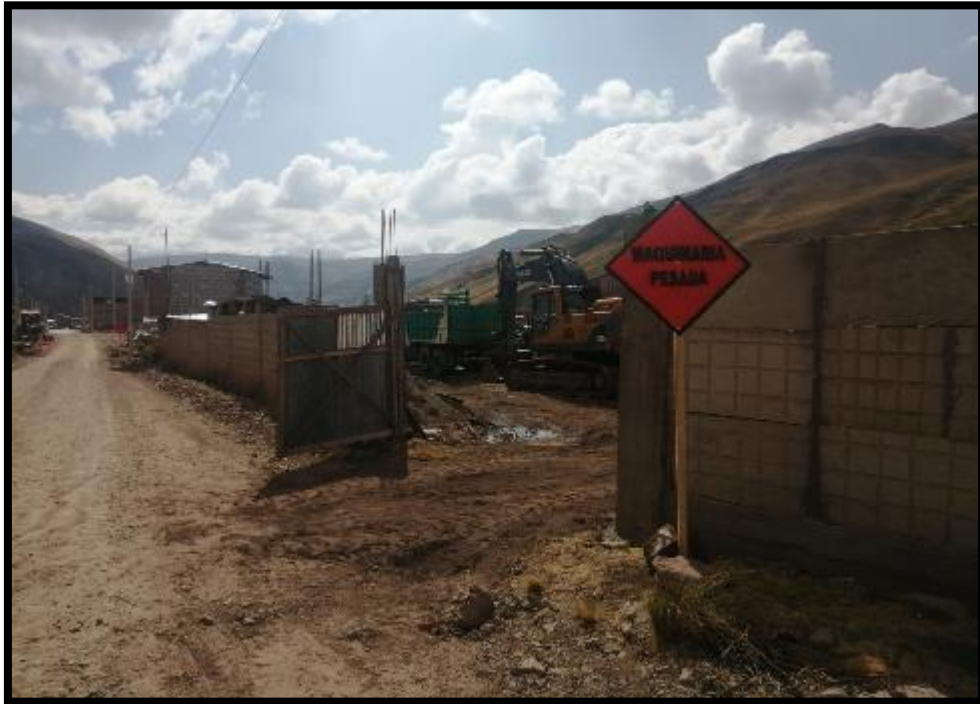
EN LA IMAGEN SE APRECIA LA SEÑALIZACION TEMPORAL EN OBRA
