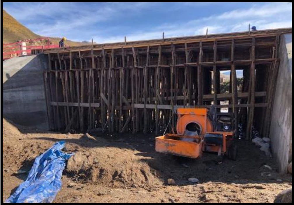
EN LA IMAGEN SE APRECIA EL ENCOFRADO DE FALSO PUENTE
