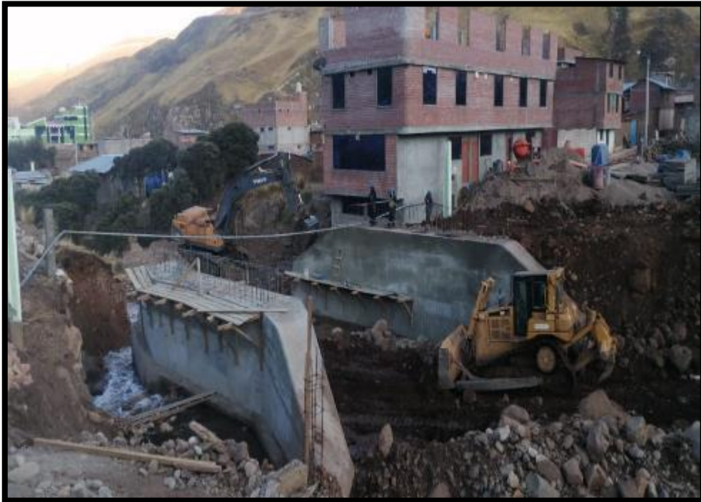
EN LA IMAGEN SE APRECIA EL CORTE DE TERRENO PARA LOS TRABAJOS DE EMBOQUILLADO EN EL PUENTE
