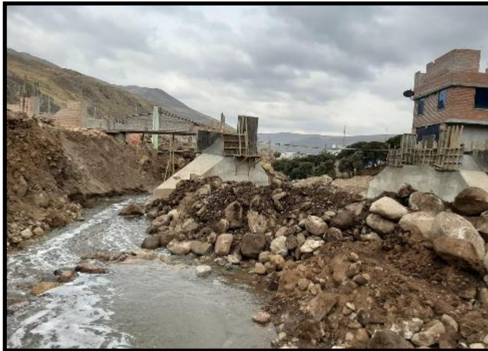
EN LA IMAGEN SE APRECIA EL ENCAUZAMIENTO DEL RIO POR DETRAS DEL ESTRIBO
