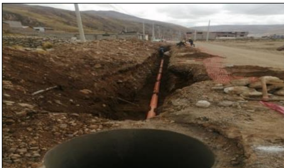
Figura 28. Tendido de tubería de desagüe
