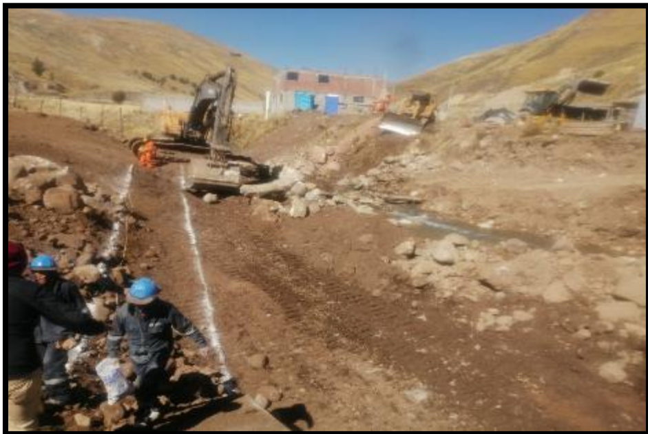
EN LA IMAGEN SE APRECIA EL TRAZO Y REPLANTEO PARA TRABAJOS DE ENROCADO
