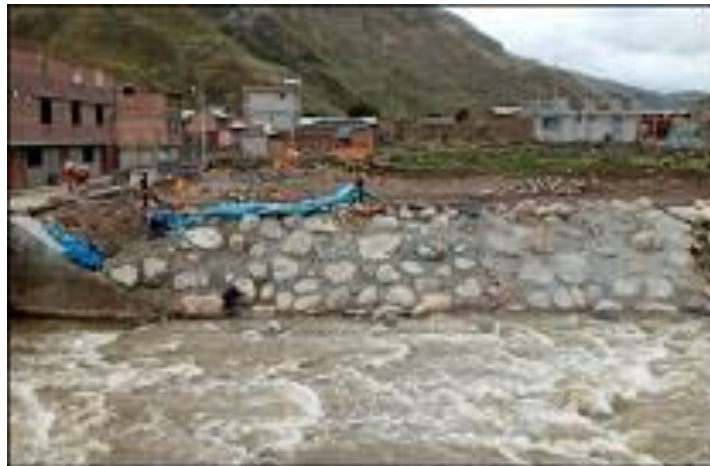
Figura 59. Emboquillado de concreto en enrocado
