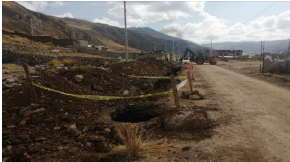
Figura 27. Excavación manual en zanja para desagüe
