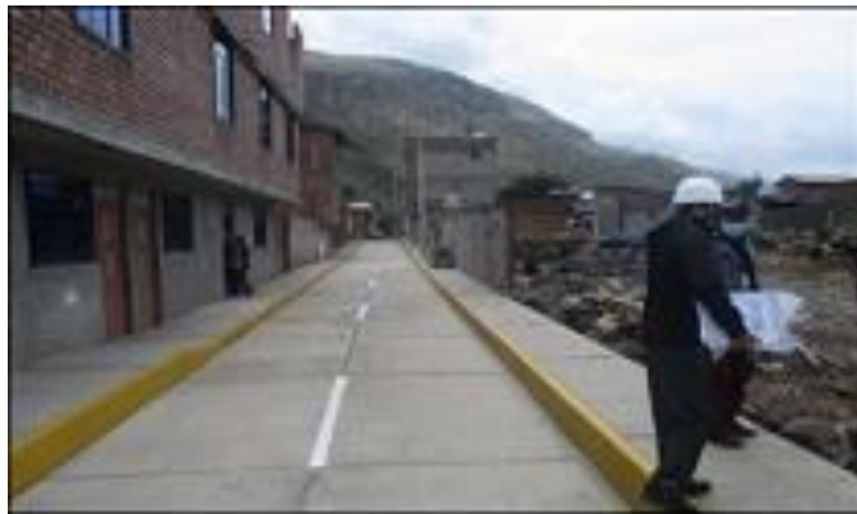
Figura 61. Pintura lineal discontinua, Calle Libertad
