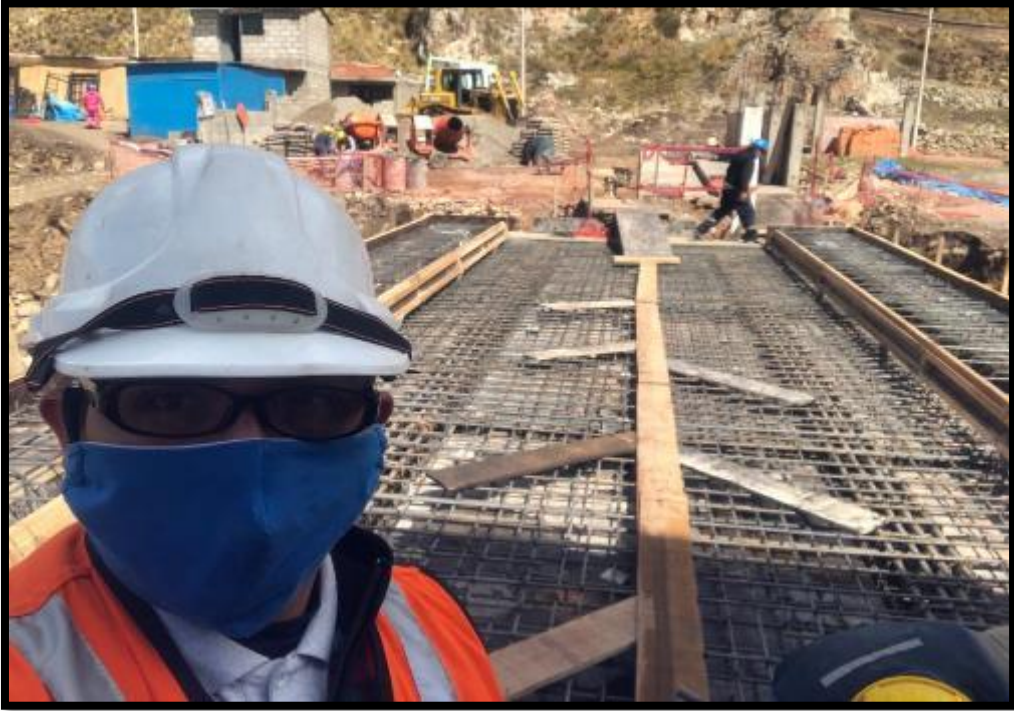
EN LA IMAGEN SE APRECIA A LA SUPERVISION VERIFICANDO LA ARMADURA DE LA LOSA DEL PUENTE
