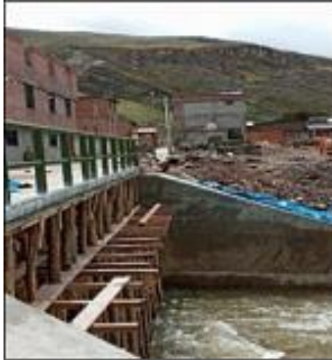
Figura 51. Baranda metálica en el puente
