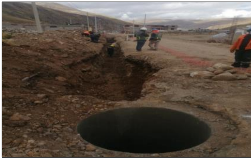
Figura 29. Recubrimiento de tubería de desagüe
