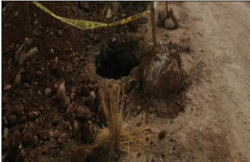
Figura 30. Excavación para buzón
