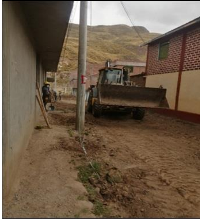
Figura 16. Relleno y compactado en la Calle Libertad
