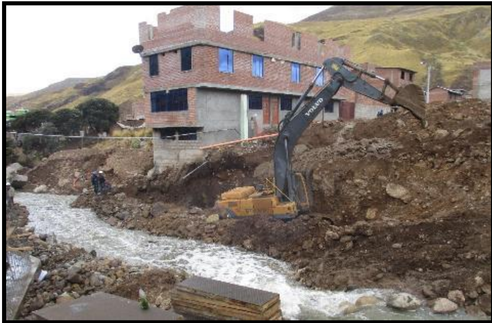
EN LA IMAGEN SE APRECIA LA EXCAVACION CON MAQUINARIA PARA ZAPATA Y ALEROS DEL PUEBLO
