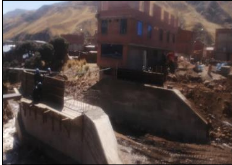
Figura 40. Encofrado de la cajuela a los lados del puente
