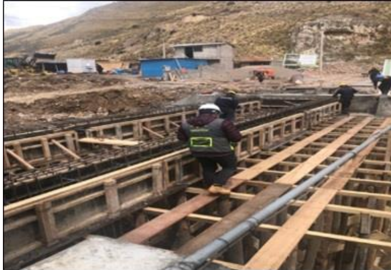
Figura 45. Encofrado de vigas principales del puente
