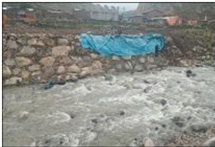
Figura 58. Acomodo de piedras para el enrocado
