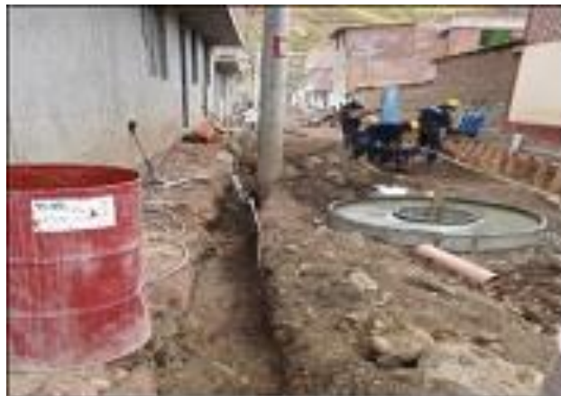
Figura 23. Corte superficial manual en vereda
