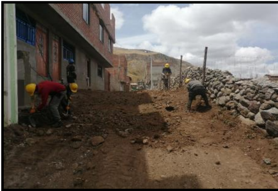
EN LA IMAGEN SE APRECIA LA LIMPIEZA MANUAL DEL TERRENO
