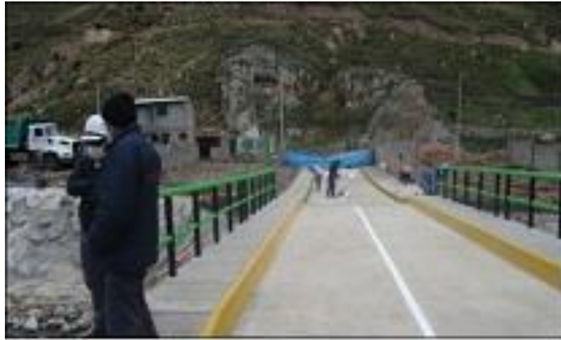
Figura 67. Limpieza final de obra
