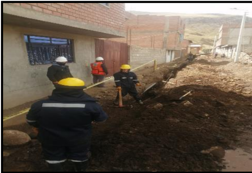
EN LA IMAGEN SE APRECIA LA EXCAVACION PARA TUBERIA DE MATRIZ DE AGUA POTABLE
