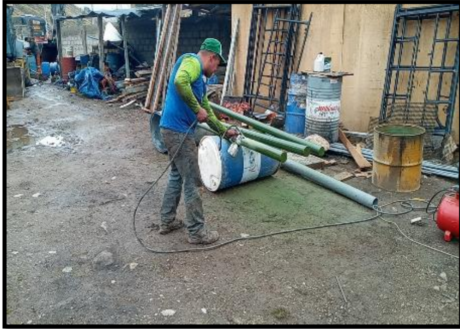
EN LA IMAGEN SE APRECIA EL PINTADO DEL TUBO PARA LA SEÑALIZACION INFORMATIVA
