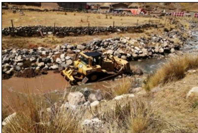
Figura 32. Limpieza y desbroce en el cauce del río
