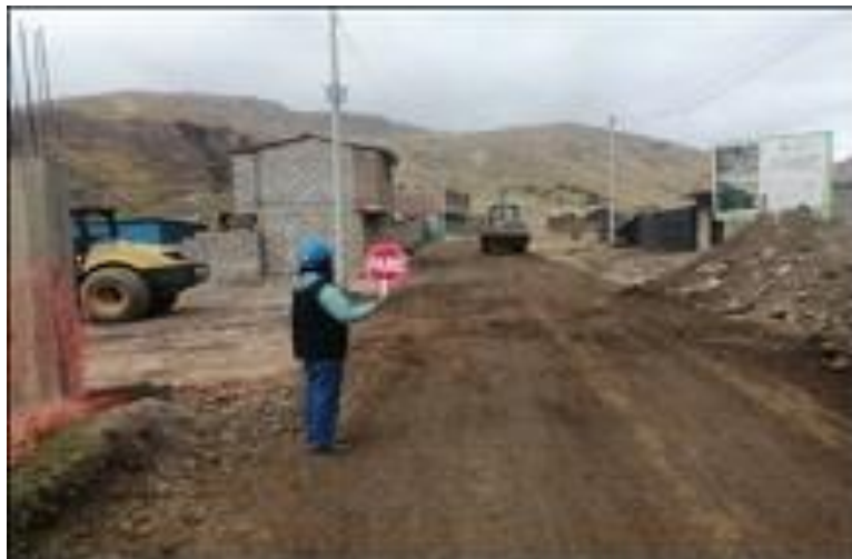
Figura 9. Cartel de obra ubicado en la Calle Huánuco
