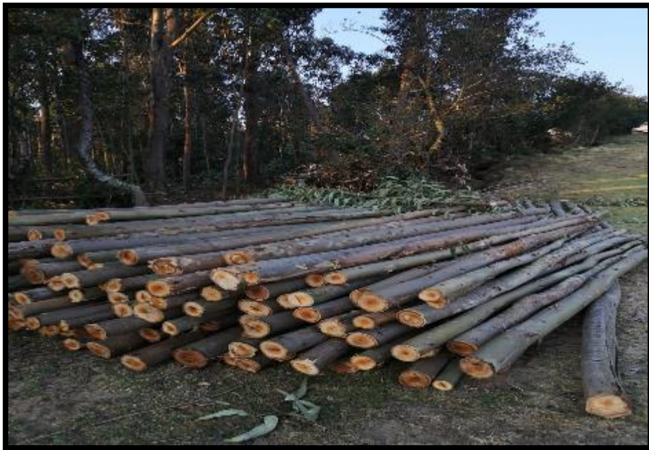
EN LA IMAGEN SE APRECIA LA HABILITACION DE PIES DERECHOS PARA EL ENCOFRADO DEL PUENTE
