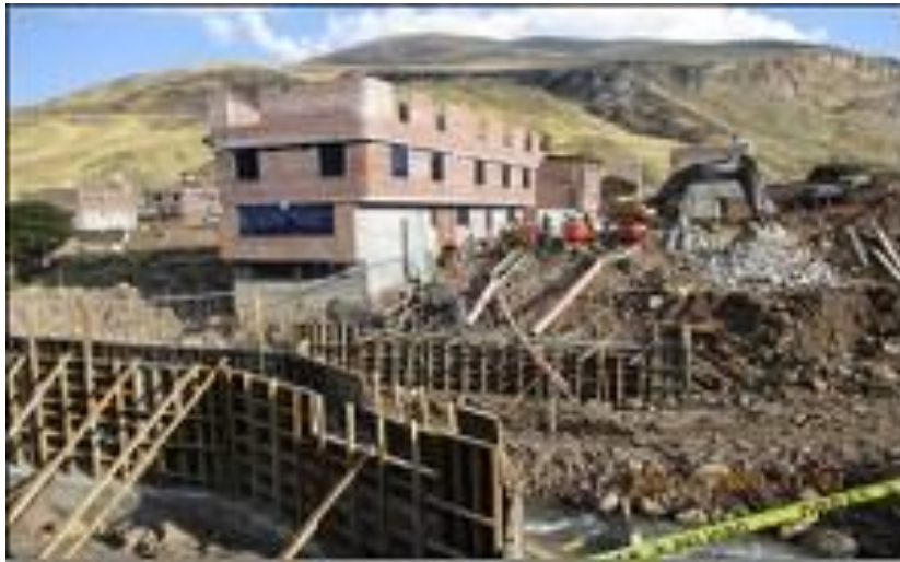
Figura 37. Acero en la cajuela de estribo del puente
