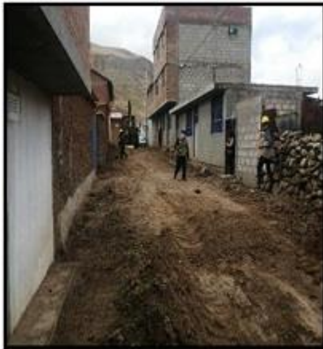
EN LA IMAGEN SE APRECIA LA LIMPIEZA Y DESBROCE DEL AREA DE TRABAJO
