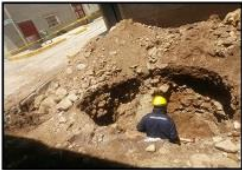
EN LA IMAGEN SE APRECIA LA EXCAVACION A PULSO DE BUZON
