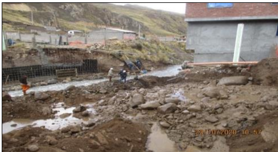
Figura 41. Excavación y encofrado en estribos y aleros
