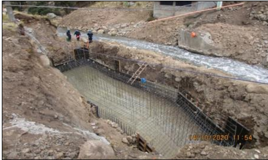
Figura 42. Vaciado de concreto en solado, estribo y aleros
