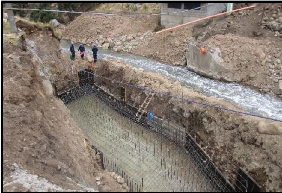
EN LA IMAGEN SE APRECIA EL ARMADO DE ACERO PARA LA ZAPATA DEL ESTRIBO Y ALEROS
