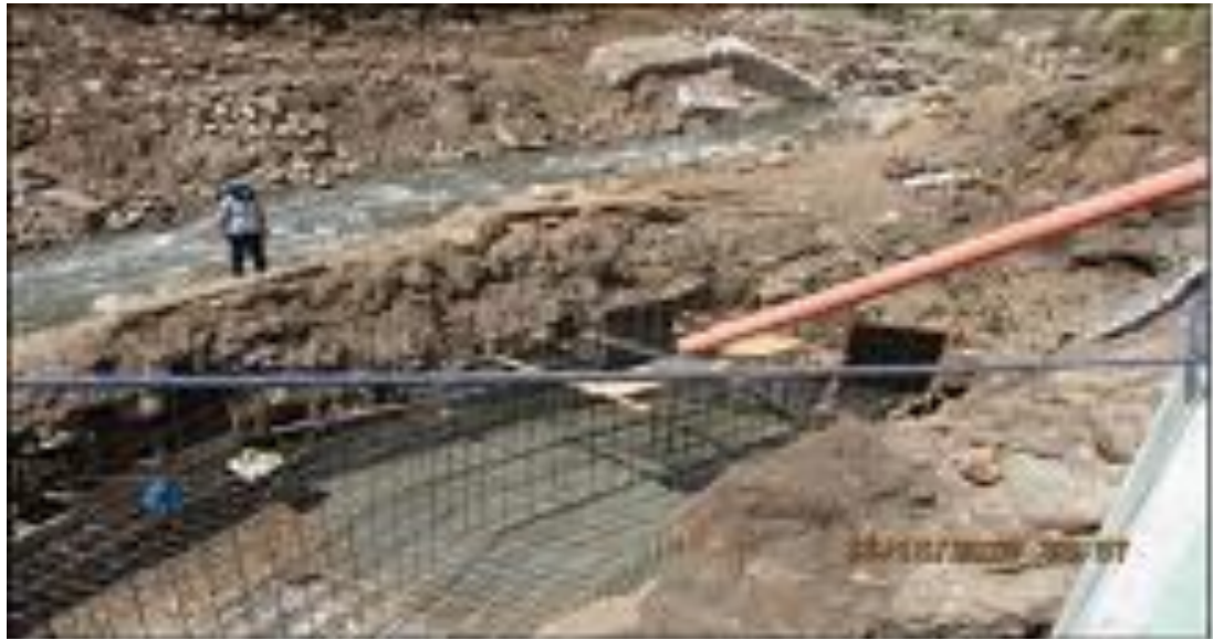
Figura 43. Vaciado de concreto en la zapata del estribo y aleros
