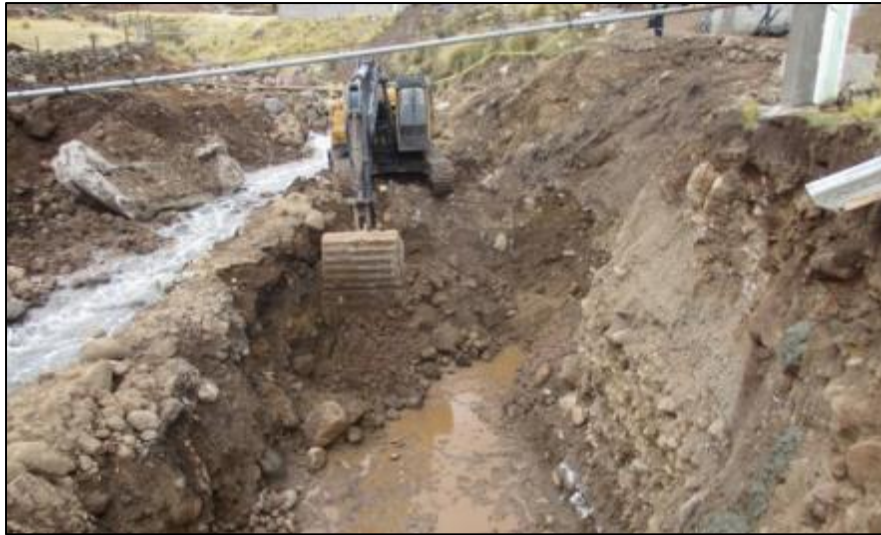
Figura 34. Excavación para solado de estribo del puente
