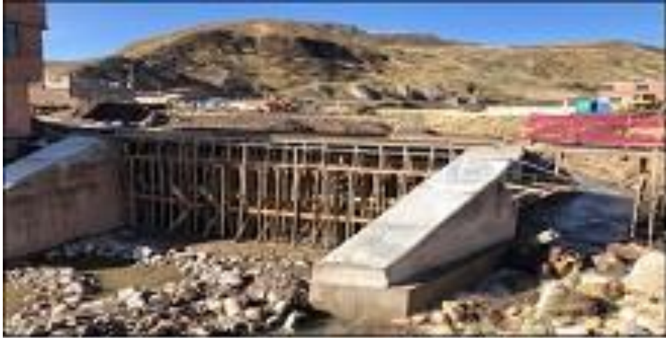
Figura 55. Montaje de madera en falso puente
