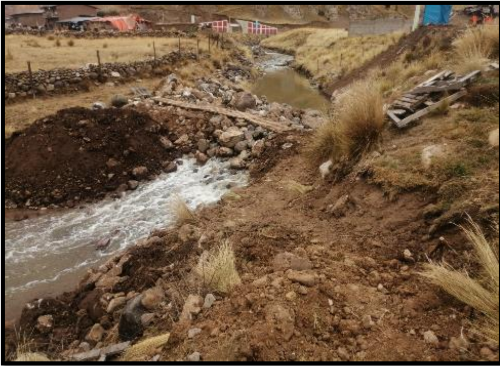
EN LA IMAGEN SE APRECIA EL CRUCE DE DESVIO PROVISIONAL
