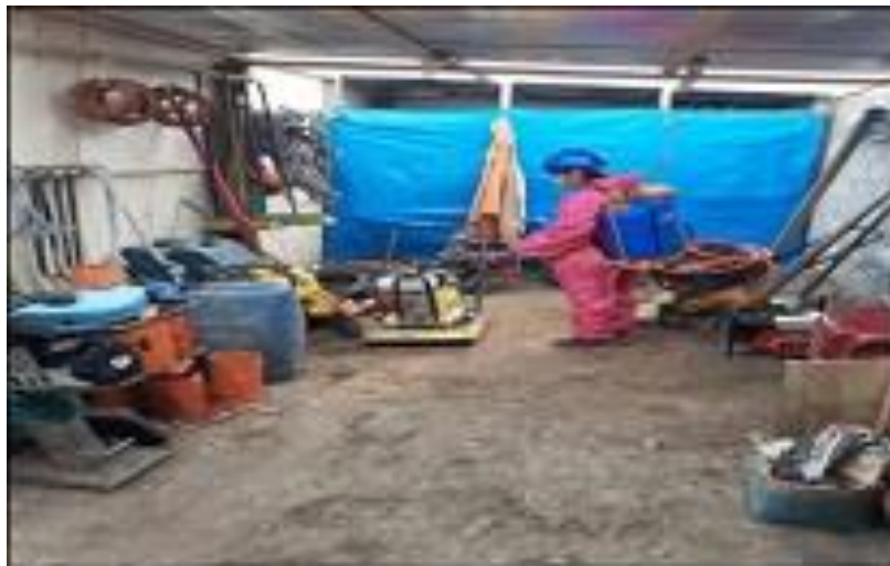
Figura 5. Almacén de obra
