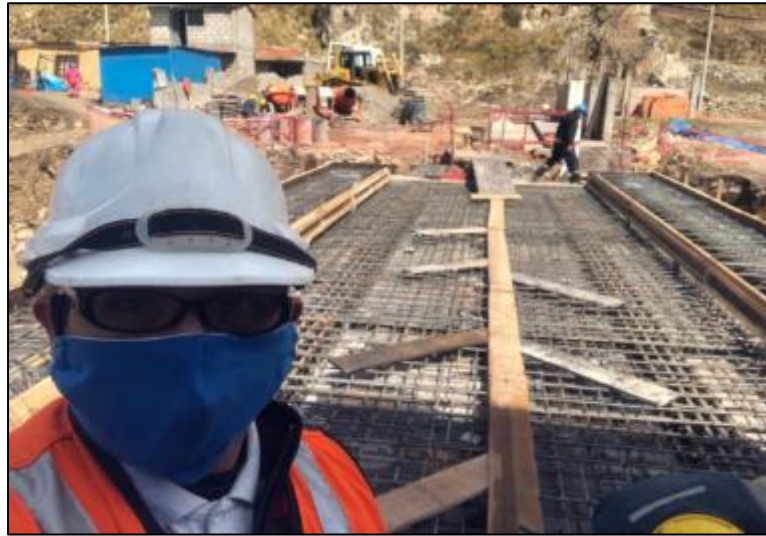
Figura 47. Supervisión del armado de acero en el puente
