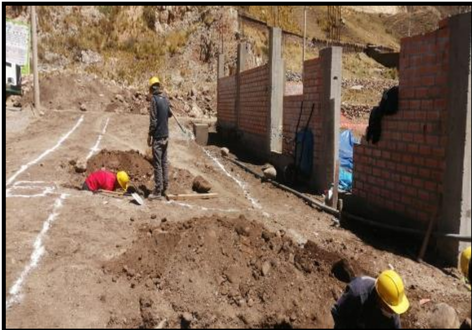
EN LA IMAGEN SE APRECIA EL TRAZO Y REPLANTEO PARA PAVIMENTO EN LA CALLE LIBERTAD EN EL LADO IZQUIERDO
