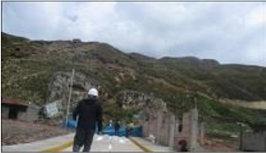
Figura 64. Pintado señalización horizontal, Calle Libertad
