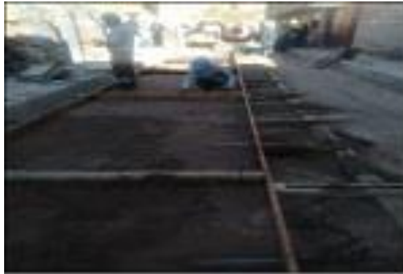
Figura 20. Colocación de acero en la calzada
