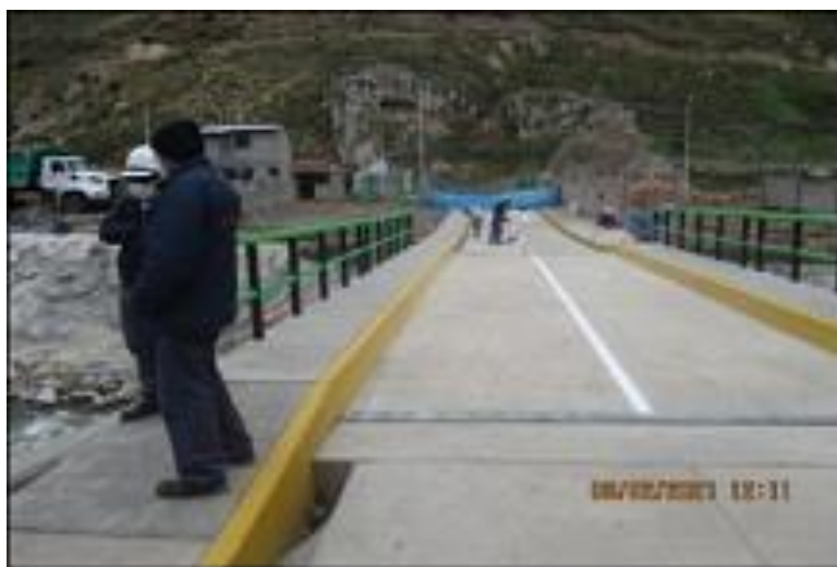
Figura 52. Puntado de la baranda metálica
