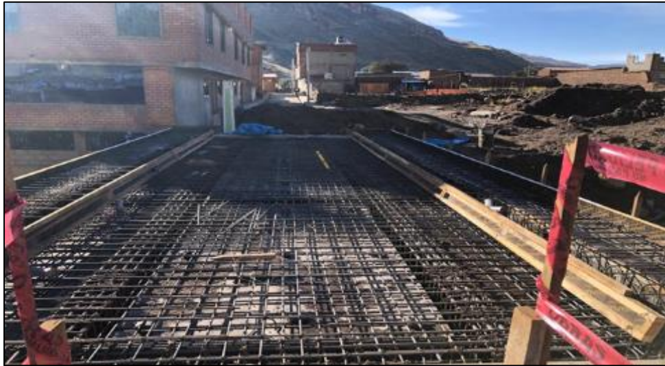
Figura 46. Armado de acero en losa y acera peatonal del puente
