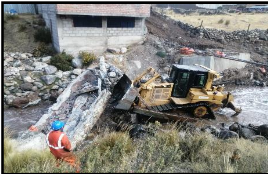
EN LA IMAGEN SE APRECIA LA DEMOLICION DEL PUENTE PEATONAL EXISTENTE
