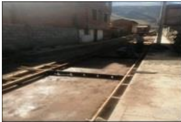
Figura 21. Colocación de dowells en la calzada
