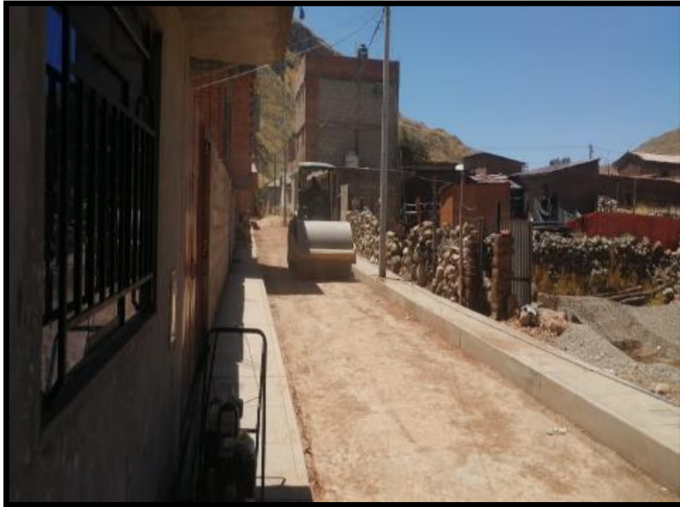
EN LA IMAGEN SE APRECIA EL COMPACTADO A NIVEL DE SUBASE
