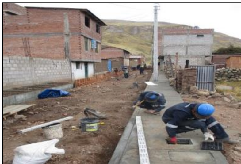
Figura 25. Vaciado de concreto en vereda
