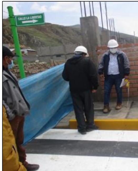
Figura 66. Señalización en la Calle Libertad
