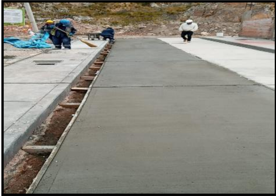
EN LA IMAGEN SE APRECIA EL ACABADO EN PAVIMENTO
