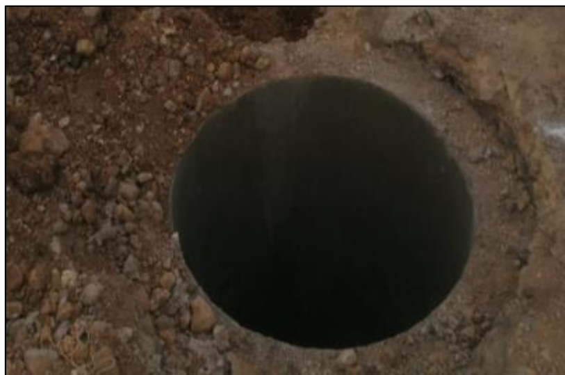
Figura 31. Construcción de buzón
