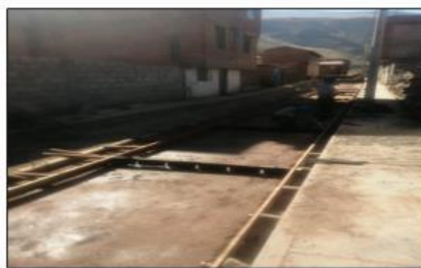
Figura 22. Encofrado y desencofrado del pavimento
