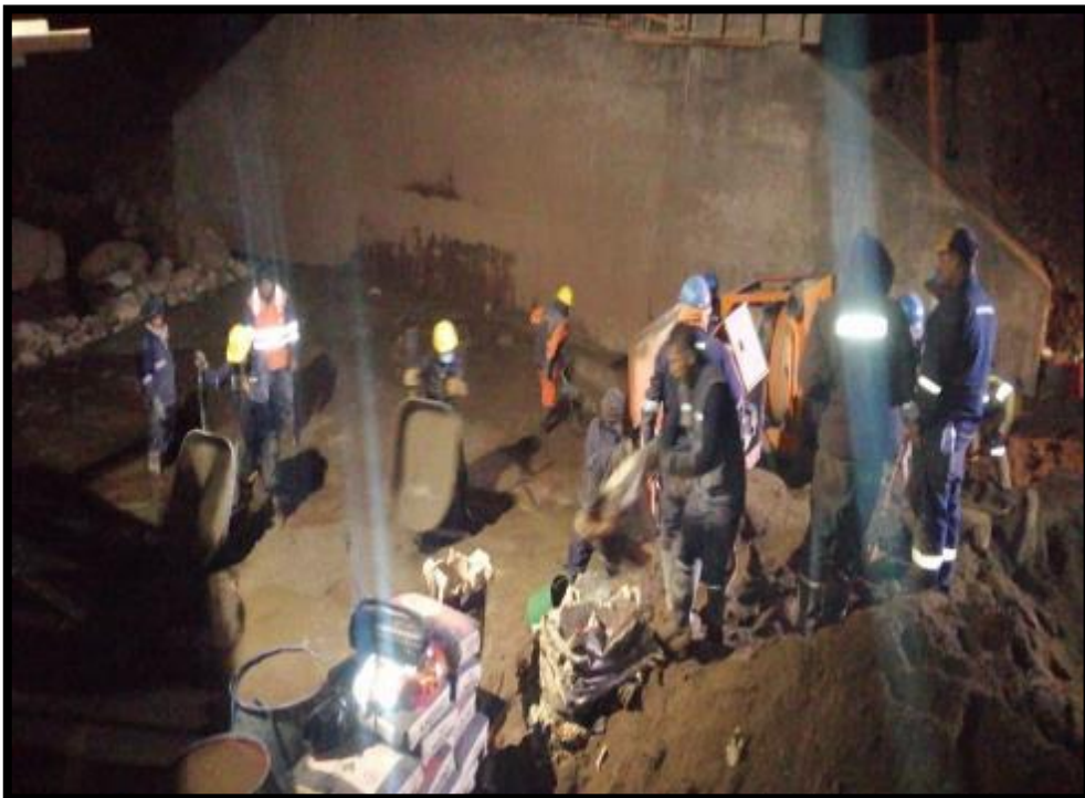
EN LA IMAGEN SE APRECIA EL EMBOQUILLADO EN PUENTE
