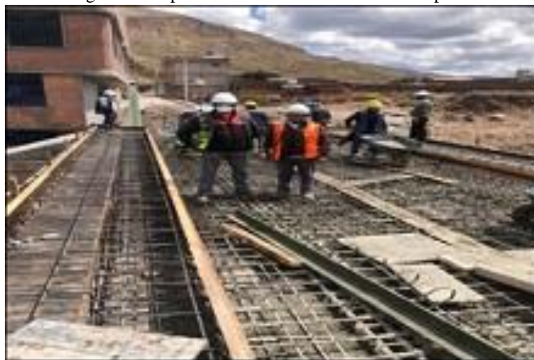
Figura 48. Personal técnico verificando el armado de acero
