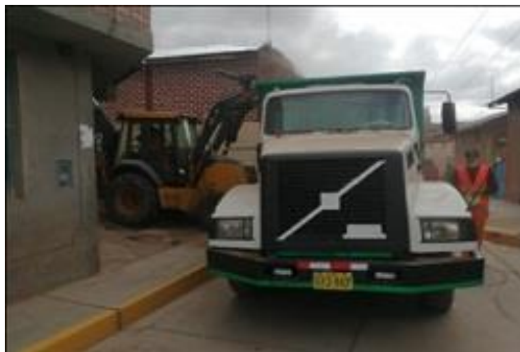
Figura 35. Transporte para eliminación de material excedente
