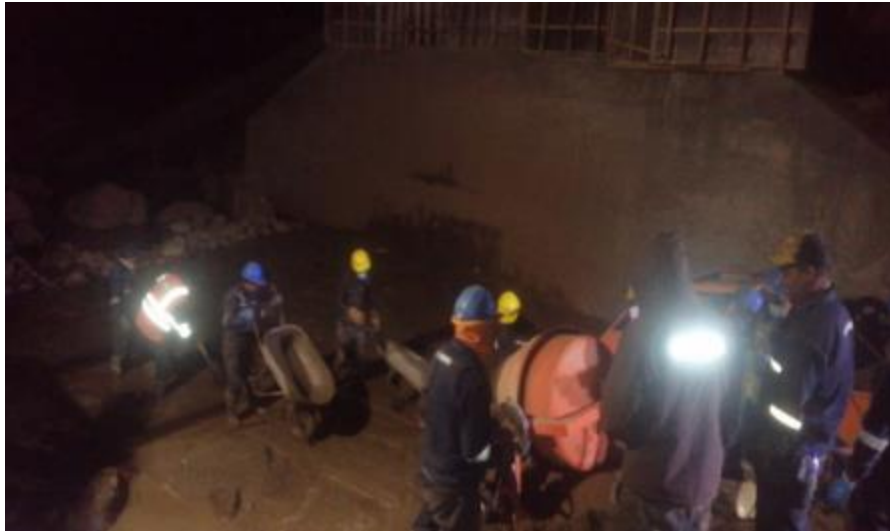
Figura 53. Emboquillado de piedra en el puente
