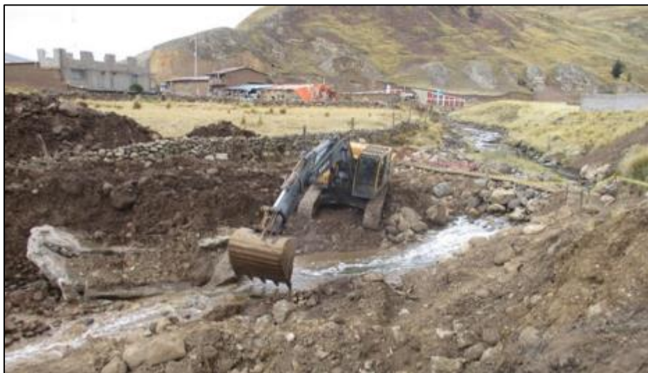
Figura 33. Encauzamiento del río en la margen derecha
