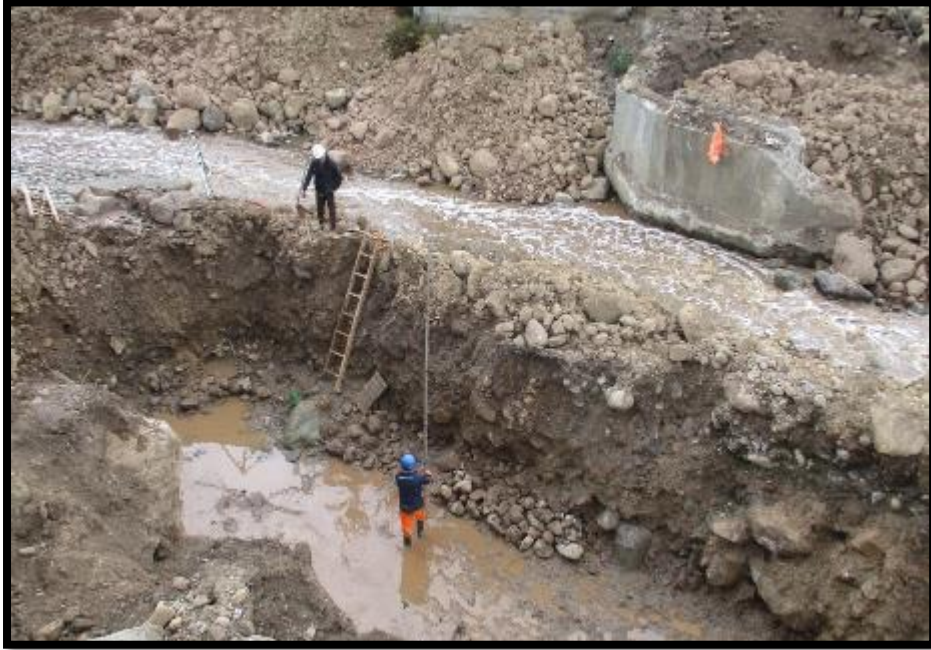
EN LA IMAGEN SE APRECIA EL CONTROL DE ALTURA PARA LA EXCAVACION DEL ESTRIBO DEL PUENTE
