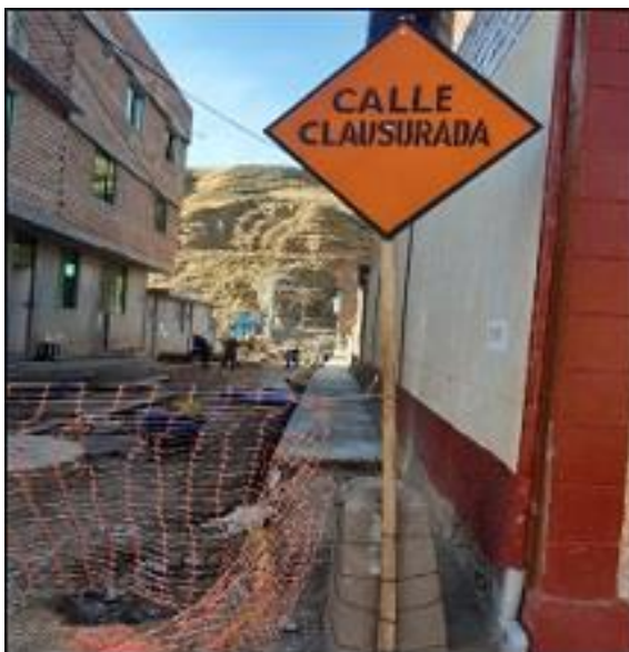
Figura 12. Señalización temporal en la Calle Lima
