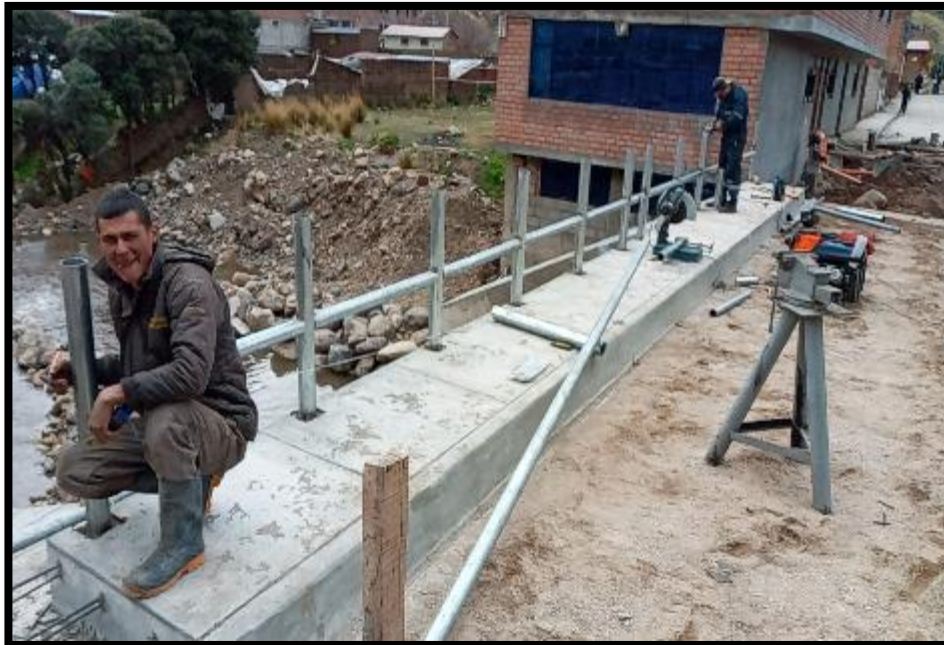
EN LA IMAGEN SE APRECIA LA INSTALACION DE LA BARANDA EN EL PUENTE
