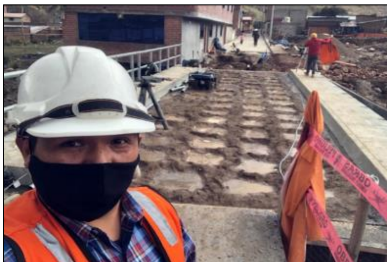
Figura 49. Curado de la losa del puente
