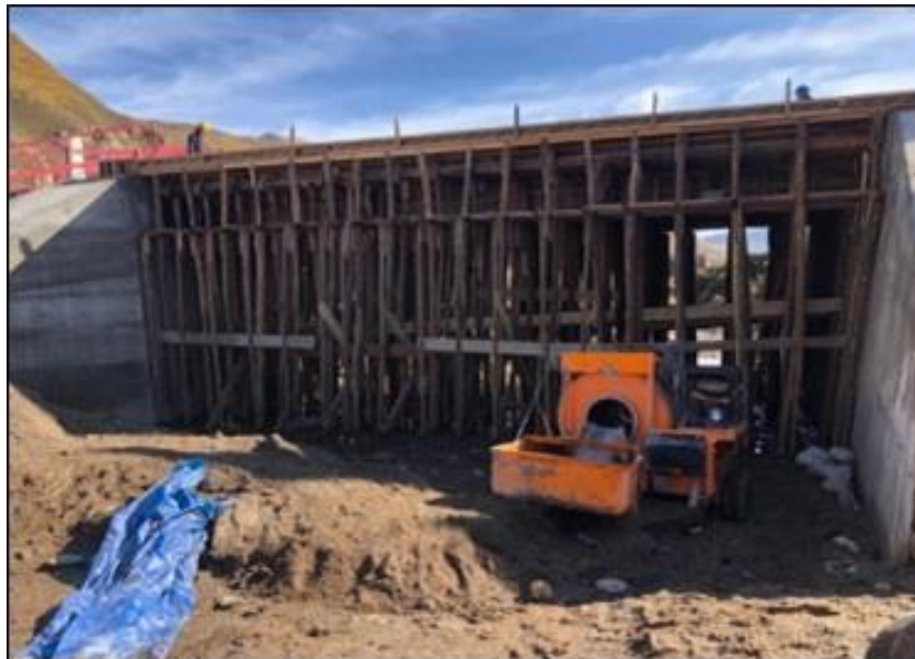
Figura 44. Encofrado para vigas y diafragma del puente
