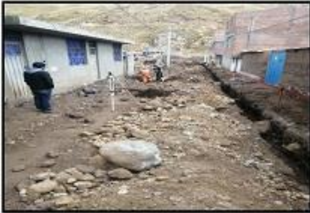
EN LA IMAGEN SE APRECIA EL CONTROL TOPOGRAFICO EN LA CALLE LIBERTAD
