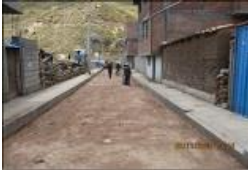
Figura 18. Extendido, riego y compactado de subbase
