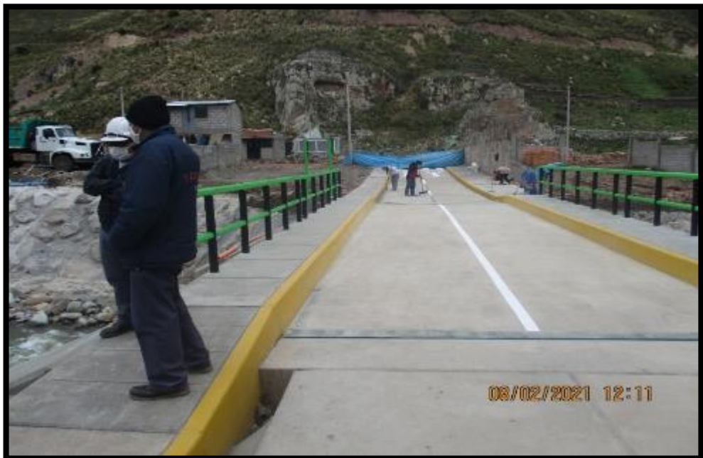
EN LA IMAGEN SE APRECIA LA PARTIDA DE LIMPIEZA FINAL DE OBRA
