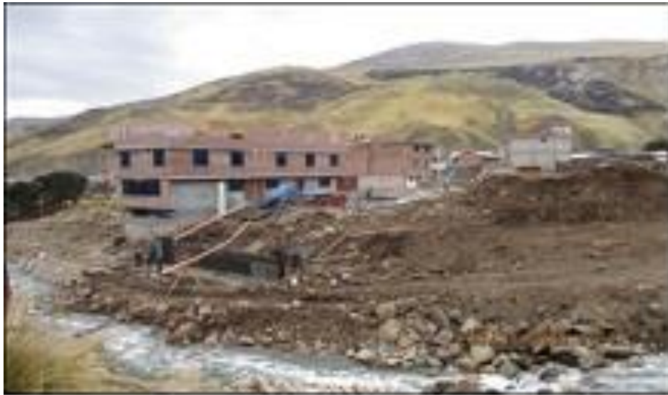
Figura 39. Encofrado y desencofrado de cajuela de puente
