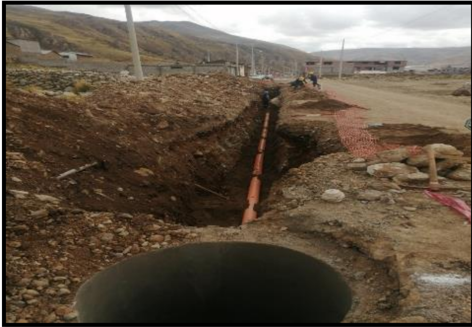
EN LA IMAGEN SE APRECIA EL TENDIDO DE TUBERIA DE DESAGUE SOBRE LA CAMA DE APOYO
