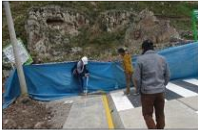
Figura 62. Pintura en el cruce peatonal
