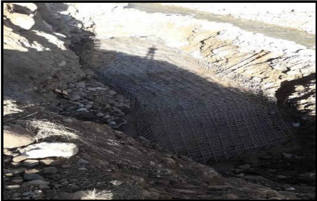
EN LA IMAGEN SE APRECIA LA HABILITACION E INSTALACION DE ACERO EN ZAPATA Y ALEROS EN EL PUENTE
