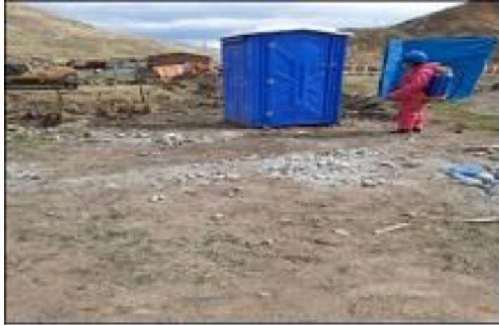
Figura 8. Servicio higiénico de obra: baño portátil
