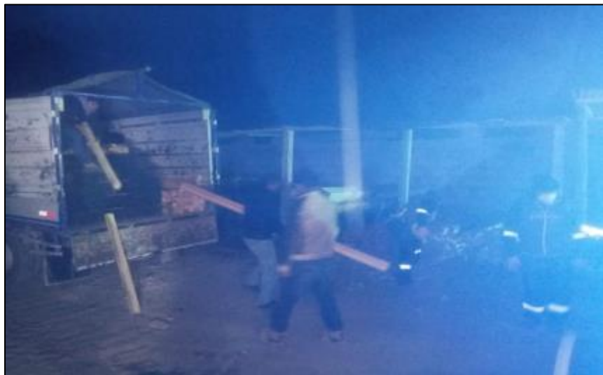
Figura 54. Descargo de material para motaje de falso puente
