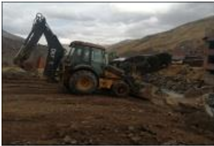
Figura 17. Extendido del relleno y compactado
