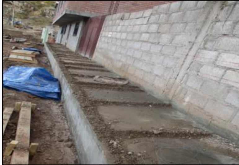
Figura 26. Curado de concreto con arrocera
