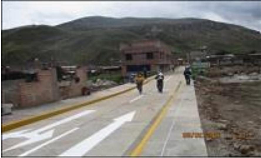
Figura 63. Pintado señalización horizontal
