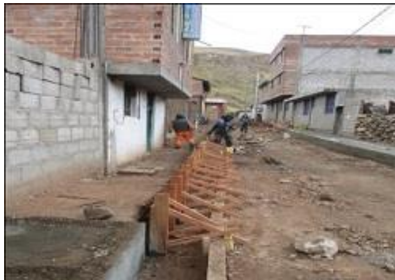
Figura 24. Encofrado y desencofrado en vereda
