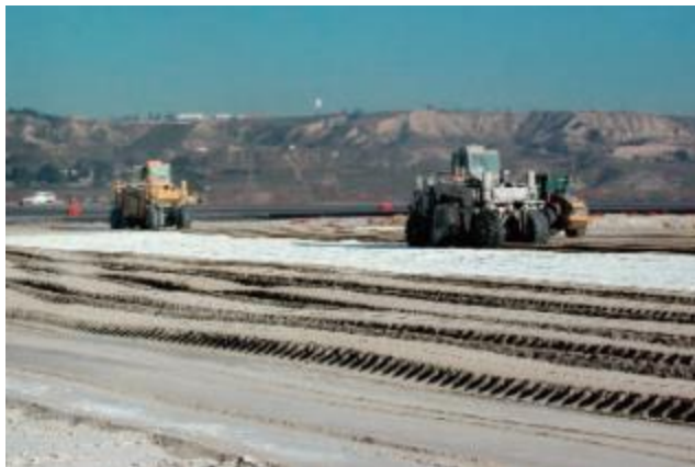
Estabilización de los suelos con cal
