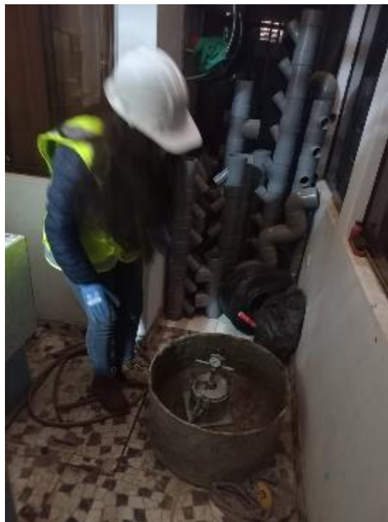
Fotografía 08: Proceso de control de la expansión de los suelos
