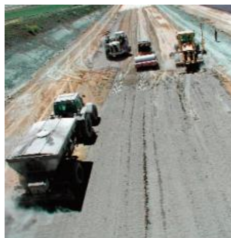
Estabilización de los suelos con cemento
