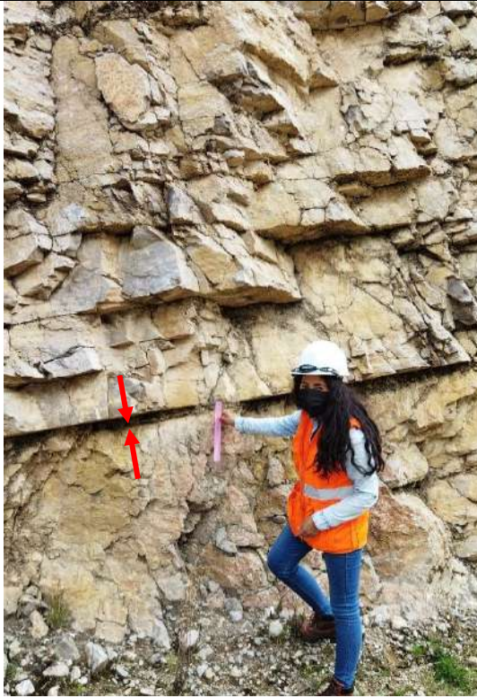
PANEL FOTOGRÁFICO OCTUBRE 2021 FOTOGRAFÍA 29 Distinción y medición de aberturas e identificación del material de relleno: materiales finos suaves mayor a 5 mm entre discontinuidades con una regla graduada al milímetro en EG 02 .
