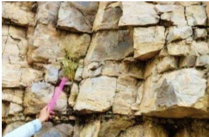
Figura 12. Alteración biológica y física entre discontinuidades del talud. Tomada de «Ingeniería geológica», por González de Vallejo, Luis I., et al. , 2002, p. 253.
