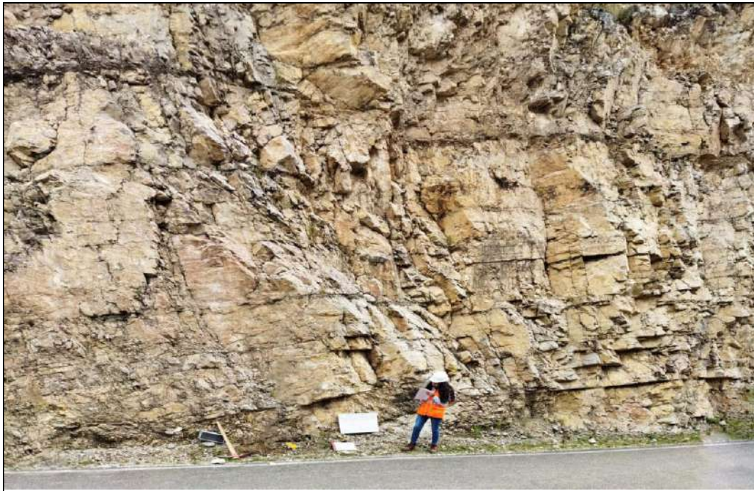
PANEL FOTOGRÁFICO OCTUBRE 2021 FOTOGRAFÍA 01 Vista panorámica de la estación geomecánica EG 01 del talud en estudio entre las progresivas del km 18+683 al 18+695.20, donde se aprecia las discontinuidades y la composición mineralógica tipo caliza color beige y gris claro.
