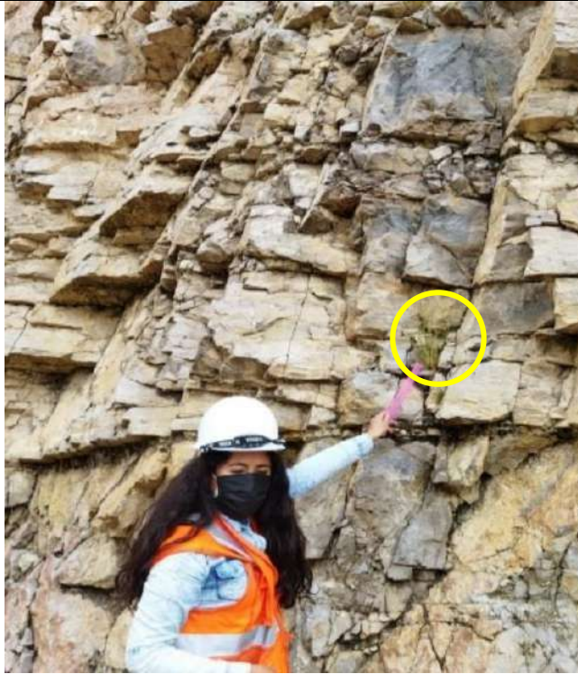
PANEL FOTOGRÁFICO OCTUBRE 2021 FOTOGRAFÍA 33 Identificación visual y valoración de la alteración por factores biológicos entre las discontinuidades del macizo rocoso del talud de la carretera puente Collpa–Yanacancha.
