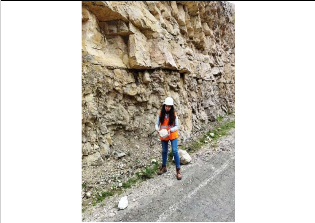
PANEL FOTOGRÁFICO OCTUBRE 2021 FOTOGRAFÍA 11 Toma de muestras in situ de roca con medidas mayores a 15 cm x 15 cm por estaciones geomecánicas para determinación de la densidad y absorción de la roca según norma internacional ASTM C97-18.
