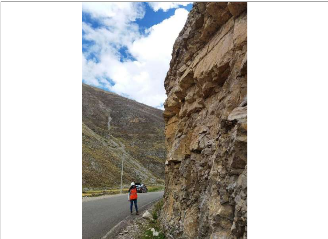
PANEL FOTOGRÁFICO OCTUBRE 2021 FOTOGRAFÍA 08 Vista panorámica del talud en corte, se aprecia la característica geométrica del talud: Altura.
