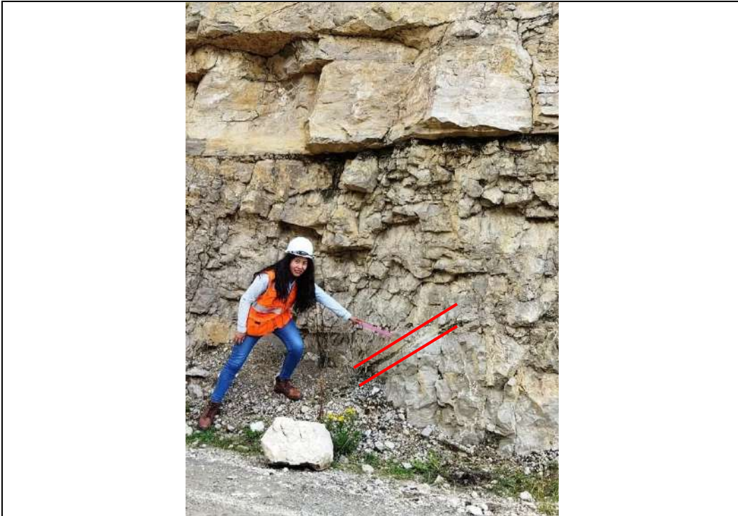
PANEL FOTOGRÁFICO OCTUBRE 2021 FOTOGRAFÍA 35 Identificación visual del método de excavación del talud en la carretera puente Collpa-Yanacancha: fotografías muestran indicios de voladura controlada mediante incursión de taladros al interior del talud en estación geomecánica EG 03 .
