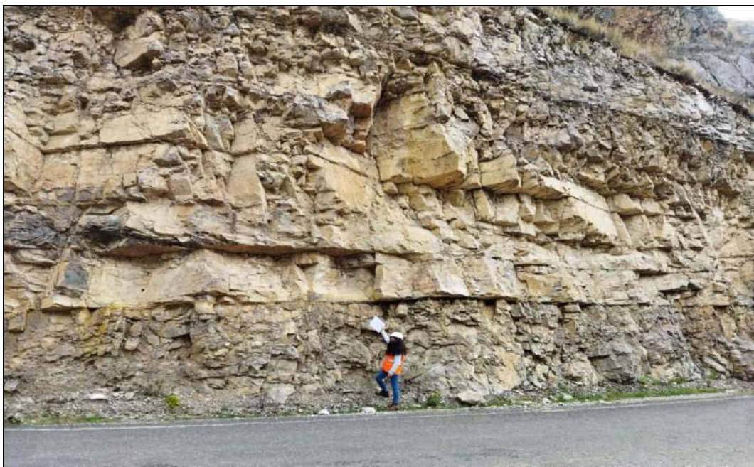
PANEL FOTOGRÁFICO OCTUBRE 2021 FOTOGRAFÍA 02 Vista panorámica de la estación geomecánica EG 02 del talud en estudio entre las progresivas del km 18+695.20 al 18+708, donde se aprecia las discontinuidades y la composición mineralógica tipo caliza color beige y gris claro.
