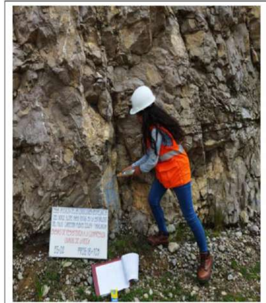
FOTO 02.- ENSAYO DE ESCLEROMETRIA, "APLICACIÓN DE LAS CONDICIONES GEOMECÁNICAS DEL ÍNDICE SLOPE MASS RATING EN LA ESTABILIDAD DEL TALUD CARRETERA PUENTE COLLPA - YANACANCHA"- ESTACIÓN GEOMECÁNICA 02
