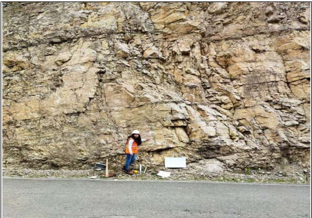
PANEL FOTOGRÁFICO OCTUBRE 2021 FOTOGRAFÍA 30 Identificación de rugosidades en la superficie del talud. Se visualiza la superficie ligeramente rugosa perteneciente a la estación geomecánica EG 02 .
