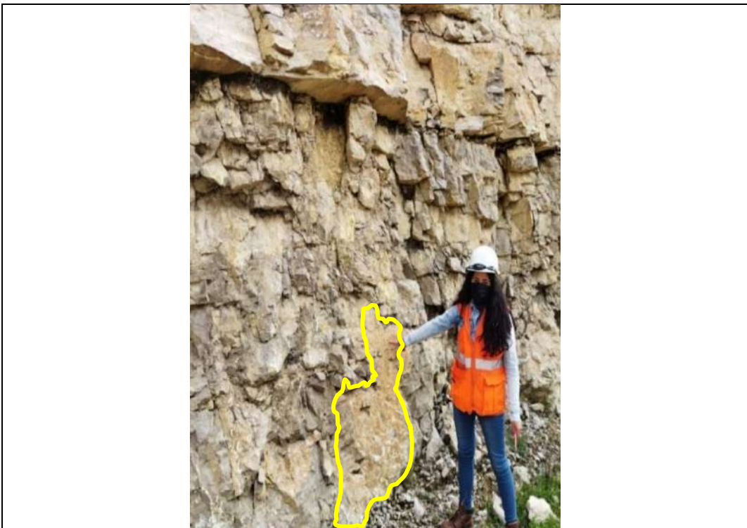
PANEL FOTOGRÁFICO OCTUBRE 2021 FOTOGRAFÍA 32 Identificación visual y valoración de la alteración físico-químico en las discontinuidades del macizo rocoso del talud de la carretera puente Collpa-Yanacancha.
