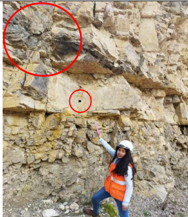
PANEL FOTOGRÁFICO OCTUBRE 2021 FOTOGRAFÍA 34 Identificación visual del método de excavación del talud en la carretera puente Collpa–Yanacancha: fotografías muestran indicios de voladura controlada mediante incursión de taladros al interior del talud en estación geomecánica EG02.
