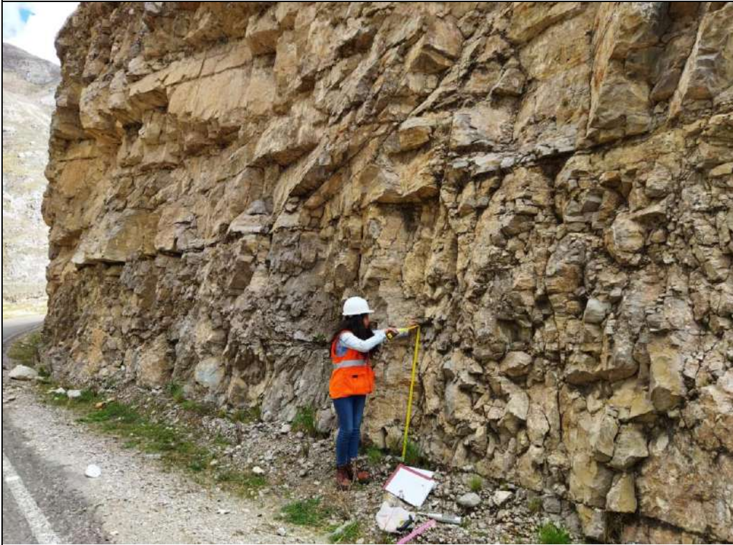
PANEL FOTOGRÁFICO OCTUBRE 2021 FOTOGRAFÍA 27 Mapeo geomecánico: medición con flexómetro de la persistencia en estación geomecánica EG 02 en el talud.
