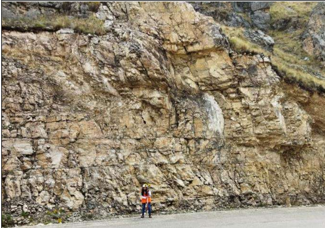
PANEL FOTOGRÁFICO OCTUBRE 2021 FOTOGRAFÍA 03 Vista panorámica de la estación geomecánica EG 03 del talud en estudio entre las progresivas del km 18+708 al 18+720.18, donde se aprecia las discontinuidades y la composición mineralógica tipo caliza color beige y gris claro.
