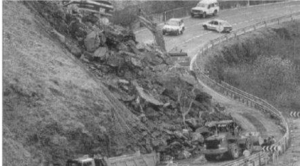
Figura 24. Bloqueo de carretera a causa de deslizamiento de rocas por falla planar. Tomada de «Mecánica de rocas: Fundamentos e Ingeniería de taludes», por Ramírez y Alejano, 2004, p. 288.
