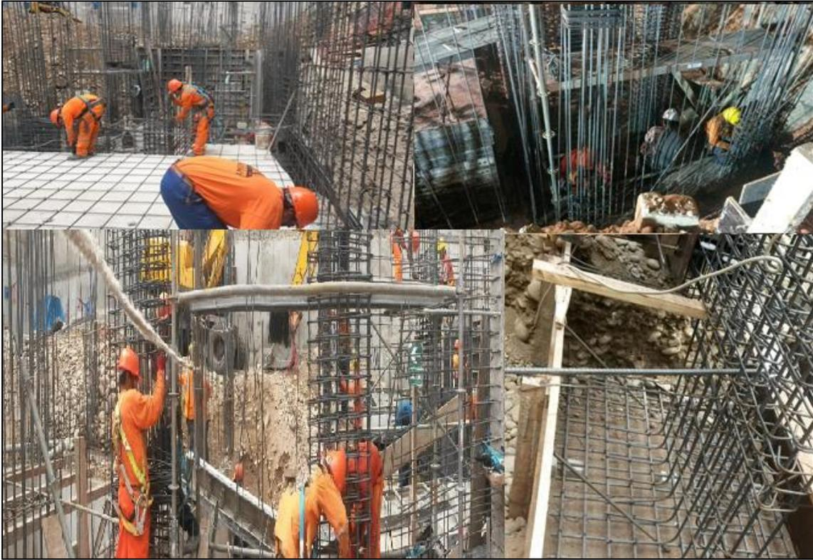
Figura N° 43. Colocación de acero en placas, cimentación y columnas
