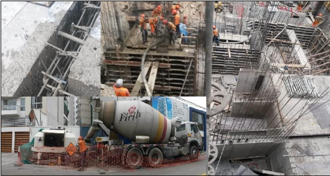
Figura N° 53. Partida de concreto  $f'c=210 \text{ kg/cm}^2$
