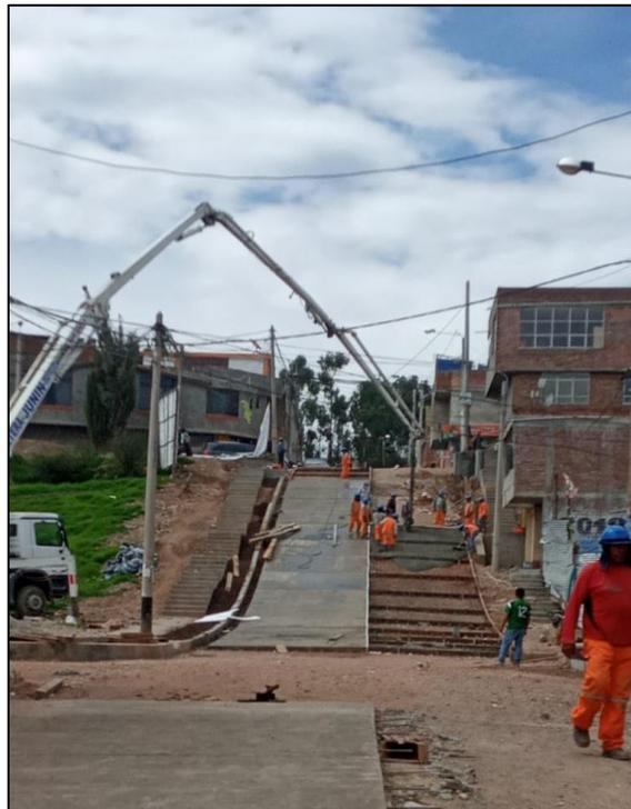
Fotografía 9 Vista del bombeado del concreto premezclado en el Jr. Las Turquesas entre el Jr. Ricardo Neira y el Jr. Los Rubies
