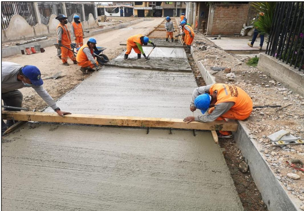
Fotografía 7 Vista del vaciado de concreto premezclado en el Jr. Las Turquesas entre el Jr. Dos de mayo y el pasaje Los Guindales.
