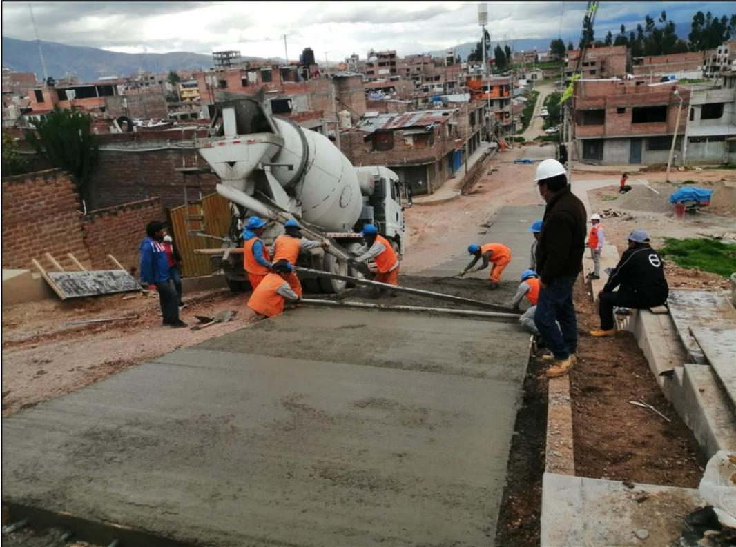
Fotografía 8 Vaciado del concreto premezclado en el Jr. Las Turquesas entre el pasaje Los Guindales y el Jr. Ricardo Neyra.
