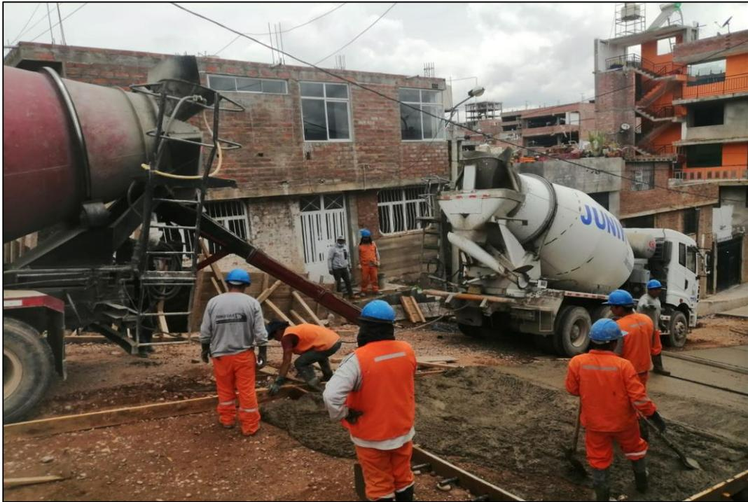
Fotografía 6 Vista del vaciado de concreto elaborado en obra para el Jr. Diamantes entre el Jr. Los Brillantes y el Jr. Los Grafitos.
