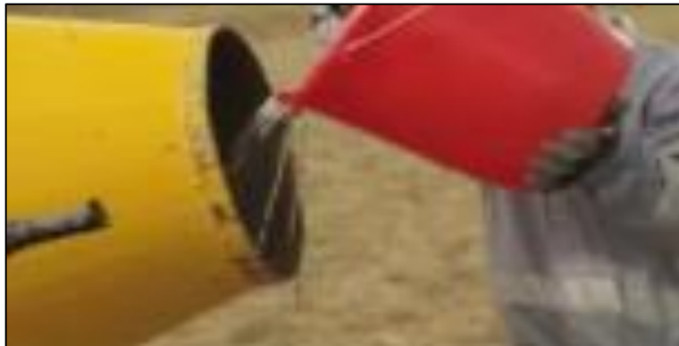
Figura 6: Agua con aditivo en la concretera.
