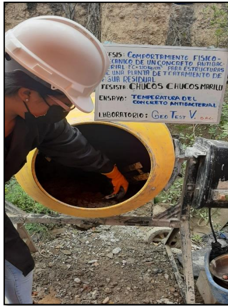
Fotografía 23: Medición de la temperatura del concreto antibacterial. Según NTP 339.184.
