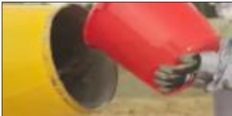
Figura 4: Agua en la concretera.
