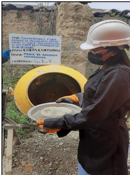
Fotografía 12: Vista de materiales tales como cemento para la elaboración del concreto convencional. Según NTP 339.183.
