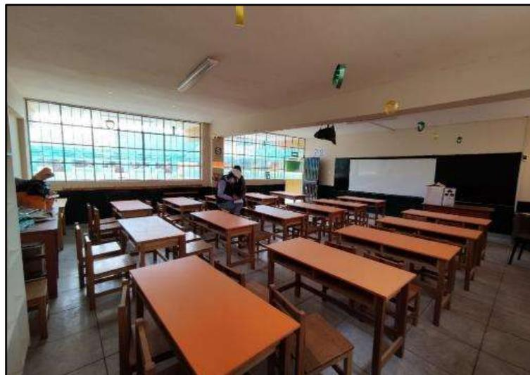
Fotografía N° 68. Presencia de escritorios y muebles no arriostrados a ningún elemento estructural.
