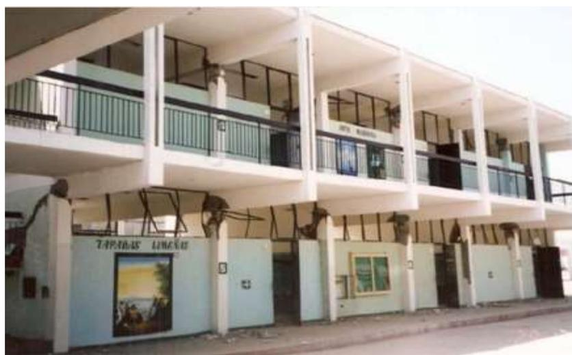
Figura 2. Colegio Santa Ana, con efecto de daño al producirse un fenómeno de columna corta
