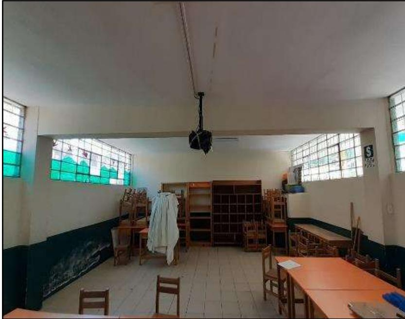
Fotografía N° 5. Vista interior del aula N°2 del pabellón E, se puede observar la parte inferior del diafragma rígido está cubierto con tarrajeo y pintura.
