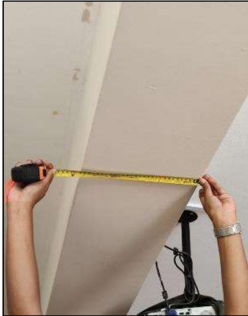
Fotografía N° 37. Registro y medición de ancho de base de la Viga peraltada VP-102, ubicado en el 1er piso, aula N°2- Pabellón “D”.
