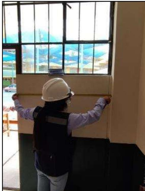
Fotografía N° 38. Medición de ancho del alfeizer aislado del pórtico, ubicado en el 1er piso, aula N°2 - Pabellón “D”.
