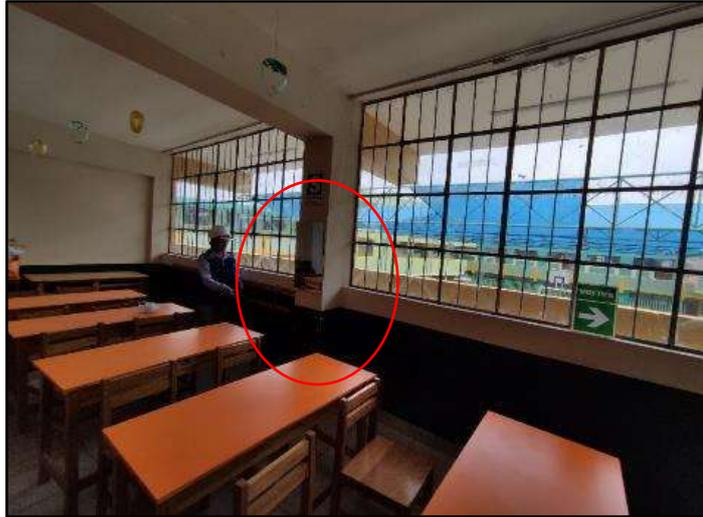
Fotografía N° 71. Presencia de columna arriostrada a la albañilería, sin junta de dilatación, columna ubicada en el aula N°6, 2do piso - pabellón “E”.
