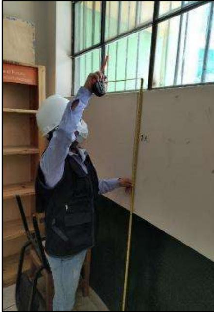
Fotografía N° 33. Medición de la altura del alfeizer aislado del pórtico, ubicado en el 1er piso, aula N°3- Pabellón “D”.
