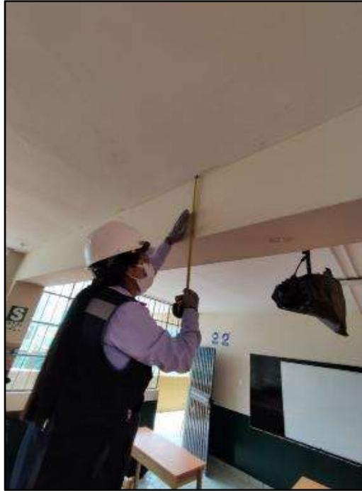
Fotografía N° 67. Registro y medición de peralte de la Viga VP-202, ubicado en el aula N°5 – 2do piso, Pabellón “E”.
