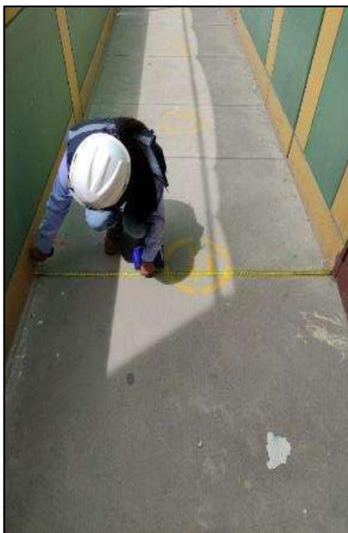
Fotografía N° 41. Medición y registro de ancho de voladizo del pabellón “D” – 2do Nivel.
