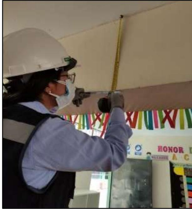
Fotografía N° 53. Registro y medición de peralte de la Viga peraltada VP-103, ubicado en el aula N°3 – 1er piso, Pabellón “E”.
