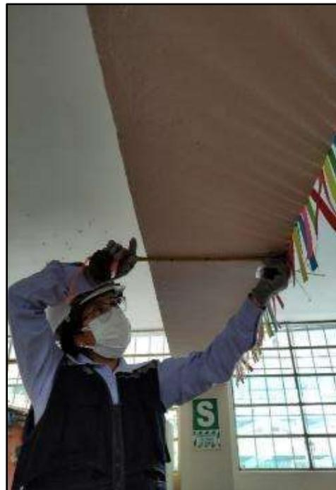
Fotografía N° 52. Registro y medición de ancho de base de la Viga VP-103, ubicado en el aula N°3 – 1er piso, Pabellón “E”.
