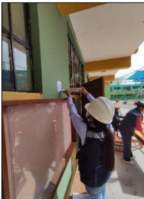
Fotografía N° 23. Toma de muestras según la norma ASTM C805 (Ensayo de Esclerometría), para la estimación de la resistencia del concreto en la columna C-2, “Pabellón D”.
