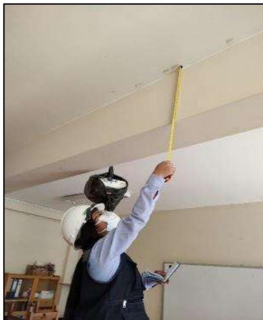
Fotografía N° 36. Registro y medición de peralte de la Viga peraltada VP-103, ubicado en el 1er piso, aula N°2- Pabellón “D”.
