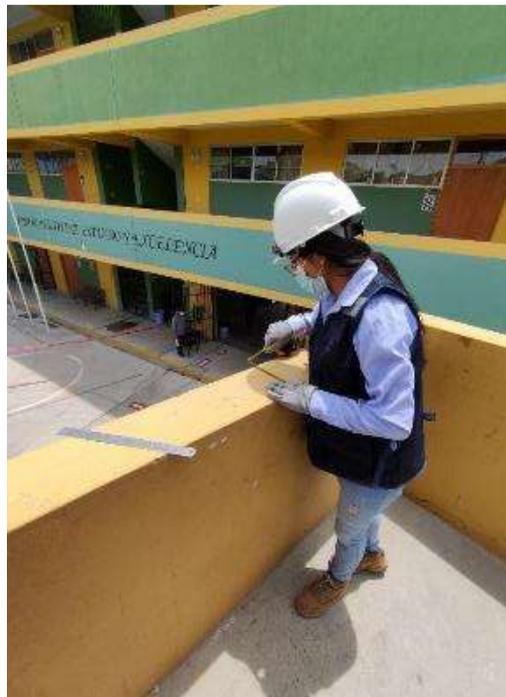
Fotografía N° 74. Medición y registro de ancho de muro no estructural (parapeto) de voladizo del pabellón “E” – 2do Nivel
