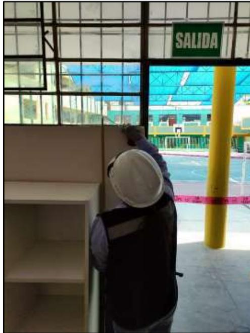
Fotografía N° 55. Registro y medición de altura de alfeizer y ventana, ubicado en el eje 2, aula N°3 – 1er piso, Pabellón “E”
