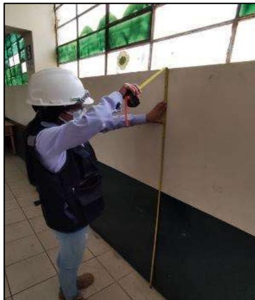
Fotografía N° 46. Medición de altura del alfeizer ubicado en el 1er piso, aula N°2 - Pabellón “E”.
