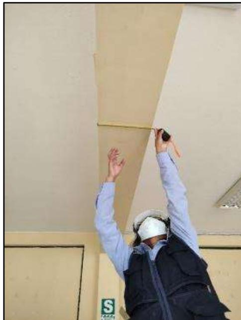
Fotografía N° 40. Registro y medición de ancho de base de la Viga peraltada VP-101, ubicado en el 1er piso, aula N°1- Pabellón “D”.
