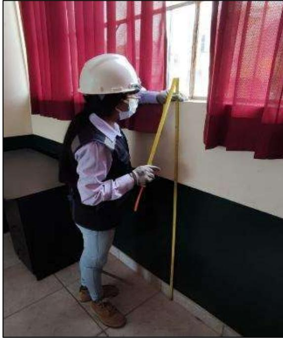
Fotografía N° 61. Registro y medición de altura de alfeizer, ubicado en el eje 3, aula N°4 – 2do piso, Pabellón “E”.
