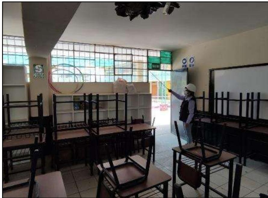
Fotografía N° 50. Se observa que la carpintería metálica se encuentra apoyada directamente a los elementos estructurales (viga – pórticos) en la edificación del aula N°3 – 1er piso, Pabellón "E".
