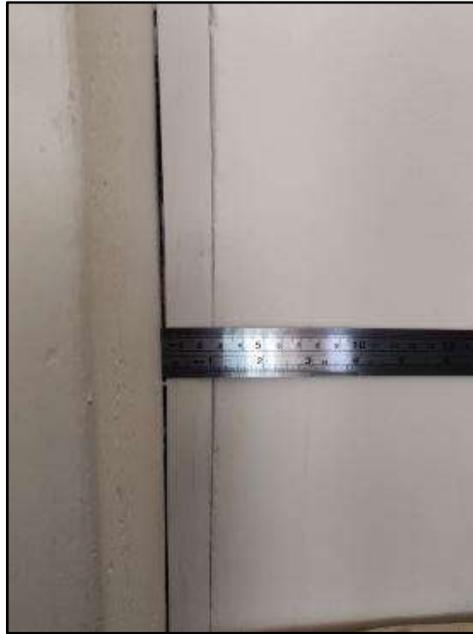
Fotografía N° 39. Junta de aislamiento sísmico de 2.5 cm entre columna y muro, aula N°1, pabellón “D”.
