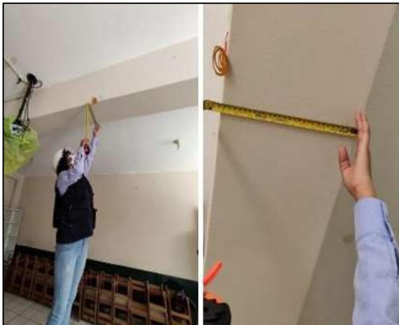
Fotografía N° 32. Medición del ancho y peralte de la Viga peraltada VP-103, ubicado en el 1er piso, aula N°3- Pabellón “D”.
