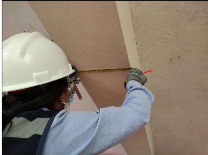
Fotografía N° 59. Registro y medición de ancho de base de la Viga peraltada VP-203, ubicado en el aula N°4 – 2do piso, Pabellón “E”.
