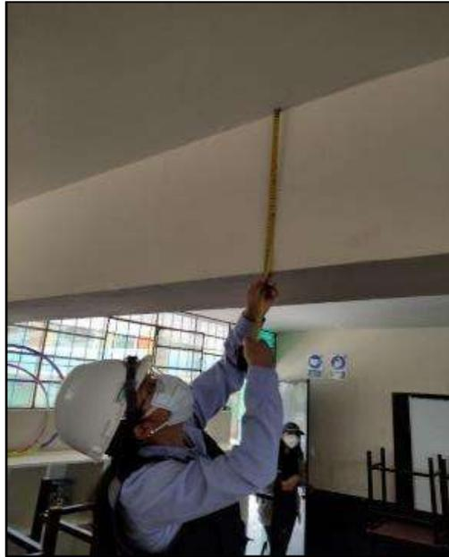
Fotografía N° 45. Registro y medición de peralte de la Viga peraltada VP-102, ubicado en el 1er piso, aula N°2- Pabellón “E”.
