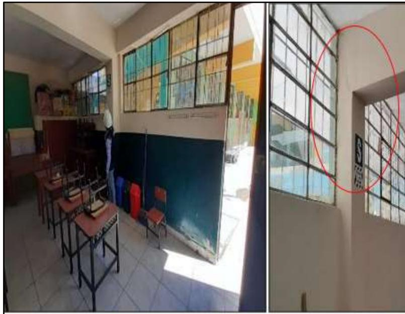
Fotografía N° 4. Vista interior del aula N°1 del Pabellón E, se puede observar la existencia de columna corta.
