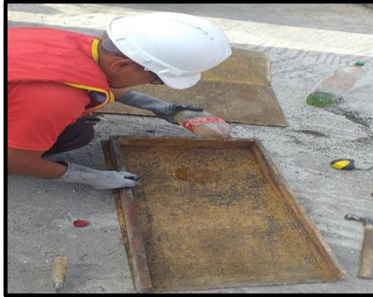
Fotografía N° 9. Curado de la madera, luego del encofrado y la mezcla de los elementos, se procede al vaciado, antes del vaciado de la mezcla se procedió al curado de la madera para que facilite el desencofrado del Teknoblok
