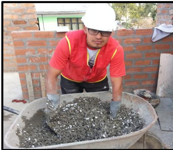
Fotografía N° 8. Mezcla de materiales, después del pesado de los materiales se procedió con la mezcla de los materiales con la ayuda de una carretilla tipo bugui y plancha de batir
