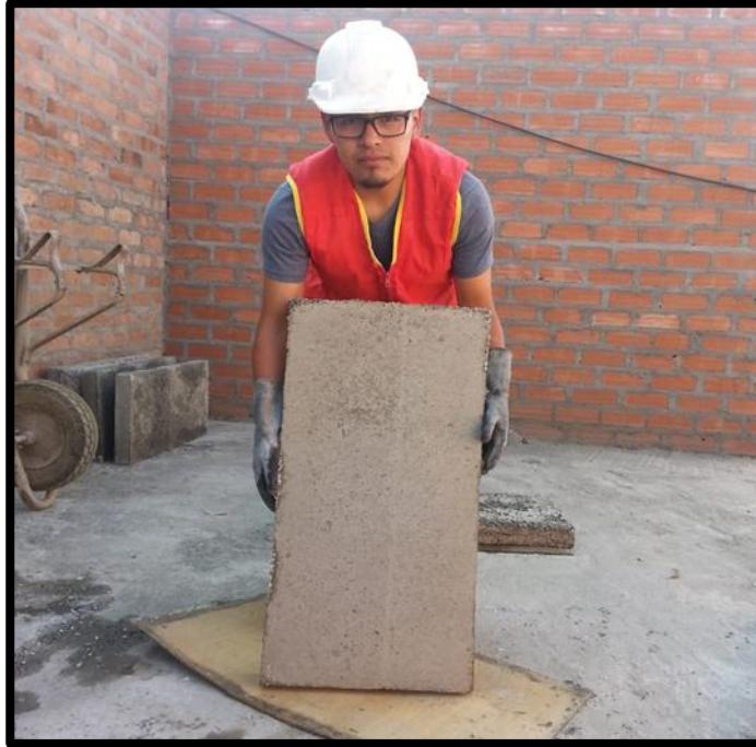
Fotografía N° 13. Obtención del Teknoblok de 80cm*40cm*6.5.
