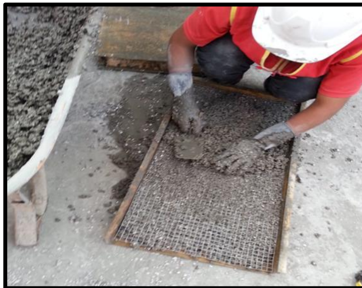
Fotografía N° 10. Vaciado y colocado de la malla de acero galvanizado. El proceso del vaciado de la mezcla, primero se realiza el vaciado de la mitad del encofrado, para luego a proceder al colocado de la malla de acero galvanizado.
