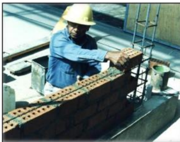
Figura 21. Muros de sistema de albañilería
