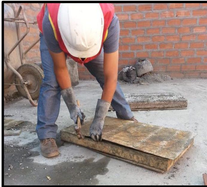
Fotografía N° 12. Desencofrado del Teknoblok, luego del fraguado de la mezcla se procedió al desencofrado del Teknoblok para posteriormente proceder al curado de la placa.
