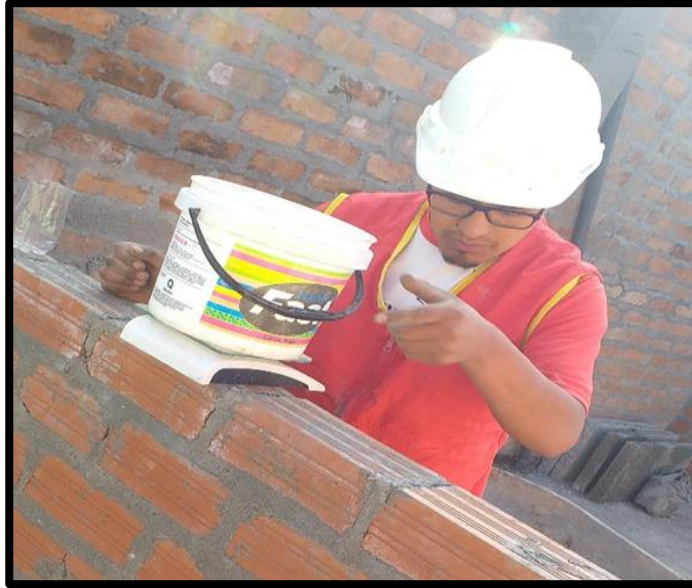
Fotografía N° 7. Tara para pesar los materiales, 4.5 L de agua y 200g de poliestireno expandido (Tecnopor), para ello se utilizó una balanza con aproximación de 1g.y antes de pesar cada uno de los elementos antes mencionados se procedió con la tara del recipiente
