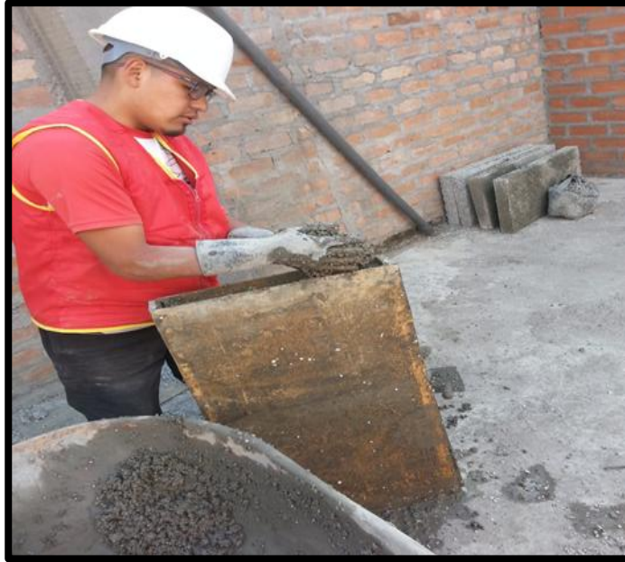
Fotografía N° 11. Vaciado en forma perpendicular del Teknoblok, luego se procede colocar el triplay de la cara descubierta para luego, colocar la placa en forma perpendicular realizar el chuseado de la mezcla.
