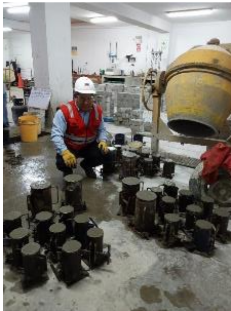
FIGURA N° 5. 25 :Vista de control de calidad del concreto f'c=175 kg/cm 2 experimental.
