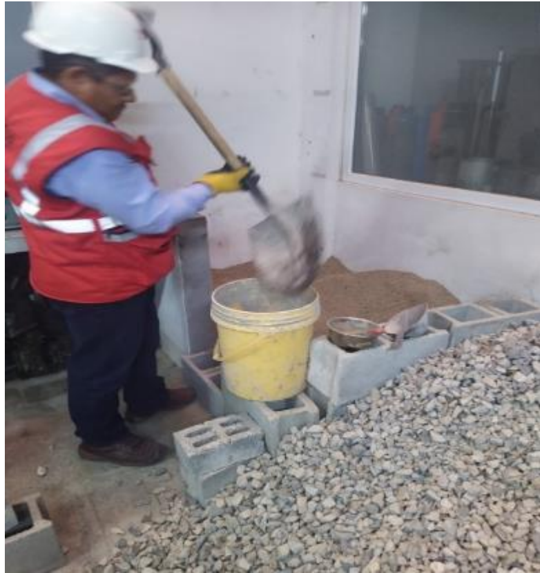
FIGURA N° 5. 16: Vista de selección de material de agregado fino y grueso.
