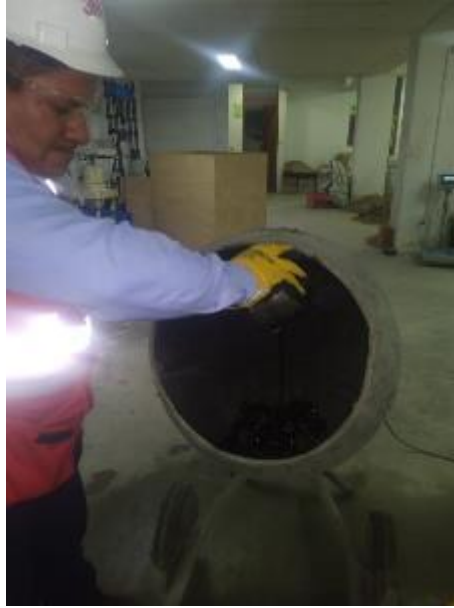
FIGURA N° 5. 20: Incorporación del acerite residual automotris al concreto f'c=175\text{kg/cm}^2 .
