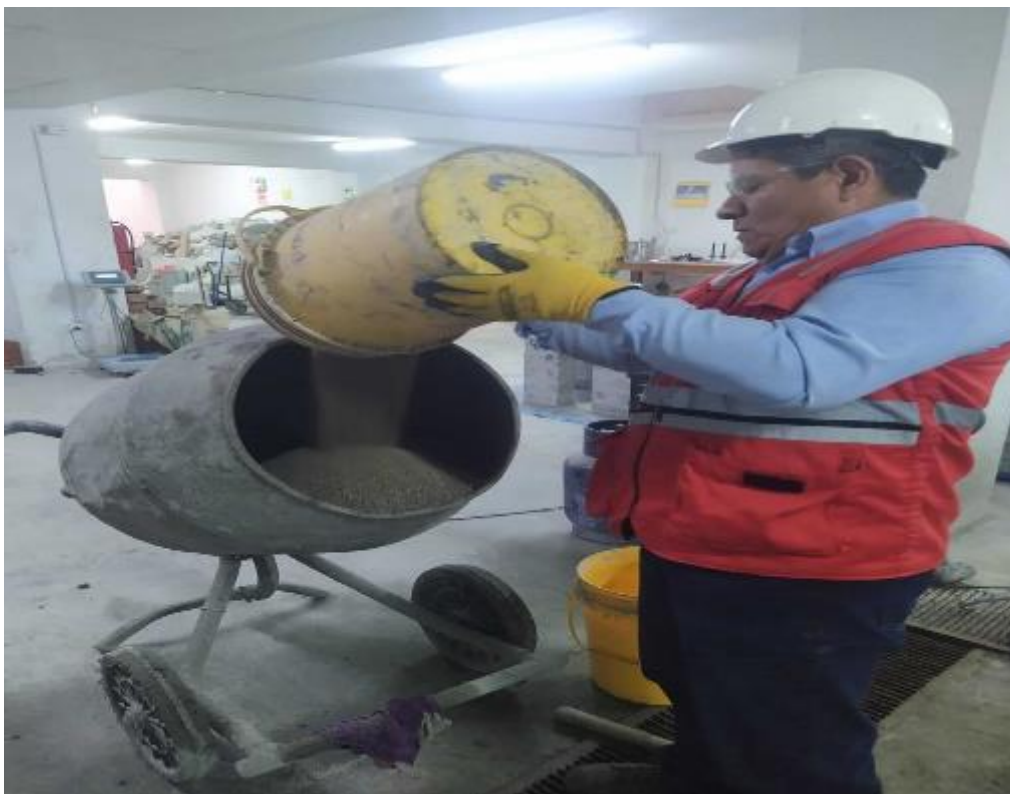
fotografía 4 preparación de concreto en trompo mezclador
