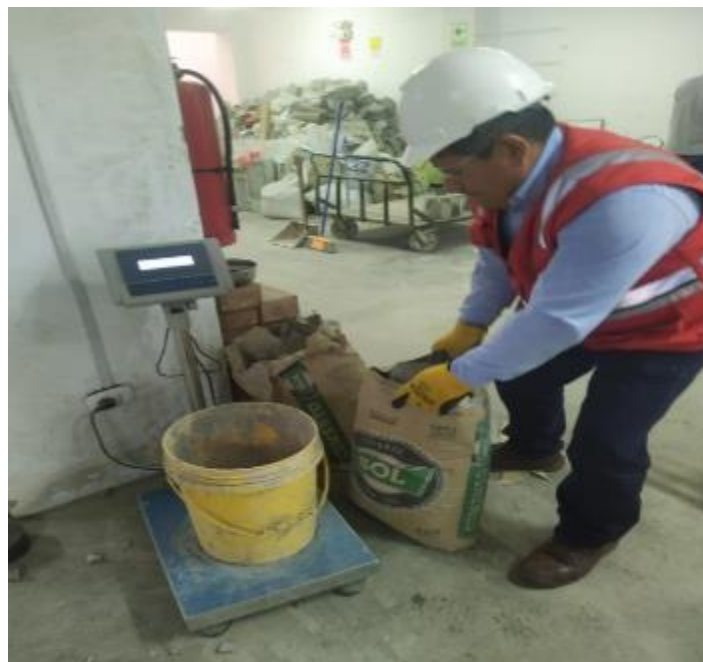
FIGURA N° 5. 17: Vista de selección de cemento sol tipo I por peso
