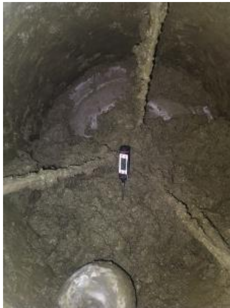
FIGURA N° 5. 21: Se toma la temperatura del concreto dentro del trompo mezclador
