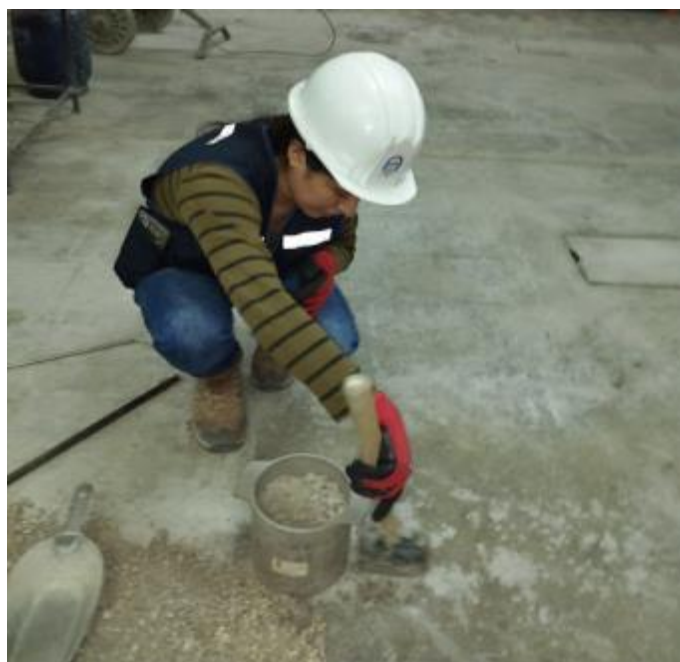
Figura N° 5. 23: Llenado del molde compactado
