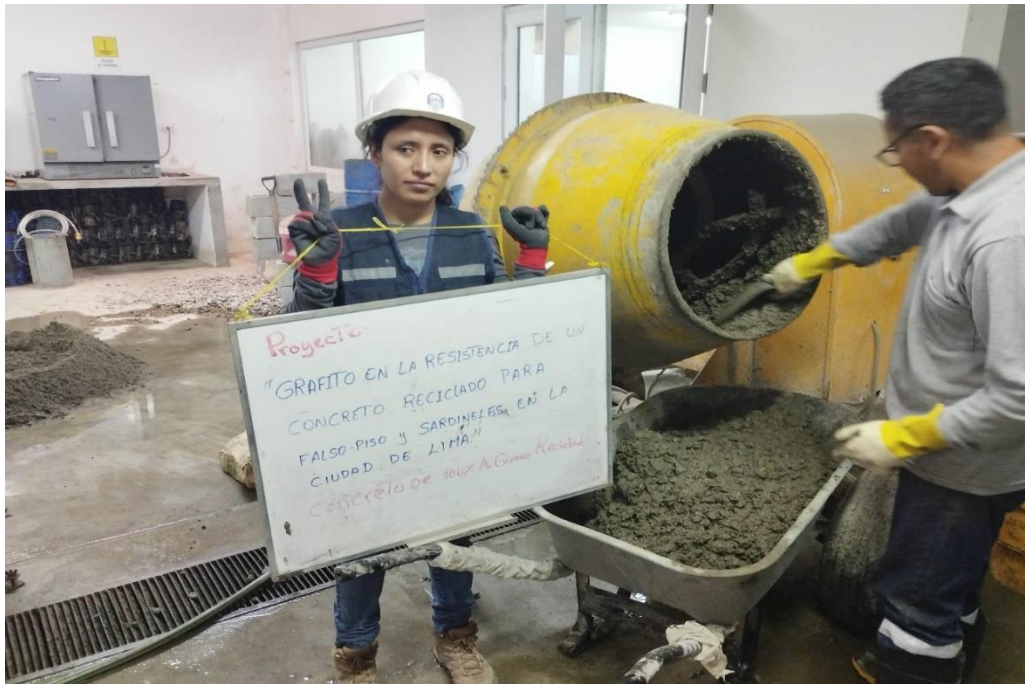
Fotografía N° 13: Mezcla del concreto reciclado
