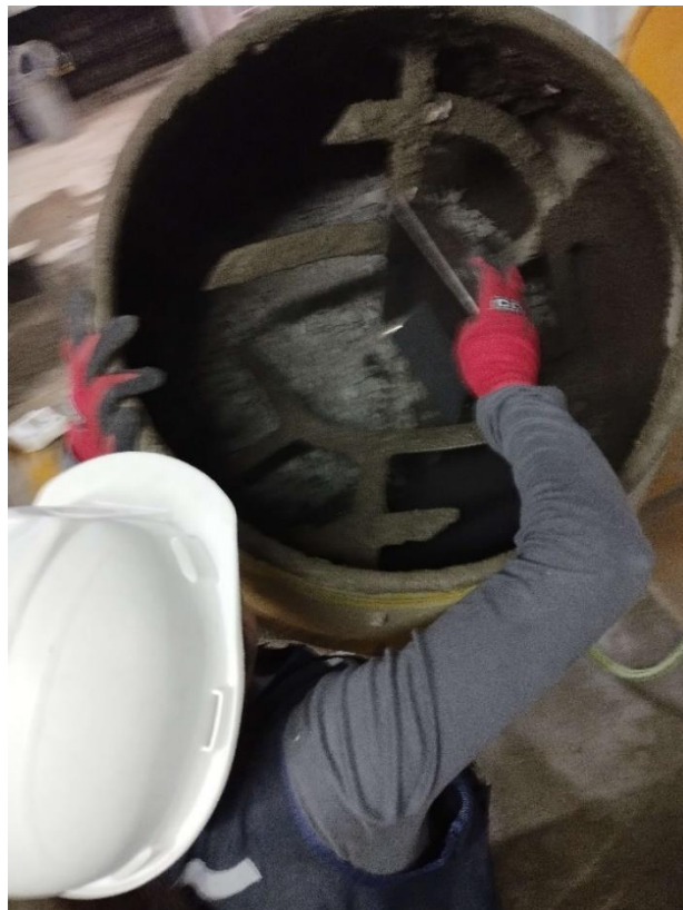
Fotografía N 14: Adición de Polvo de grafito al concreto reciclado
