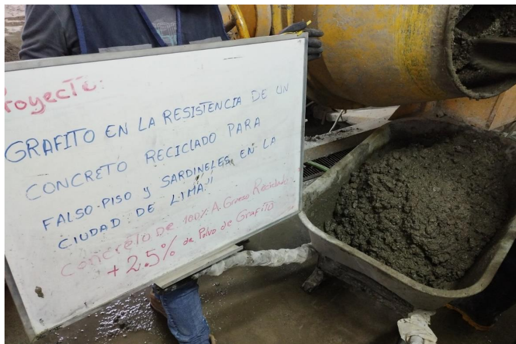
Fotografía N° 16: Mezcla del concreto con 2.5 de polvo de grafito
