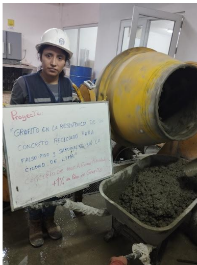
Figura N° 5. 37: Mezcla de concreto con 100% de Agregado Grueso Reciclado y la adición del 1% de polvo de grafito.
